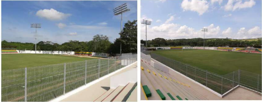
Foto 7 y 8 .Fotografías MINDEPORTE. Fuente: G.I.T Infraestructura, 2019
