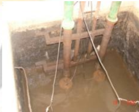
ADECUACIÓN SENSORES CUARTO DE BOMBAS
