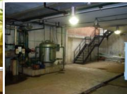
RECUPERACIÓN CUARTO DE MÁQUINAS Y FUNCIONAMIENTO DE CALDERAS
