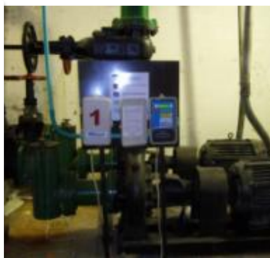
RECUPERACIÓN DE MOTOBOMBAS Y AUTOMATIZACIÓN DE ENCENDIDO Y NIVEL DE PRESIÓN
