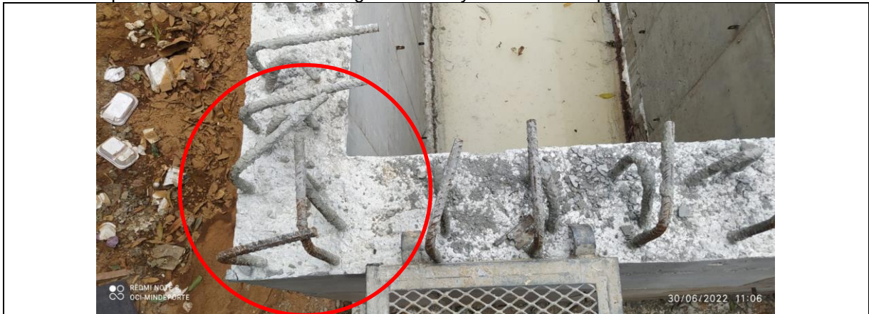
Foto 8. Tanque de Almacenamiento de Agua Potable y Cuarto de Máquinas
