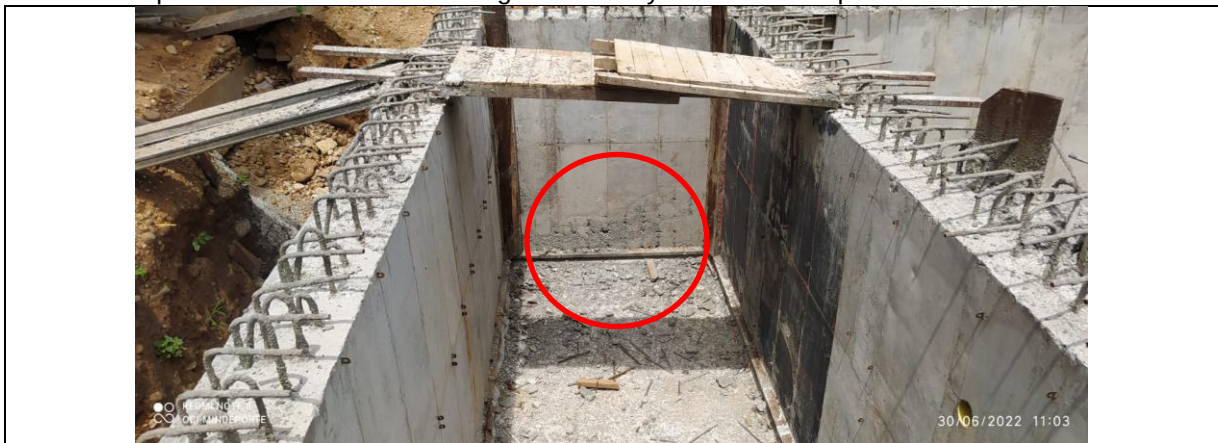
Foto 2. Tanque de Almacenamiento de Agua Potable y Cuarto de Máquinas
