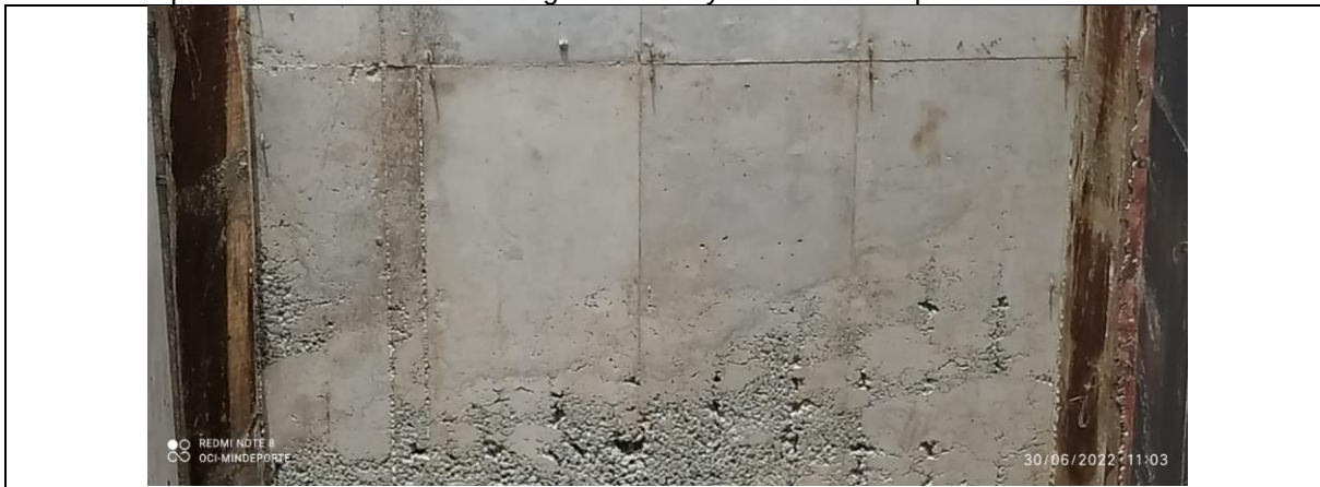
Foto 3. Tanque de Almacenamiento de Agua Potable y Cuarto de Máquinas
