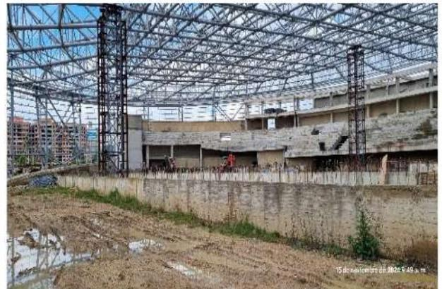
Muro perimetral pendiente fundida de vigas a apoyo de la pista. No se registra actividad.
