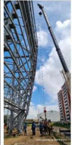
Izaje de estructura metálica de fachada.
