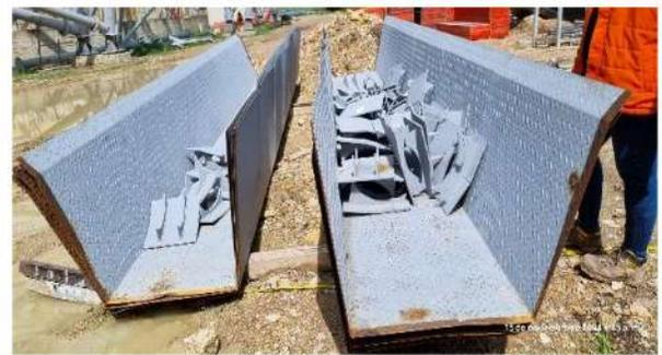
Canales desagüe cubierta lamina de alfiler para tránsito de mantenimiento en fachada.
