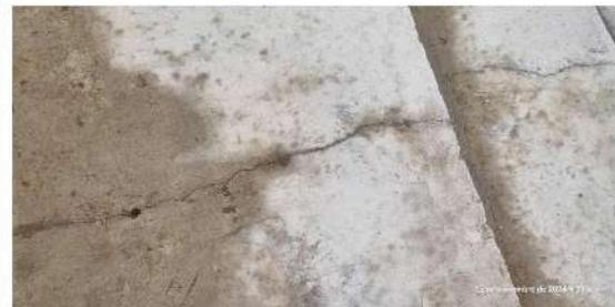
fisuras transversales en el concreto del área de graderías.
