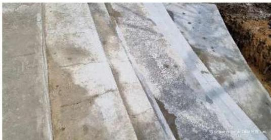
fisuras transversales en el concreto del área de graderías.
