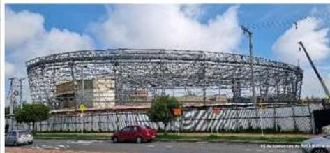
Izaje Estructura Metálica de Cubierta
