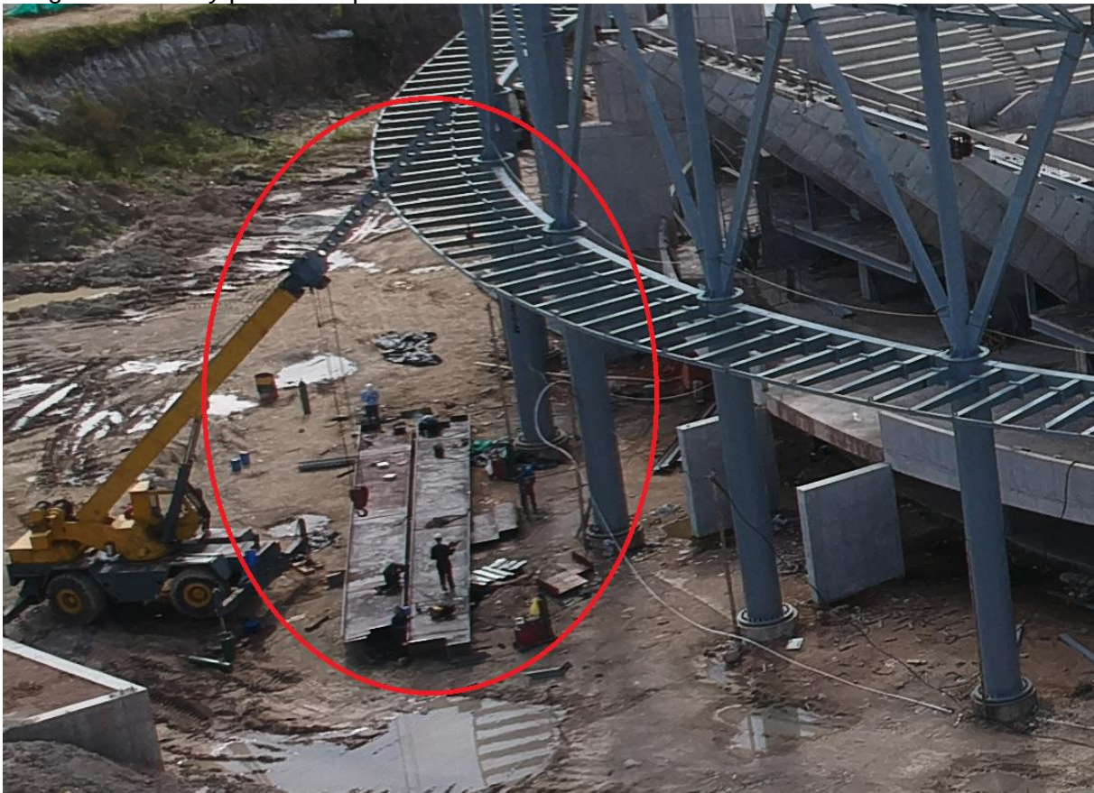
Imagen 5. Grúas y personal aparentemente subiendo elementos metálicos
