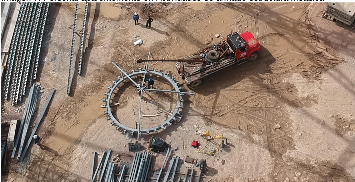
Imagen 7. Personal aparentemente en Actividades de armado estructura metálica
