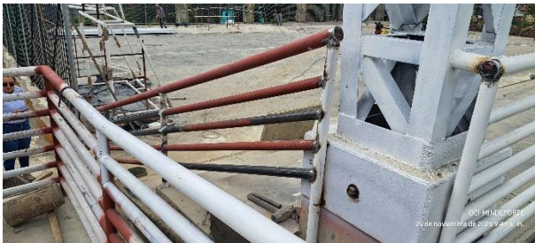
Instalación barandas accesos peatonales
