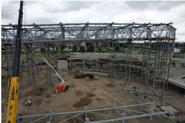
Izaje Estructura Metálica de Cubierta
