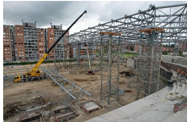
Izaje Estructura Metálica de Cubierta
