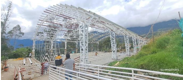
Estructura metálica de cubierta
