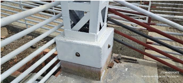
Instalación refuerzo anclaje estructura metálica
