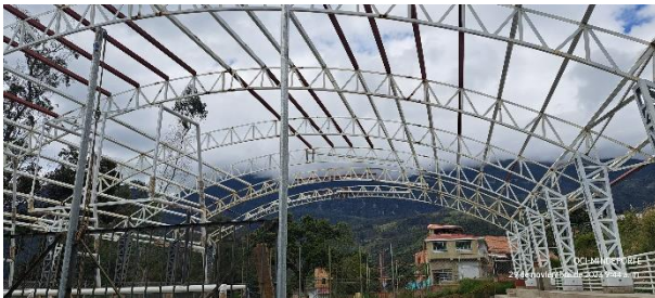
Estructura metálica de cubierta
