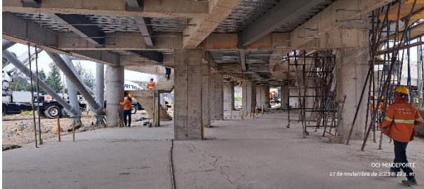
Estructura Gradería Velódromo
