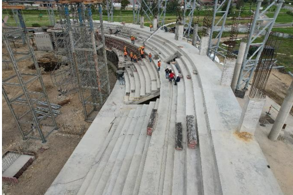
Construcción Graderías Velódromo
