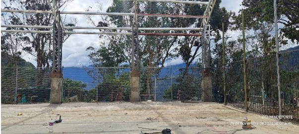
Instalación mallas cerramiento perimetral
