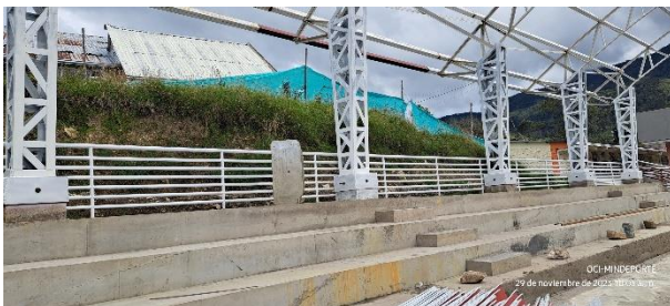
Gradería y columnas estructura metálica
