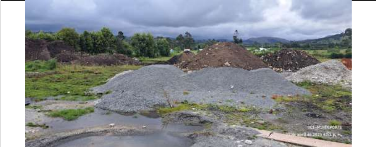
Foto 14. Mejoramiento del Estadio del Corregimiento de Chiles, municipio de Cumbal, departamento de Nariño.
