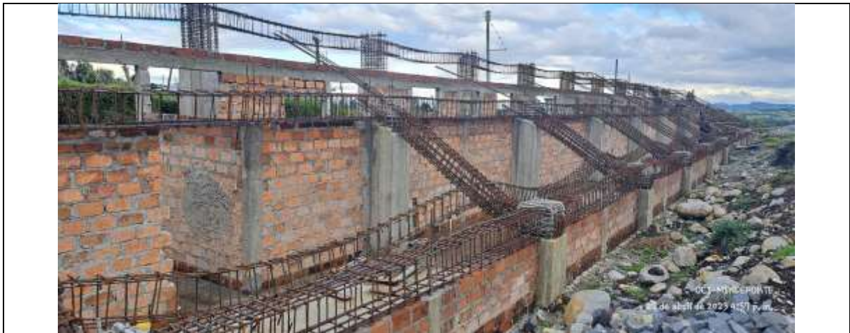
Foto 17. Mejoramiento del Estadio del Corregimiento de Chiles, municipio de Cumbal, departamento de Nariño.
