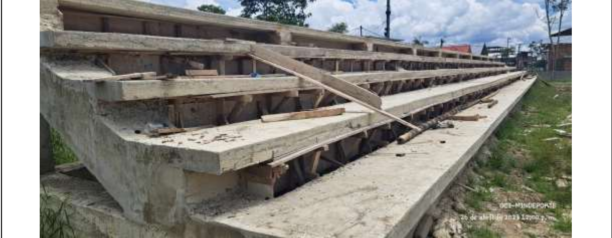
Foto 1. Construcción gradería Polideportivo de la Cabecera municipal – Olaya Herrera - Nariño
