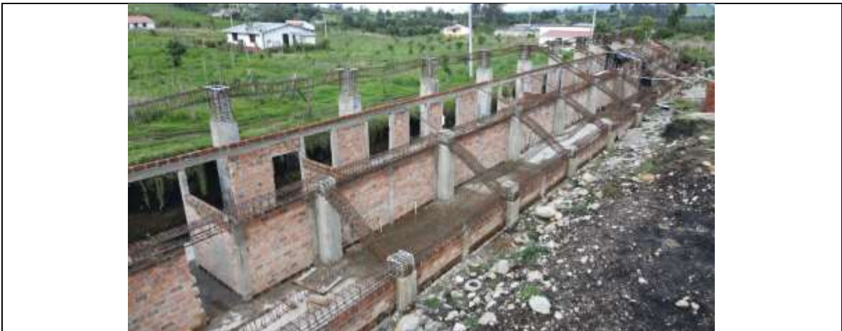
Foto 19. Mejoramiento del Estadio del Corregimiento de Chiles, municipio de Cumbal, departamento de Nariño.
