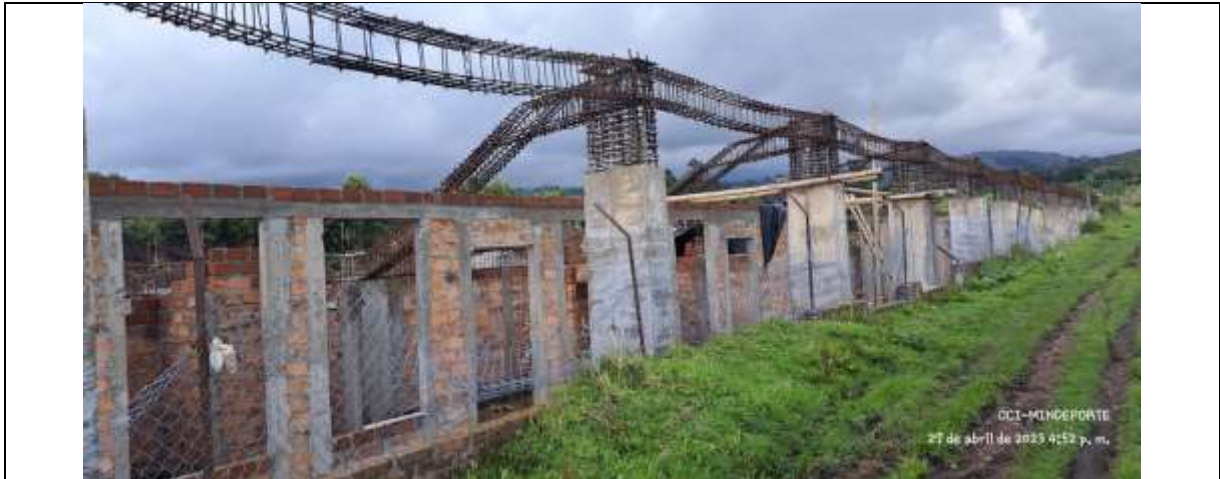
En la imagen se observa una vista general de la construcción de la gradería del Estadio por el costado posterior. Fuente: OCI Ministerio del Deporte
