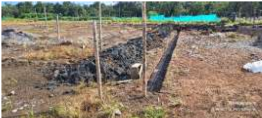
Construcción filtros cancha de fútbol – Francisco Pizarro
