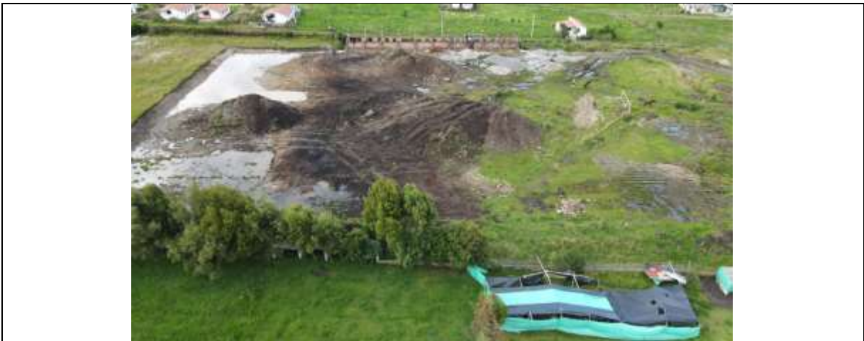
Foto 15. Mejoramiento del Estadio del Corregimiento de Chiles, municipio de Cumbal, departamento de Nariño.
