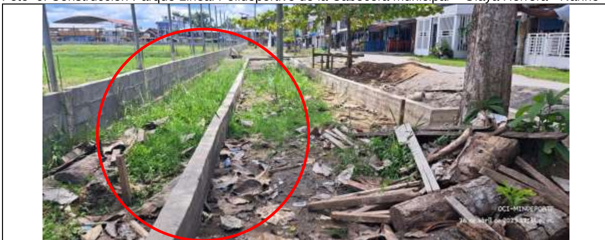
Foto 6. Construcción Parque Lineal Polideportivo de la Cabecera municipal – Olaya Herrera - Nariño
