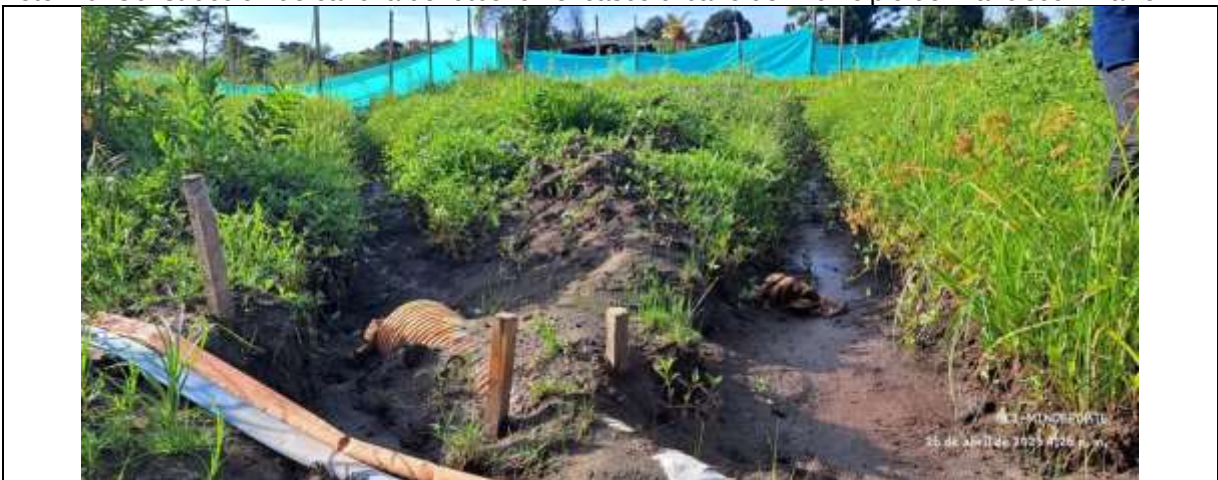
Foto 10. Construcción de cancha de fútbol en el casco urbano del municipio de Francisco Pizarro
