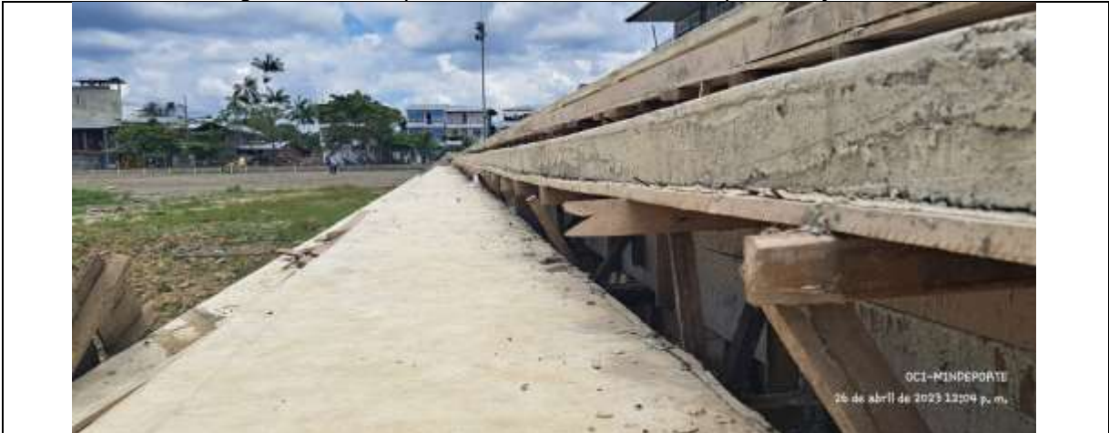
Foto 2. Construcción gradería Polideportivo de la Cabecera municipal – Olaya Herrera - Nariño
