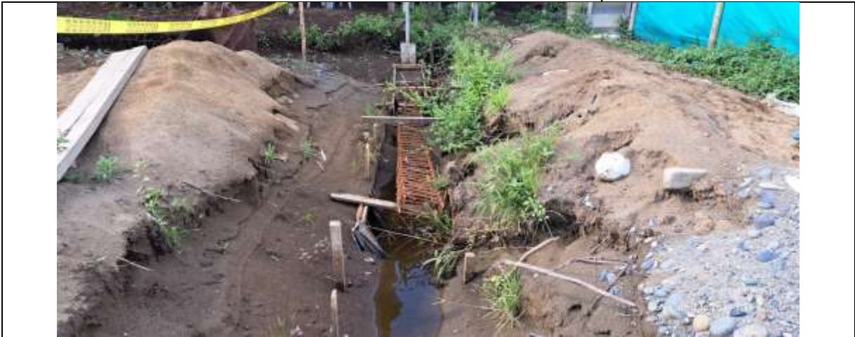
Foto 9. Construcción de cancha de fútbol en el casco urbano del municipio de Francisco Pizarro
