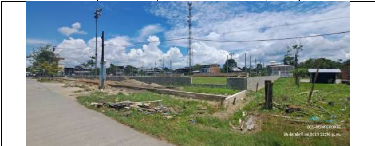
Foto 8. Construcción Parque Lineal Polideportivo de la Cabecera municipal – Olaya Herrera - Nariño
