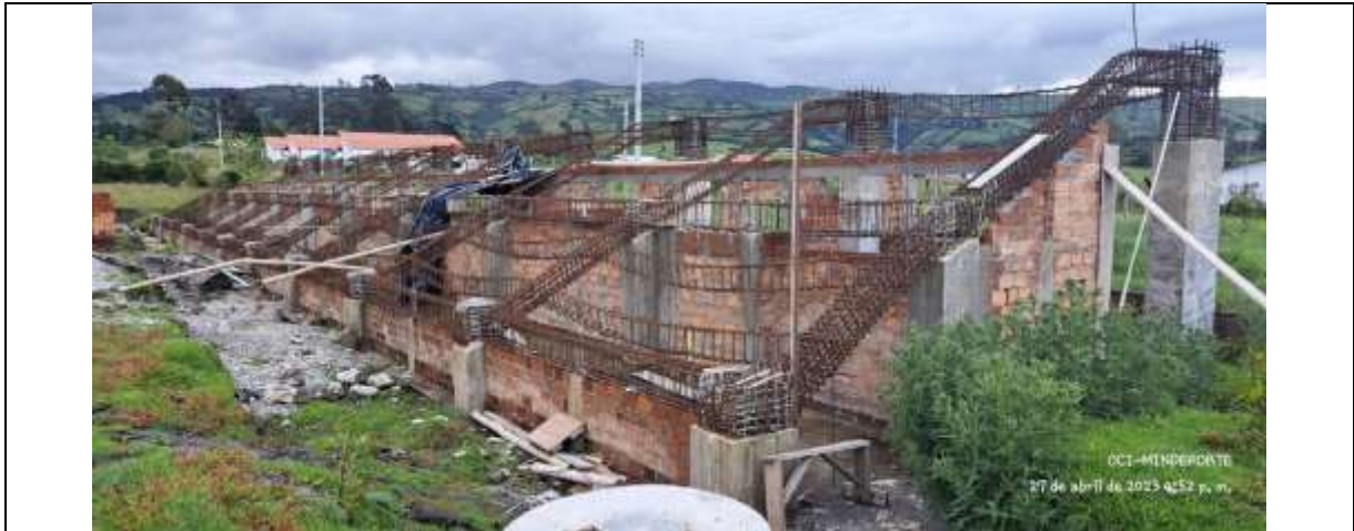
Foto 16. Mejoramiento del Estadio del Corregimiento de Chiles, municipio de Cumbal, departamento de Nariño.
