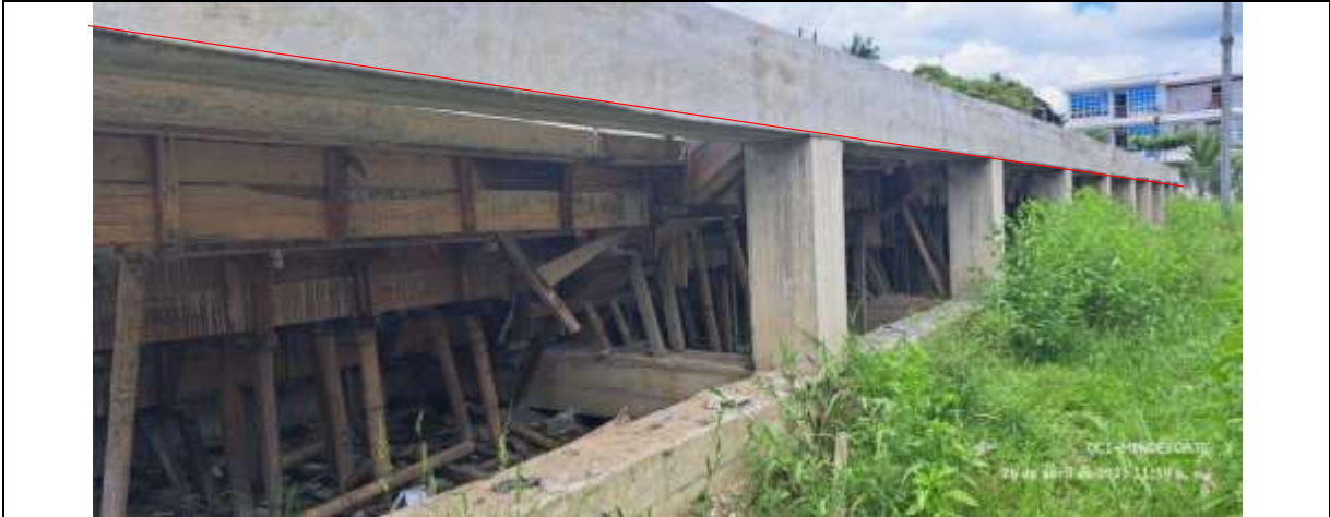
Foto 3. Construcción gradería Polideportivo de la Cabecera municipal – Olaya Herrera - Nariño
