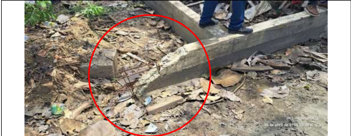
Foto 7. Construcción Parque Lineal Polideportivo de la Cabecera municipal – Olaya Herrera - Nariño
