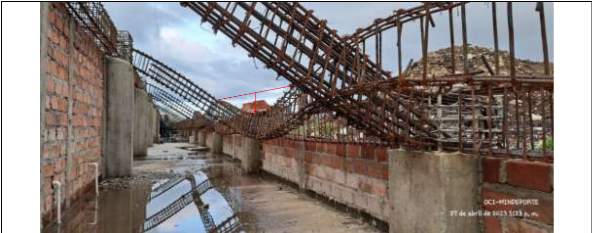
Foto 18. Mejoramiento del Estadio del Corregimiento de Chiles, municipio de Cumbal, departamento de Nariño.
