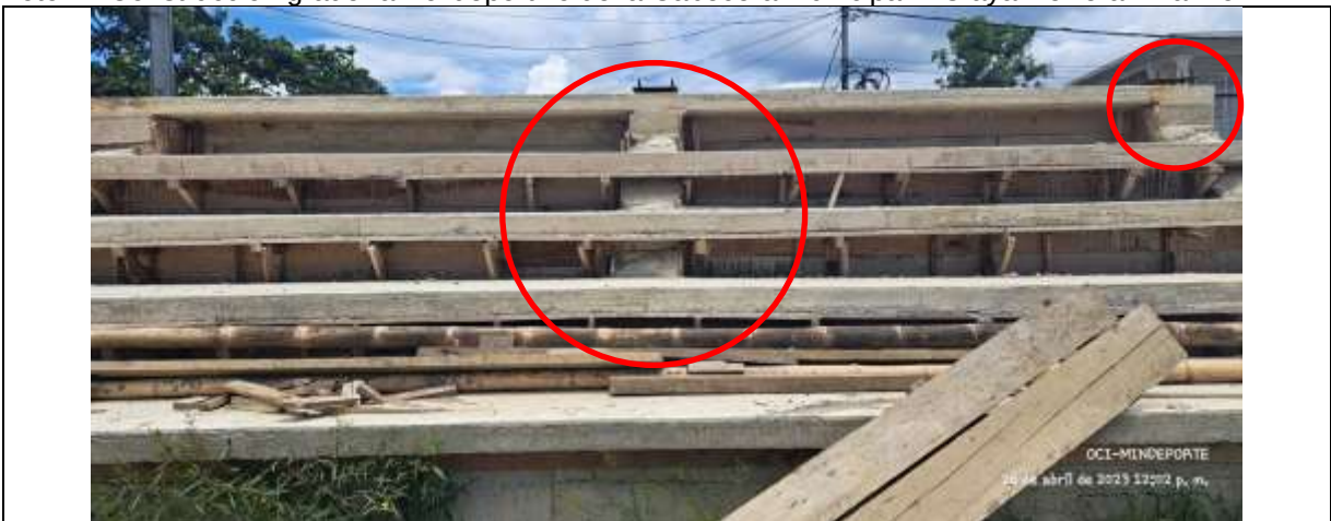
Foto 4. Construcción gradería Polideportivo de la Cabecera municipal – Olaya Herrera - Nariño
