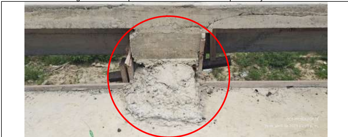
Foto 5. Construcción gradería Polideportivo de la Cabecera municipal – Olaya Herrera - Nariño
