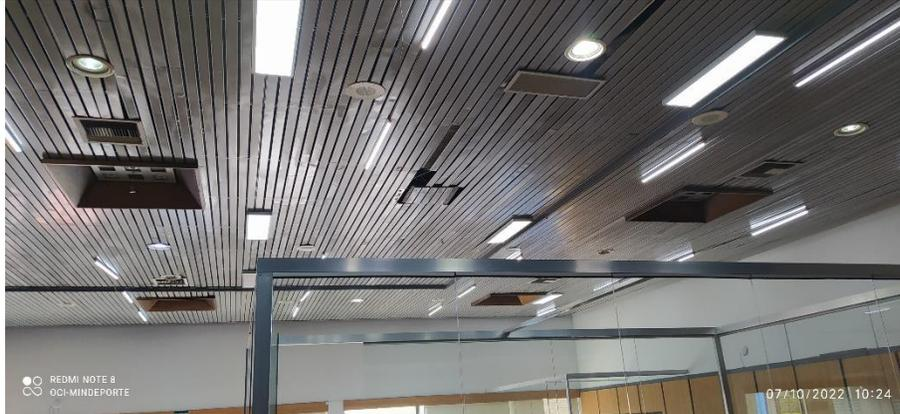
En la visita física realizada a la oficina en la cual opera las dependencias Dirección de Inspección Vigilancia y Control – IVC y la oficina Asesora de Planeación del Ministerio del Deporte, no se evidencias humedades en el techo derivadas de filtraciones de la cubierta.
