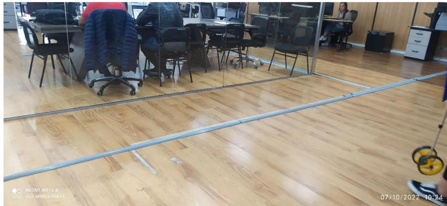
Se evidencias que se realizó la instalación de canaletas de piso, para la organización del cableado de red eléctrica y de datos.
