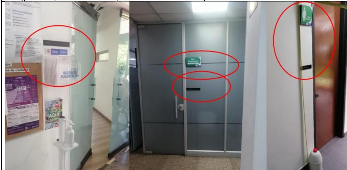
Se evidencia que las señales en los paneles de ascensores, los letreros de cubículos, las puertas de los baños públicos, entre otros, deben ser táctiles mediante realzado e incluir señalización Braille, no se guardan las mismas dimensiones para la instalación de las señalizaciones y no se cuenta con información audible.
