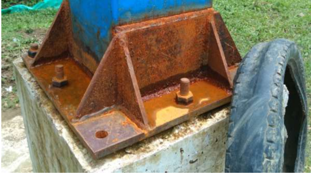
Foto 9. Calidad de la obra Convenio N°.1277 de 2020.
