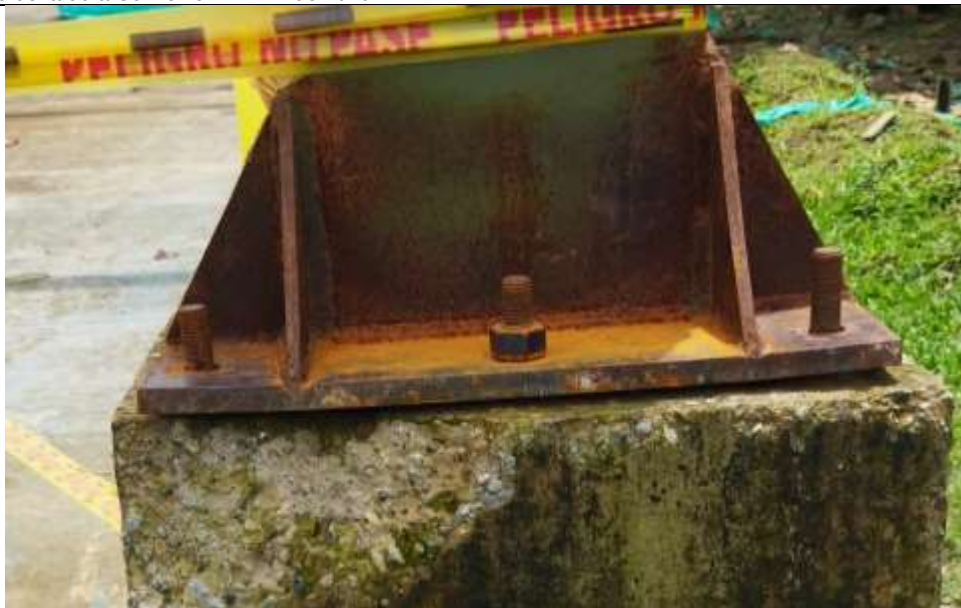
Foto 7. Calidad de la obra Convenio N°.1277 de 2020.
