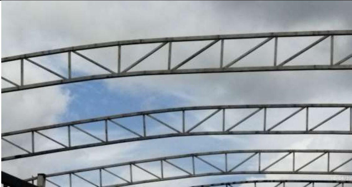
Foto 17. Calidad de la obra Convenio N°.1291 de 2020.
