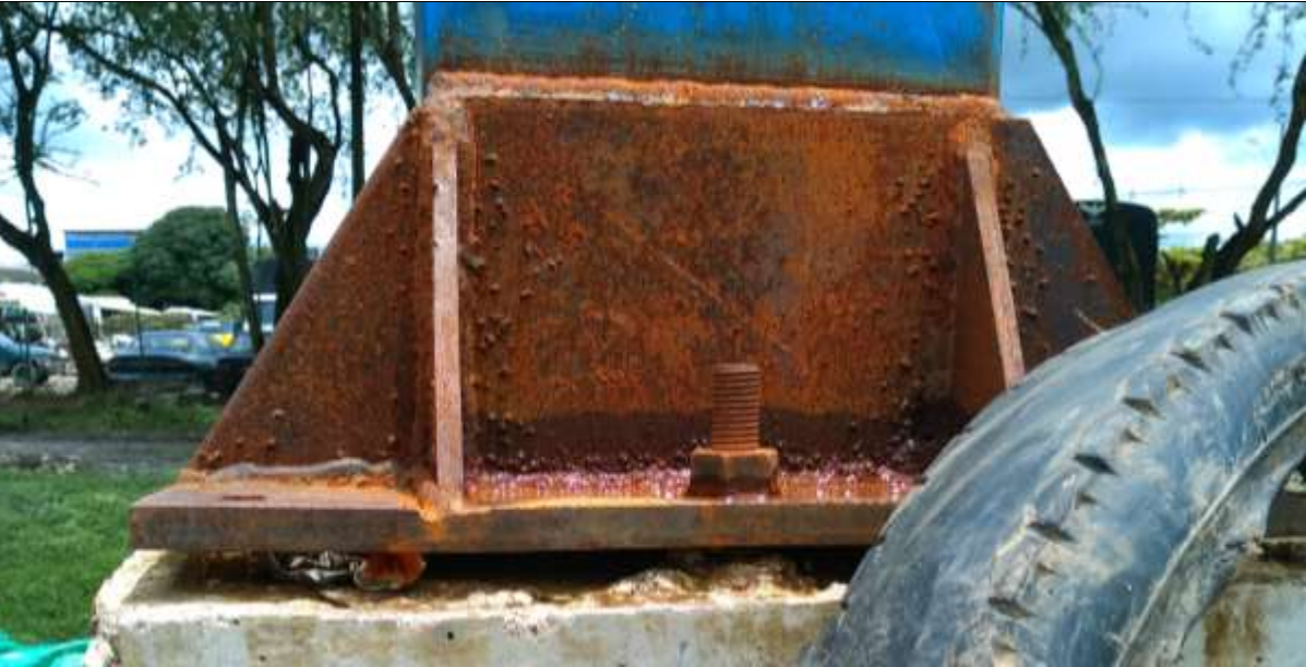
Foto 10. Calidad de la obra Convenio N°.1277 de 2020.
