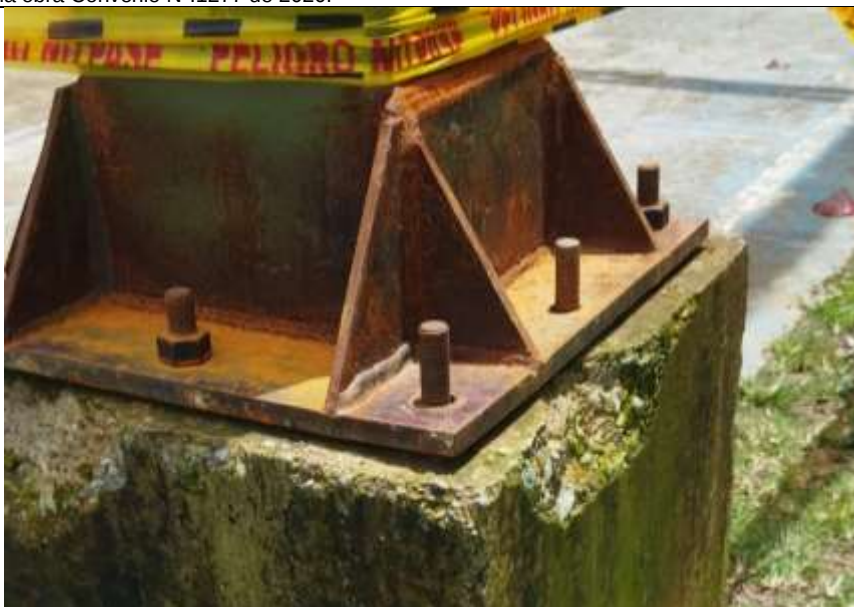
Foto 8. Calidad de la obra Convenio N°.1277 de 2020.
