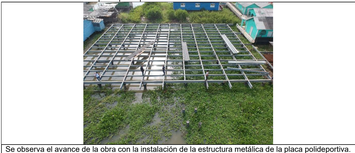
Foto 2. Estructura metálica placa polideportiva
