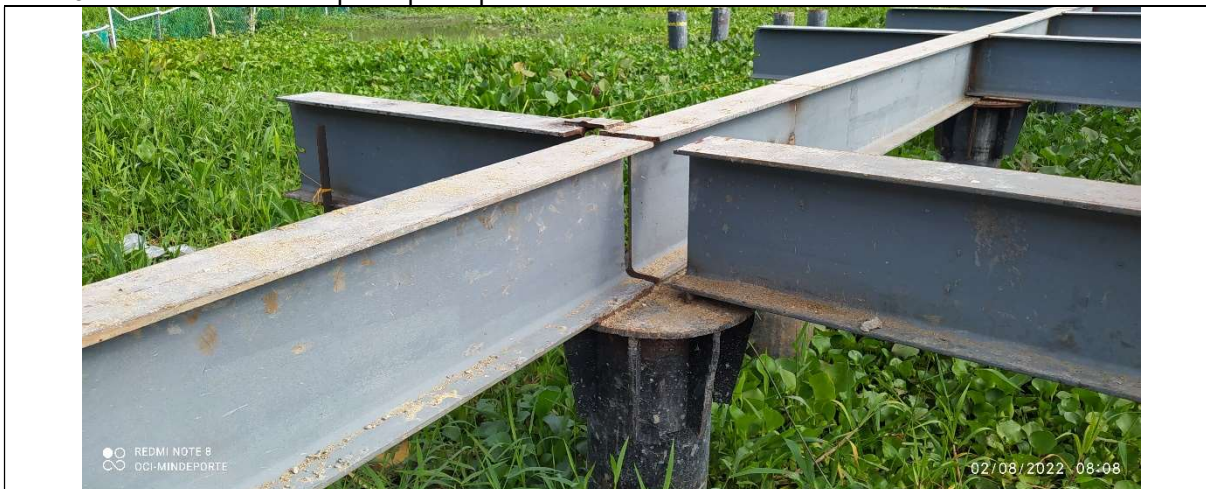
Foto 3. Estructura metálica placa polideportiva
