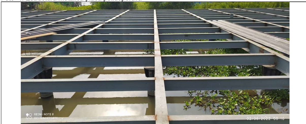
Foto 4. Estructura metálica placa polideportiva
