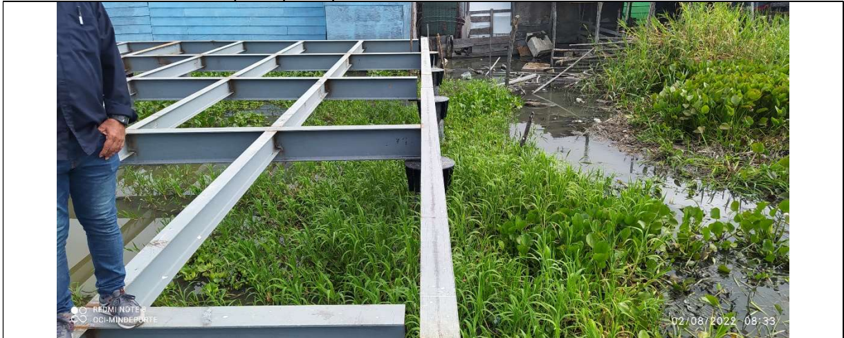
Foto 5. Estructura metálica placa polideportiva
