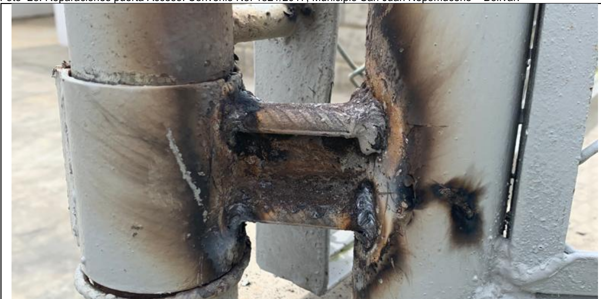
Foto 28. Reparaciones puerta Acceso. Convenio No. 1321/2017, Municipio San Juan Nepomuceno – Bolívar.
