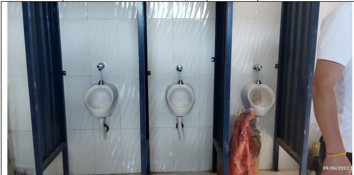
Foto 10. Instalación aparatos sanitarios. Convenio No. 1252/2020, Municipio de María la Baja – Bolívar.
