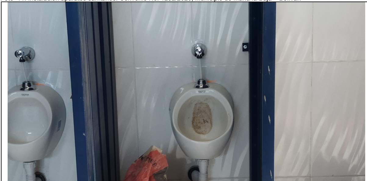
Foto 11. Instalación aparatos sanitarios. Convenio No. 1252/2020, Municipio de María la Baja – Bolívar.
