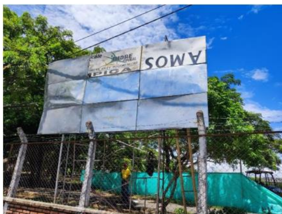
Imagen 7. Instalación láminas soporte para valla.
