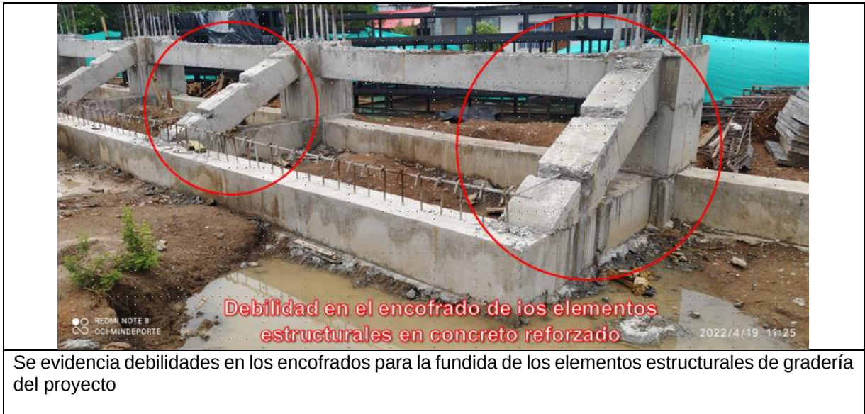
Foto 12. Encofrado elementos estructurales
