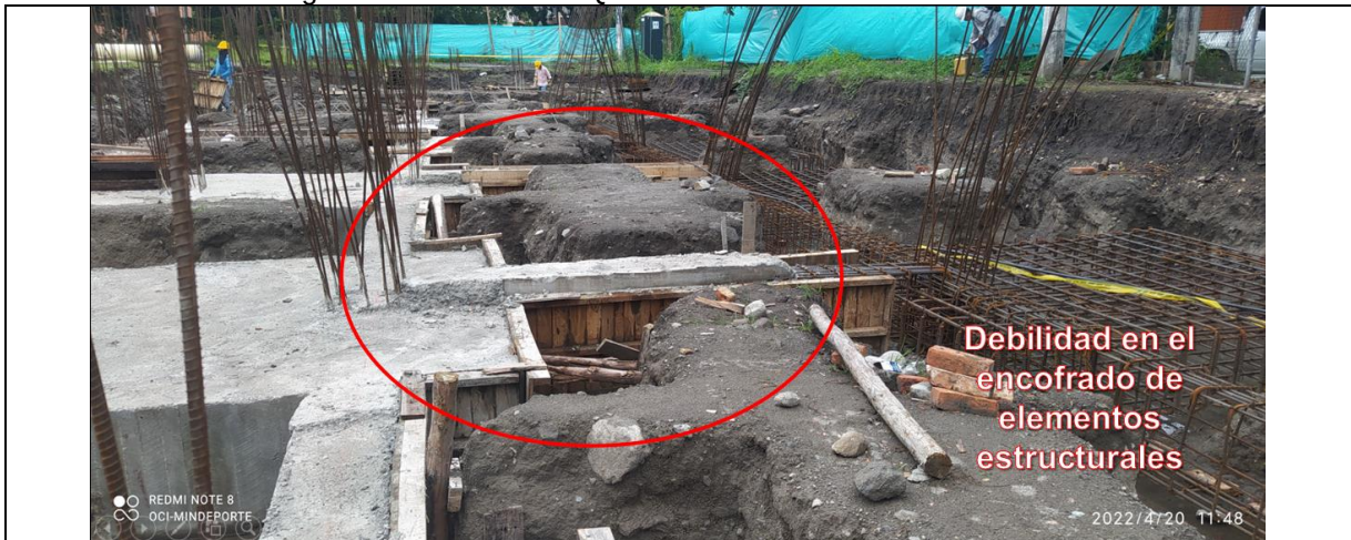
Foto 16. Cimentación gradería Cancha Las Quintas
