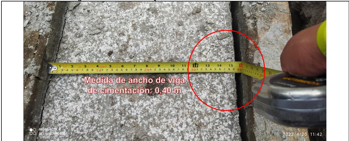
Foto 19. Cimentación gradería Cancha Las Quintas
