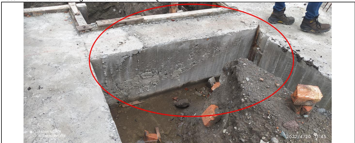
Foto 20. Cimentación gradería Cancha Las Quintas
