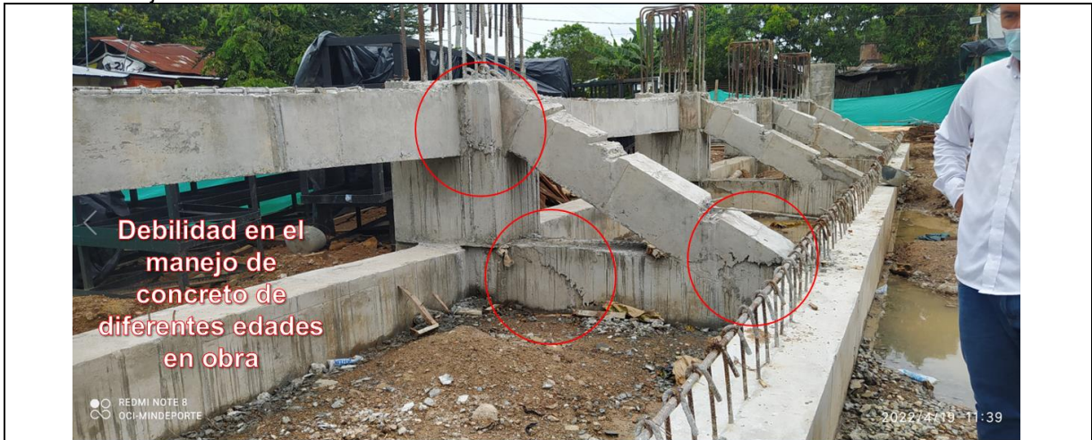
Foto 9. Manejo concreto de diferentes edades
