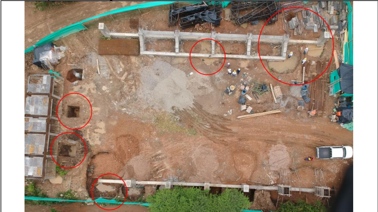
Foto 10. Empozamiento de agua en zonas de la obra
