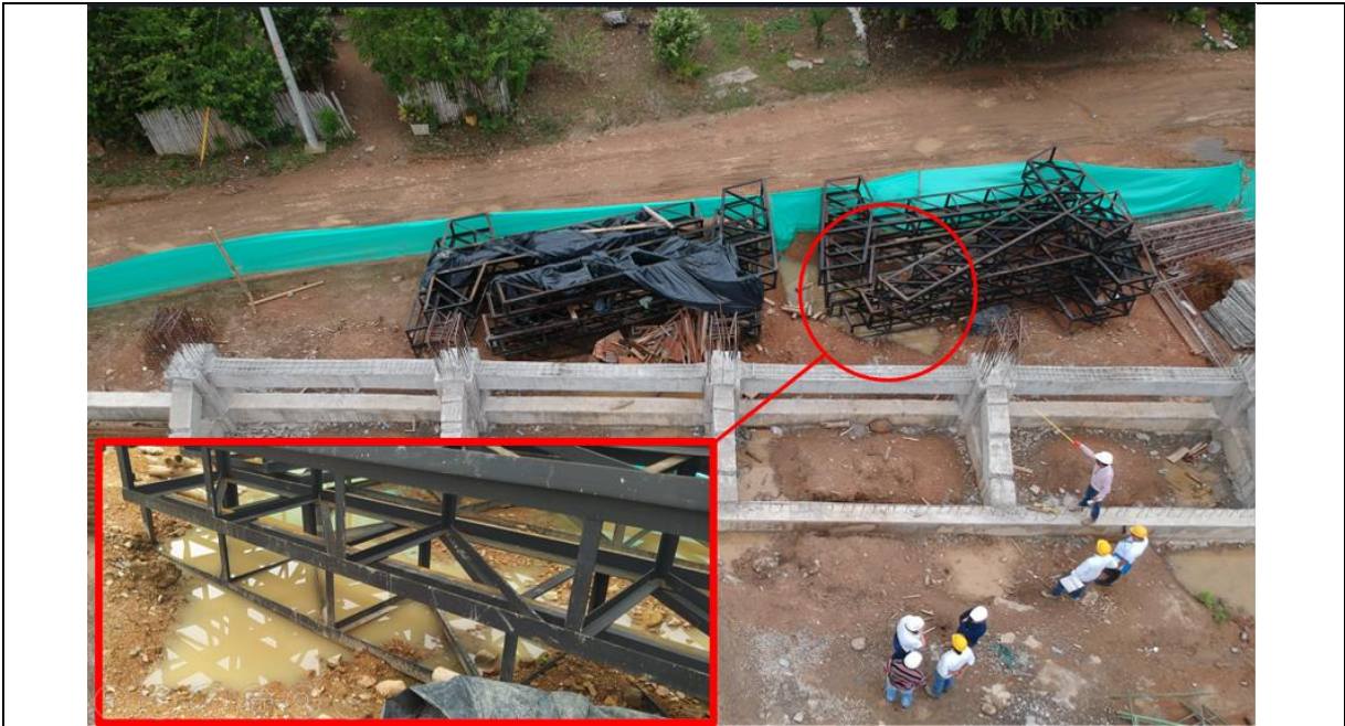
Foto 6. Almacenamiento de materiales convenio 1253/2020
