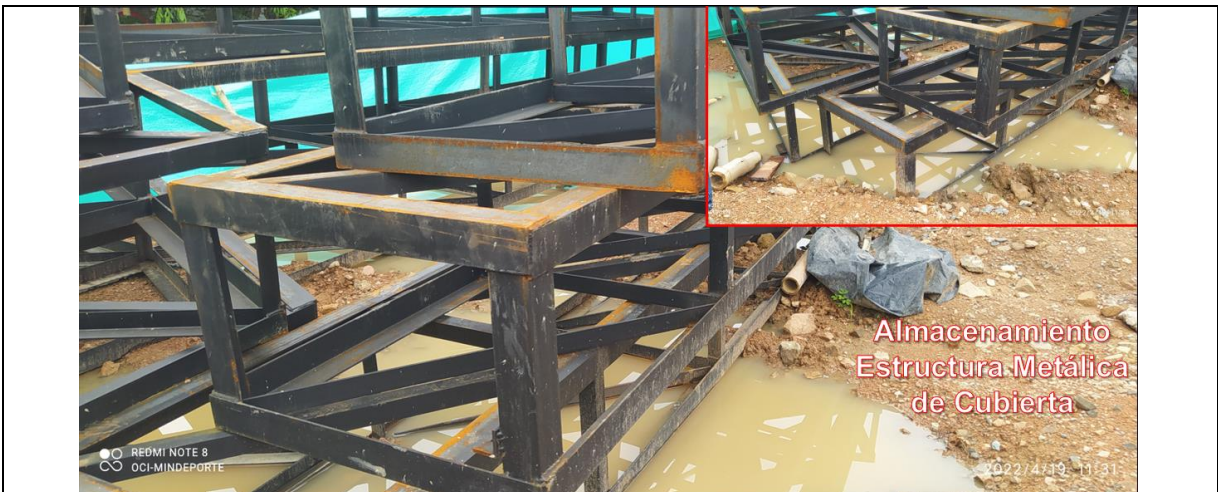
Foto 7. Almacenamiento de materiales convenio 1253/2020
