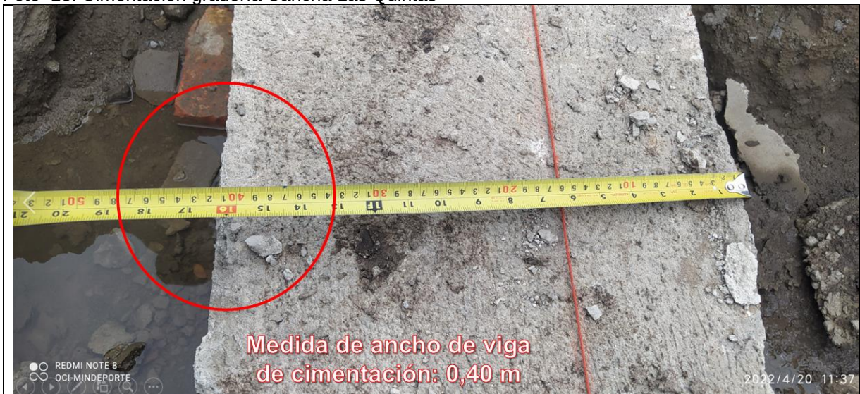
Foto 18. Cimentación gradería Cancha Las Quintas
