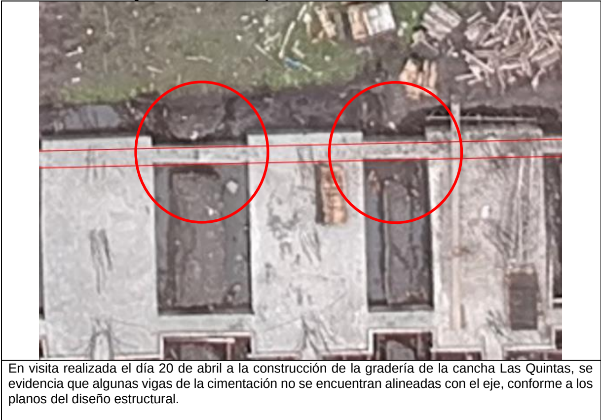
Foto 24. Cimentación gradería Cancha Las Quintas
