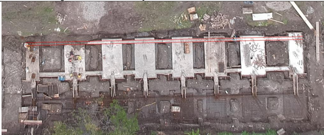
Foto 23. Cimentación gradería Cancha Las Quintas
