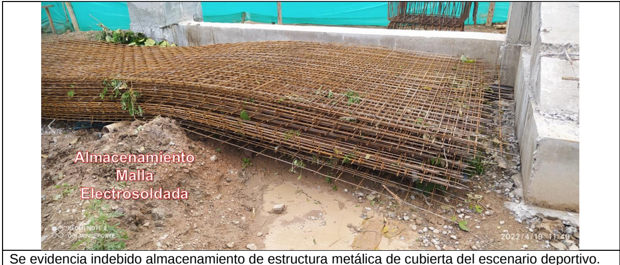
Foto 8. Almacenamiento de materiales convenio 1253/2020
