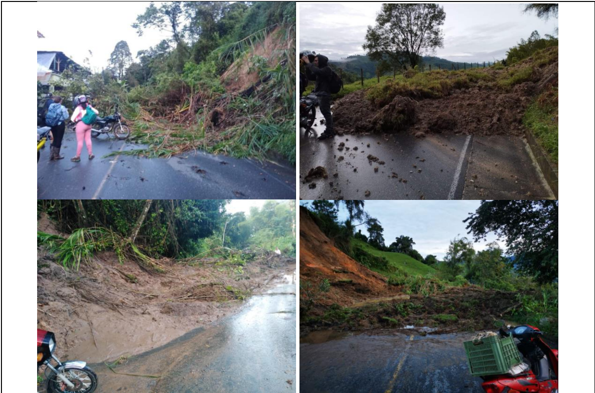
Foto 21. Estado vía Manizales - Pácora
