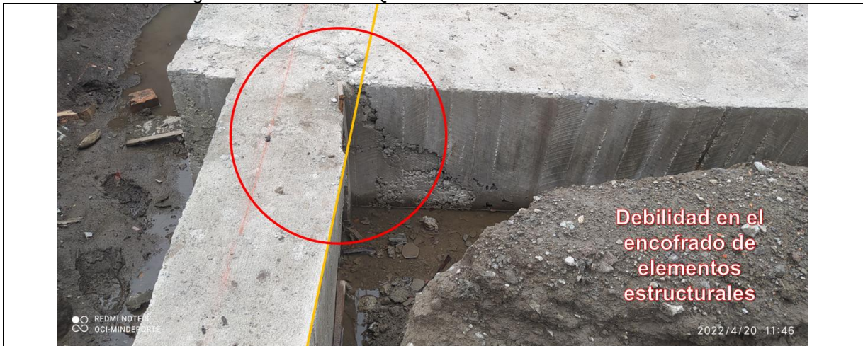
Foto 15. Cimentación gradería Cancha Las Quintas
