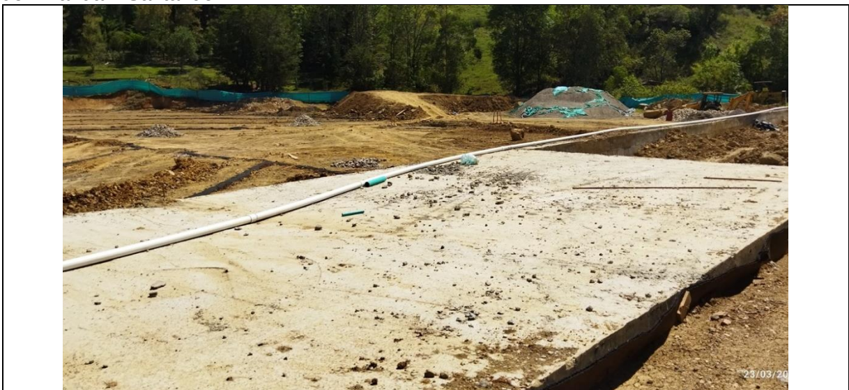
Foto 14. Área placa aérea aligerada en concreto Convenio No. 1238/2020, Municipio San José de Miranda – Santander
