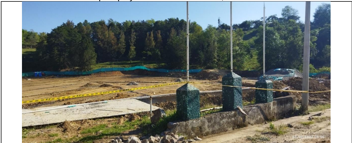
Foto 28. Revisión Técnica para proyectos de infraestructura, San José de Miranda - Santander.
