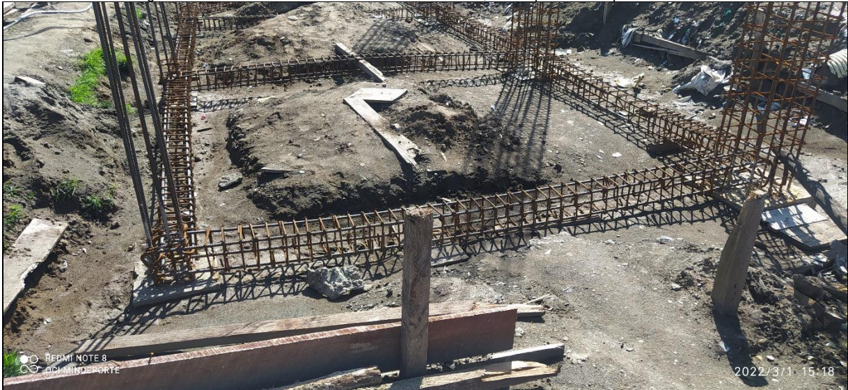
Foto 3.. Cimentación gradería cancha de futbol Convenio No. 1298/2020, Municipio de Mosquera – Nariño
