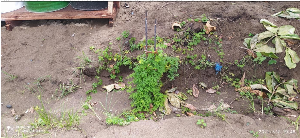
Foto 12. Cerramiento Perimetral Cancha Convenio No. 1254/2020, Municipio de Tumaco – Nariño
