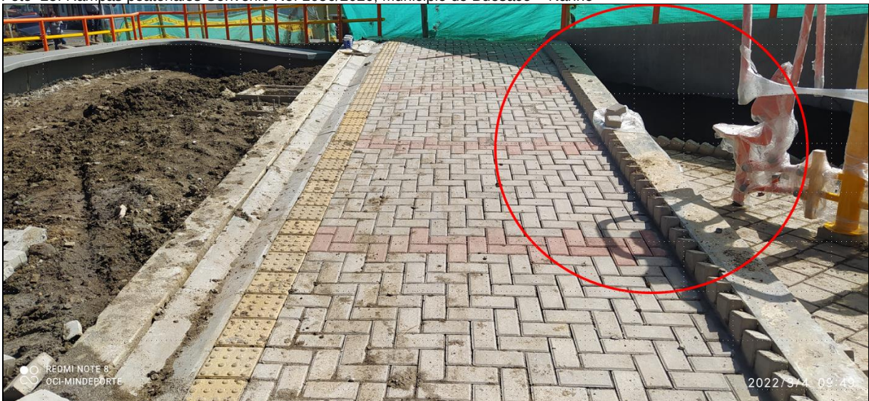
Foto 25. Rampas peatonales Convenio No. 1056/2020, Municipio de Buesaco – Nariño
