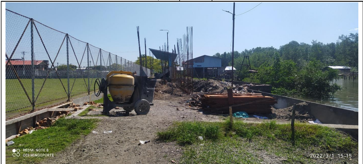
Foto 2. Cerramiento de Obra Convenio No. 1298/2020, Municipio de Mosquera – Nariño
