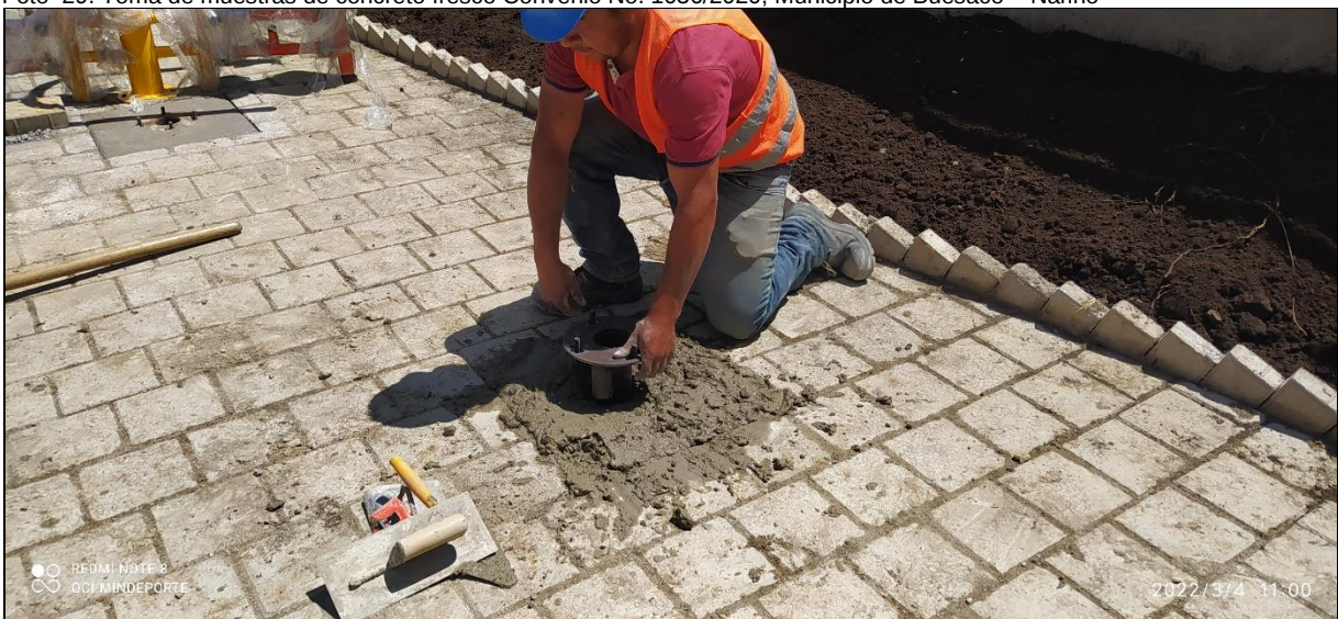
Foto 29. Toma de muestras de concreto fresco Convenio No. 1056/2020, Municipio de Buesaco – Nariño
