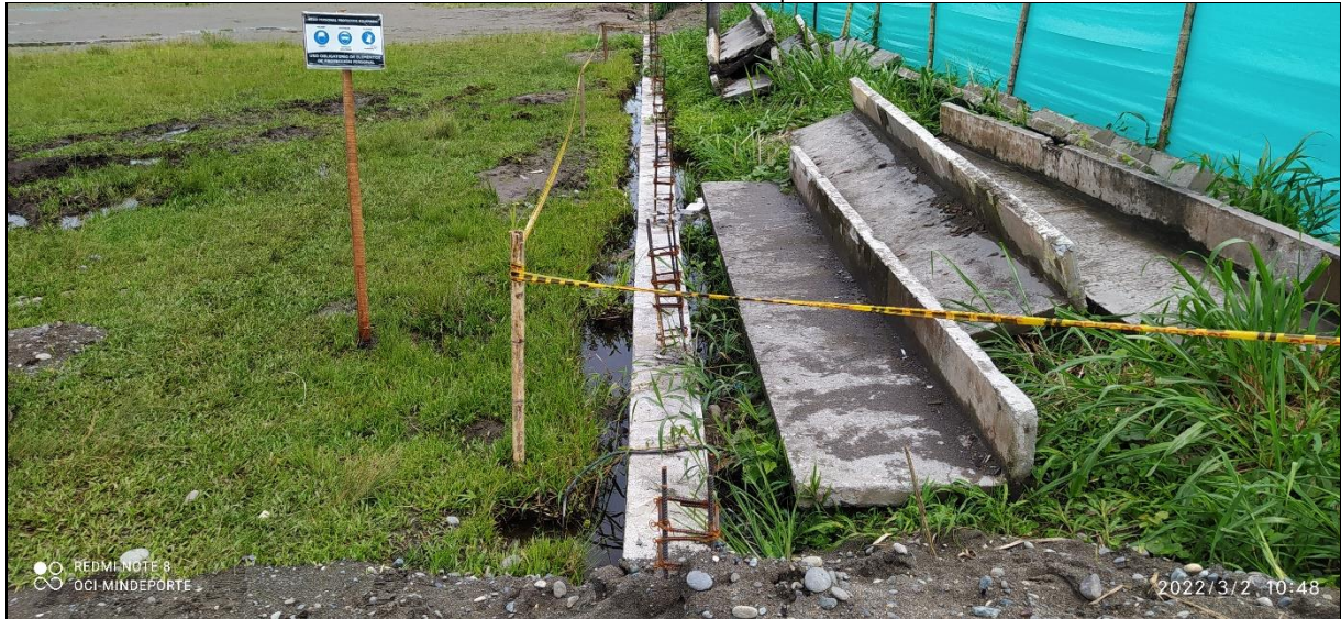
Foto 15. Cerramiento Perimetral Cancha Convenio No. 1254/2020, Municipio de Tumaco – Nariño
