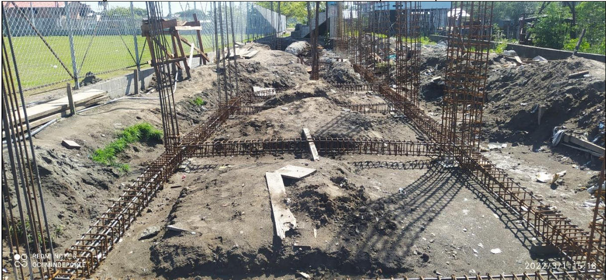
Foto 5. Cimentación gradería cancha de futbol Convenio No. 1298/2020, Municipio de Mosquera – Nariño
