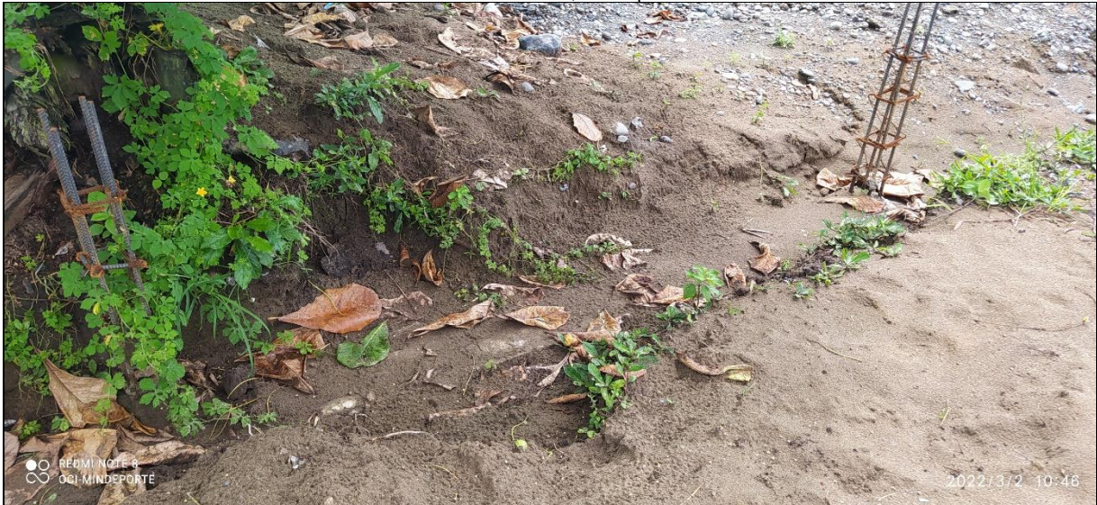
Foto 13. Cerramiento Perimetral Cancha Convenio No. 1254/2020, Municipio de Tumaco – Nariño
