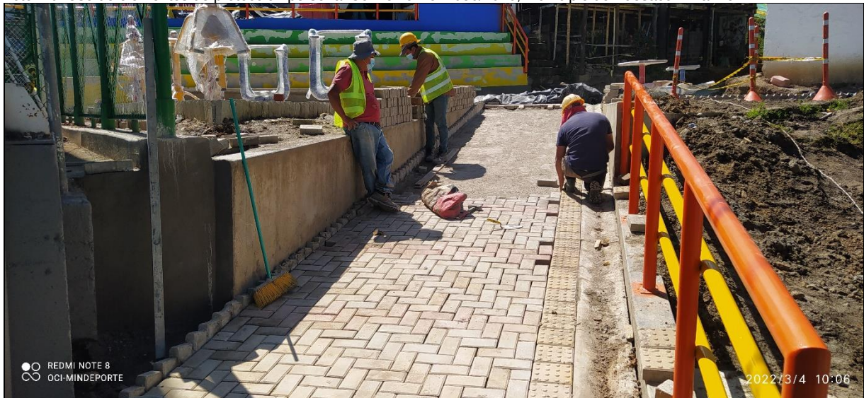
Foto 26. Uso de elementos de protección personal Convenio No. 1056/2020, Municipio de Buesaco – Nariño
