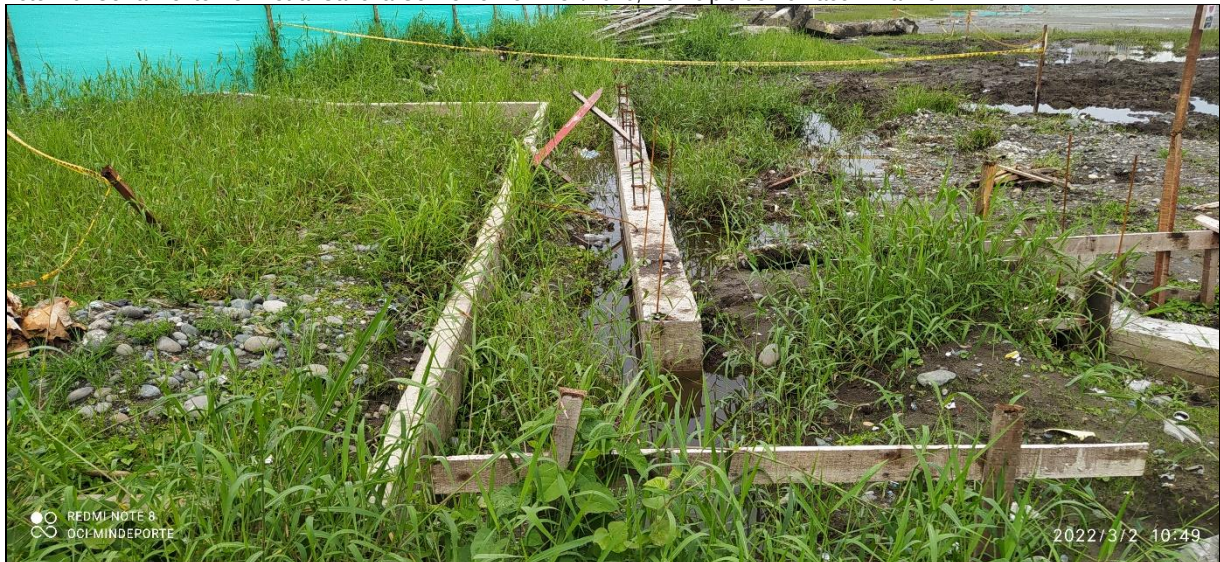
Foto 16. Cerramiento Perimetral Cancha Convenio No. 1254/2020, Municipio de Tumaco – Nariño
