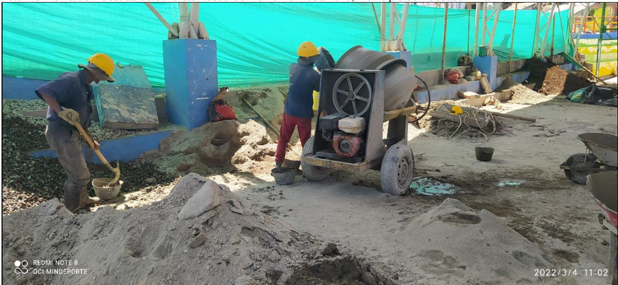
Foto 28. Toma de muestras de concreto fresco Convenio No. 1056/2020, Municipio de Buesaco – Nariño
