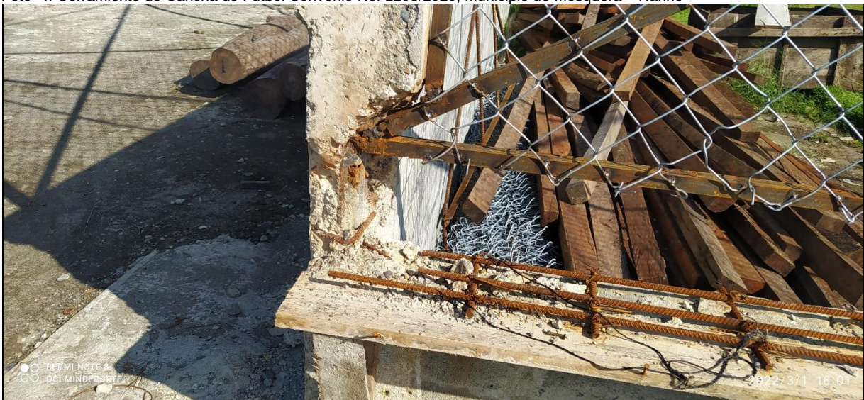
Foto 4. Cerramiento de Cancha de Futbol Convenio No. 1298/2020, Municipio de Mosquera – Nariño
