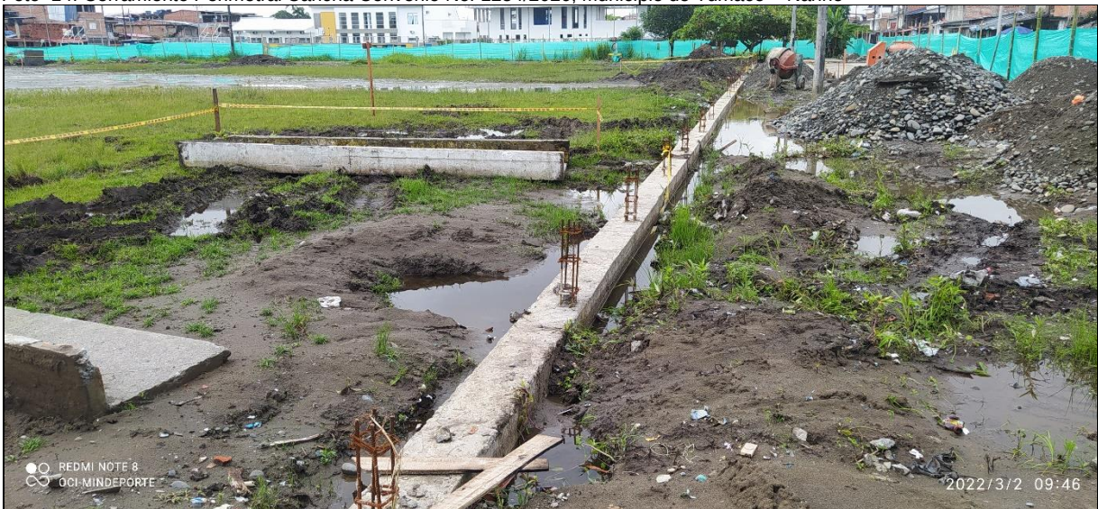
Foto 14. Cerramiento Perimetral Cancha Convenio No. 1254/2020, Municipio de Tumaco – Nariño
