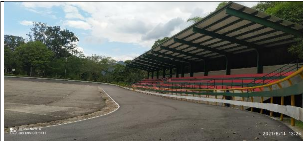
Foto No. 23. Estado Actual Construcción de gradería cubierta en Pista de Patinaje del Centro Deportivo Guatiguara del municipio de Piedecuesta Santander
