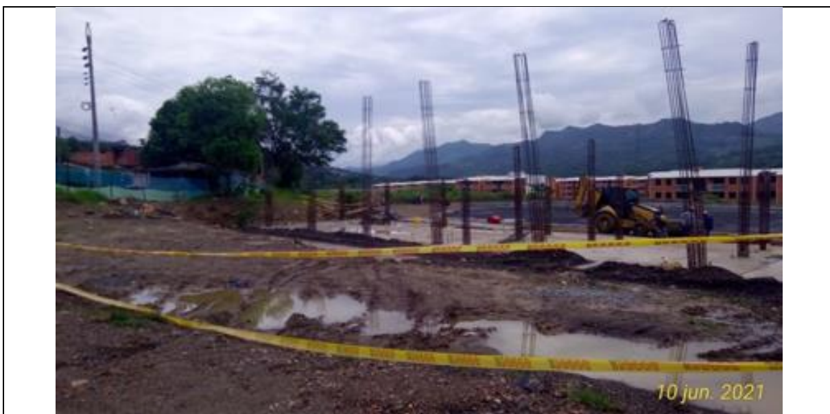
Foto No. 2. Evidencia de estado actual de la obra, acceso hacia pista. - OCI 10/06/2021
