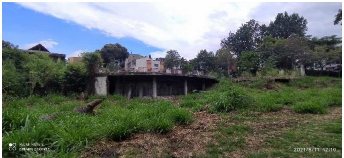
Foto No. 31. Estado Actual del predio para la Construcción del centro deportivo acuático de alto rendimiento del municipio de Piedecuesta, Santander.
