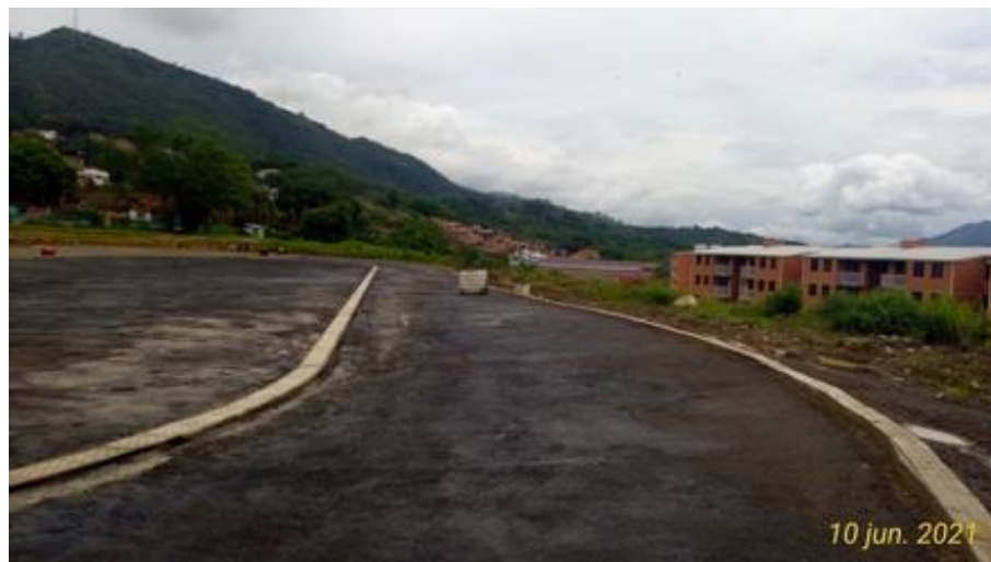
Foto No. 6. Evidencia de estado actual de la obra, pista de velocidad, sardinel perimetral externo, cárcamo perimetral interno y pista central. OCI 10/06/2021
