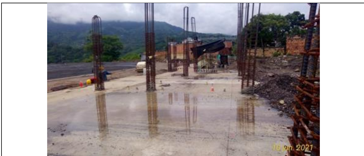
Foto No. 4. Evidencia de estado actual de la obra y en el que será entregado el área de cimentación graderías. - OCI 10/06/2021
