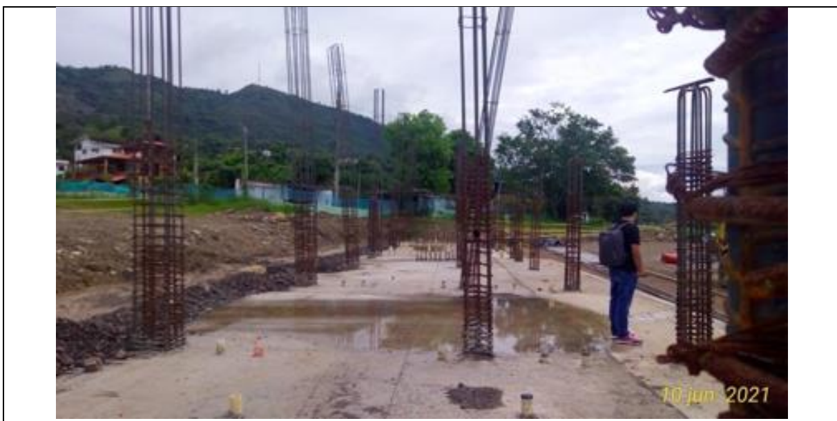
Foto No. 3. Evidencia Zona de graderías, de acuerdo a información suministrada por el residente interventor y funcionarios de la oficina de planeación es el estado proyectado de entrega es el evidenciado en registro fotográfico. - OCI 10/06/2021
