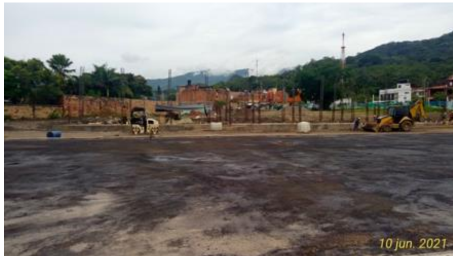
Foto No. 5. Evidencia de estado actual de la obra, pista central y cimentación de graderías y bloque administrativo y de servicios complementarios a la pista. - OCI 10/06/2021
