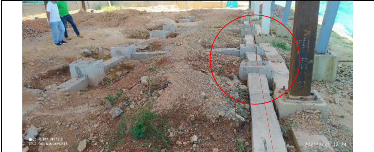
Foto 3. Construcción cimentación gradería Coliseo de halterofilia
