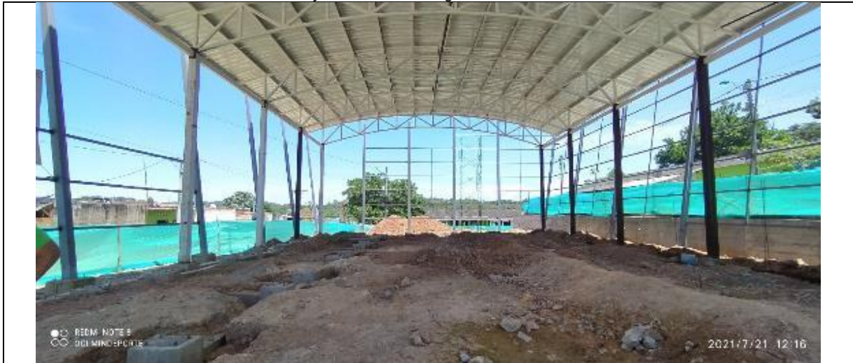
Foto 1. Construcción Cubierta, fachadas y cimentación de gradería Coliseo de halterofilia
