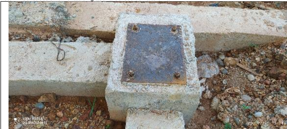
Foto 7. Construcción cimentación gradería Coliseo de halterofilia
