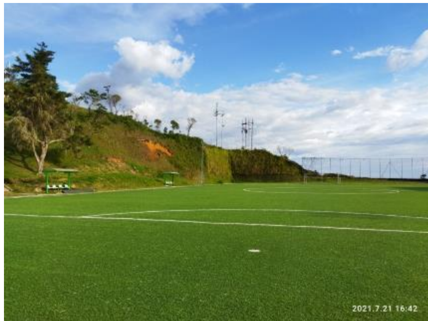
Cancha de Fútbol Centro de Rendimiento Deportivo de La Merced, Caldas, estado actual de grama sintética
