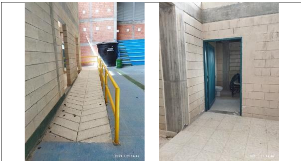
Coliseo Cubierto Del Municipio De Salamina. se evidencia rampa de acceso y baños para Personas con Movilidad Reducida con elementos de apoyo
