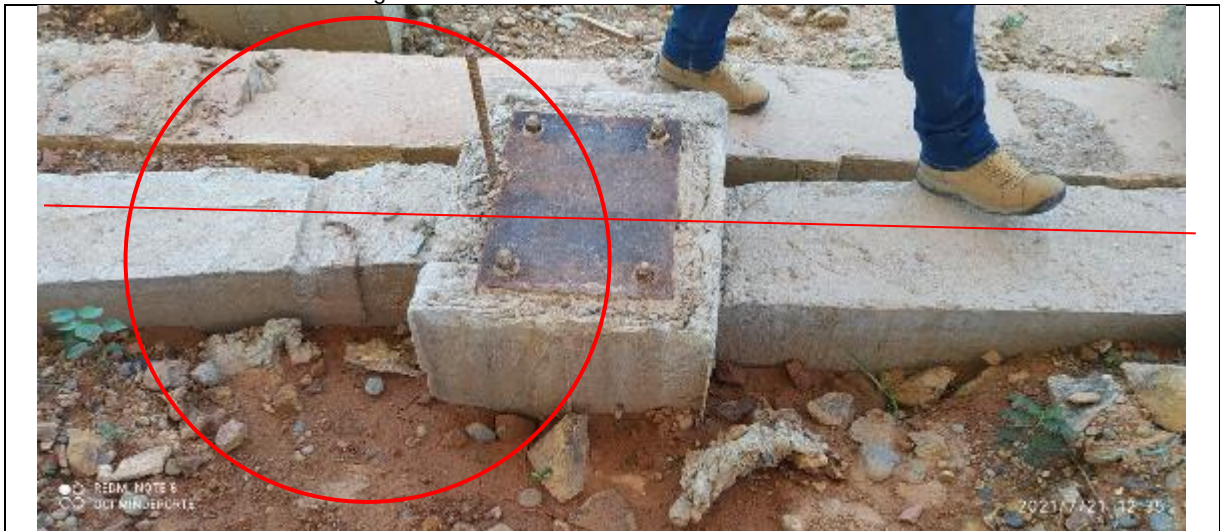
Foto 4. Construcción cimentación gradería Coliseo de halterofilia
