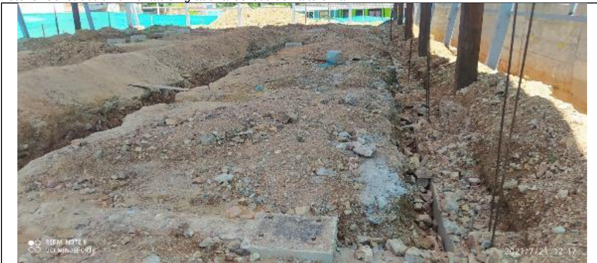
Foto 5. Construcción cimentación gradería Coliseo de halterofilia
