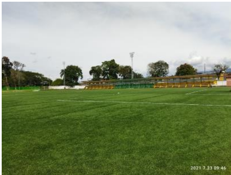
Unidad Deportiva Estadio Municipal Etapa 1 La Virginia, Risaralda
