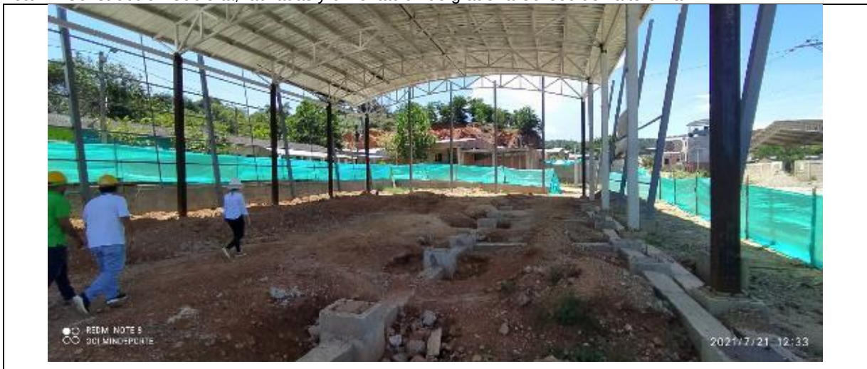
Foto 2. Construcción Cubierta, fachadas y cimentación de gradería Coliseo de halterofilia
