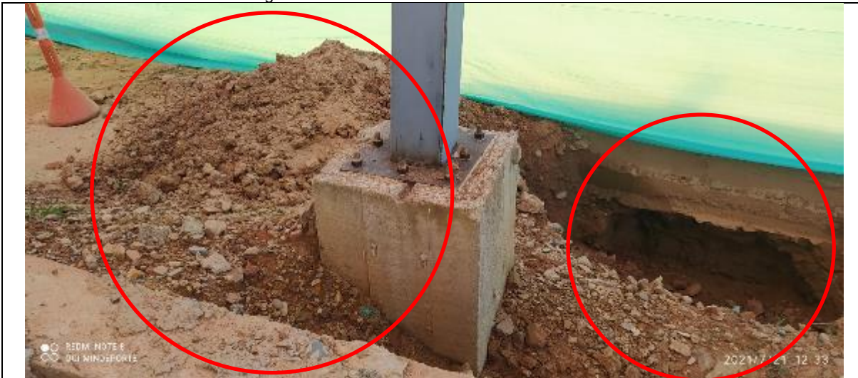
Foto 6. Construcción cimentación gradería Coliseo de halterofilia
