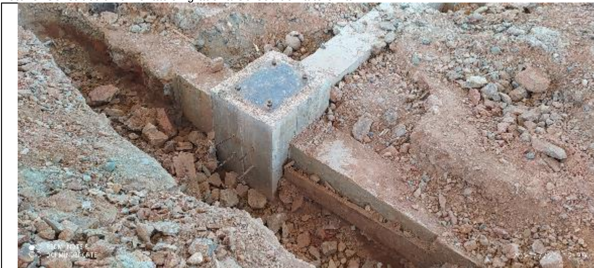
Foto 8. Construcción cimentación gradería Coliseo de halterofilia
