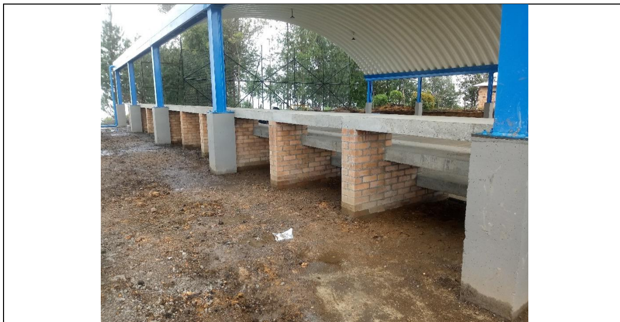
Foto N°8, graderías parte posterior, Foto: equipo auditor Oficina de Control Interno 12-05-2019
