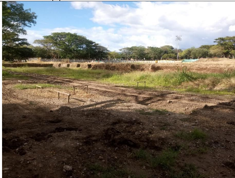
Foto N°20, Área de cimentación gradería occidental. Foto: equipo auditor Oficina de Control Interno. 13-06-2019.
