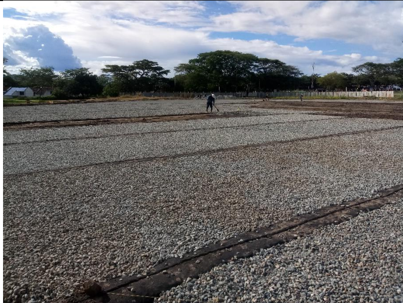
Foto N°19, sistema de drenaje para grama natural, cancha de futbol. Foto: equipo auditor Oficina de Control Interno. 13-06-2019
