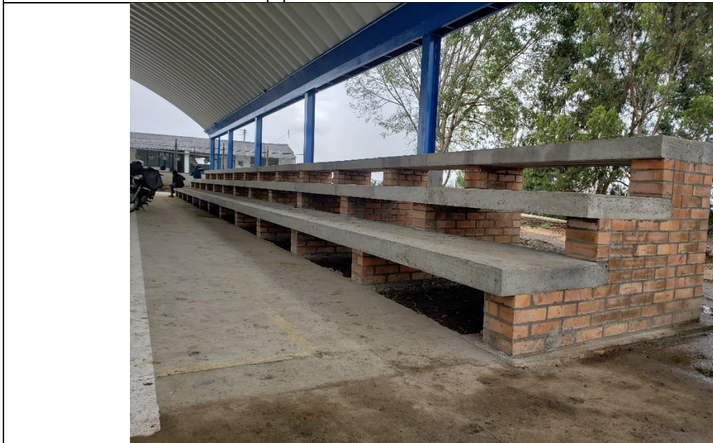
Foto N°7A, graderías. Foto: equipo auditor Oficina de Control Interno. 12-06-2019
