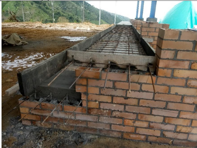
Foto N°13, graderías en construcción. Foto: equipo auditor Oficina de Control Interno. 12-06-2019
