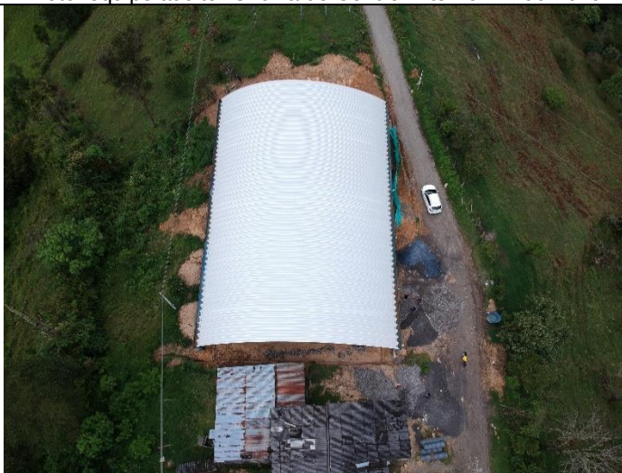
Foto N°15, vista aérea cubierta. Foto: equipo auditor Oficina de Control Interno. 12-06-2019
