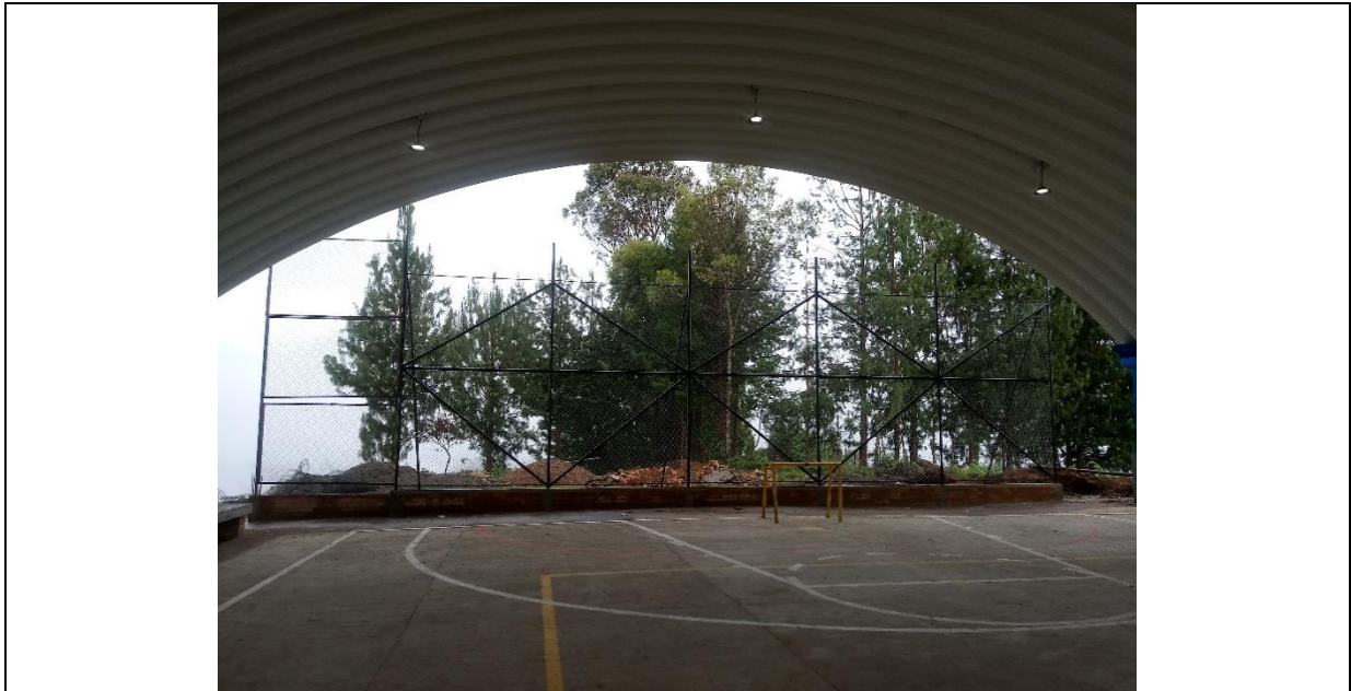
Foto N° 3, Cerramiento arcos, Foto: equipo auditor Oficina de Control Interno. 12-06-2019.
