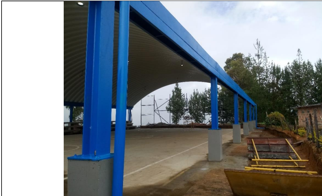
Foto N°10, Estructura de cubierta metálica soportada en columnas de concreto. Foto: equipo auditor Oficina de Control Interno. 12-06-2019
