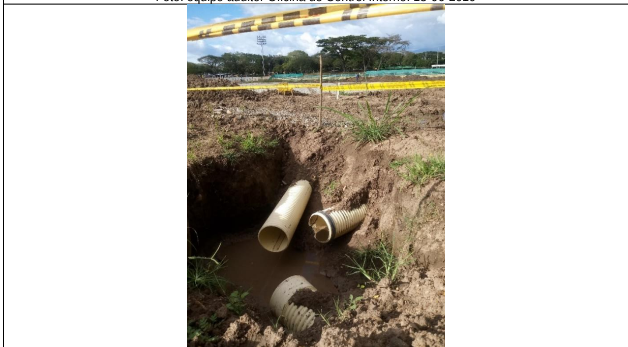
Foto N°22, tubería recolección drenaje cancha y drenaje áreas perimetrales. Se construirá caja de recolección de aguas lluvias cancha y áreas perimetrales. Foto: equipo auditor Oficina de Control Interno. 13-06-2019
