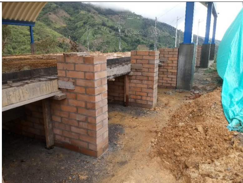
Foto N°14, graderías en construcción parte posterior. Foto: equipo auditor Oficina de Control Interno. 12-06-2019
