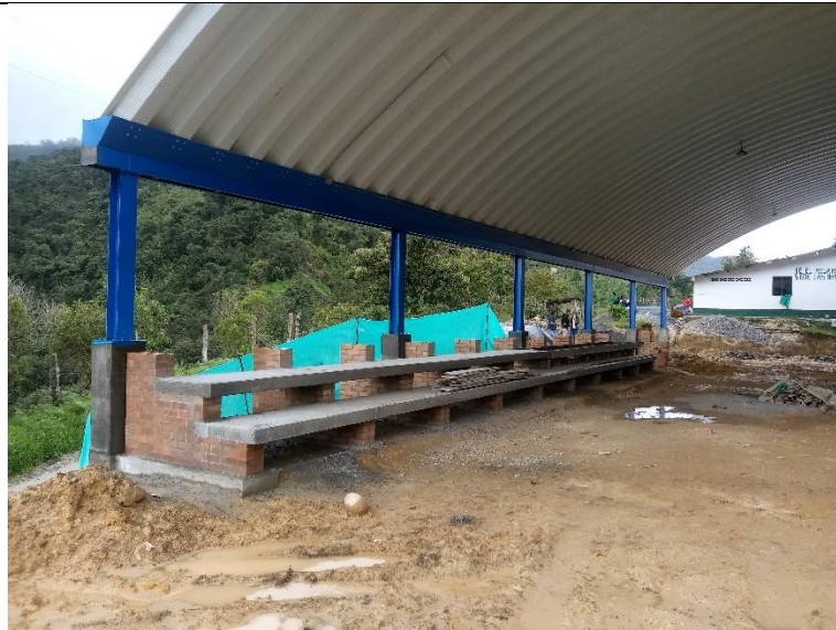
Fotos N°16, panorámica graderías. Foto: equipo auditor Oficina de Control Interno. 12-06-2019
