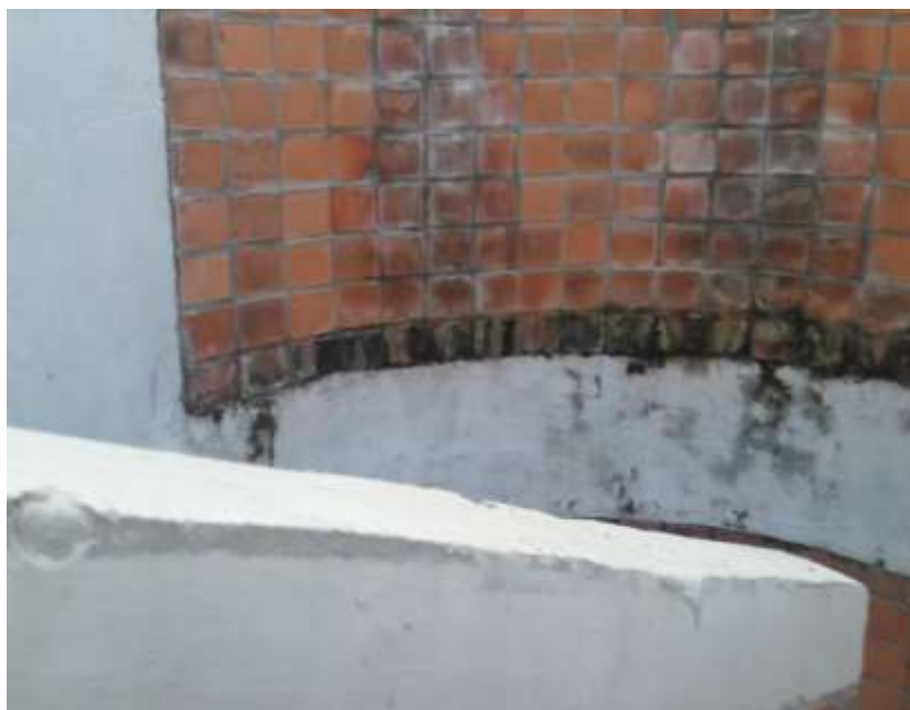
Fotografía N° 563. Humedades en muros y pisos internos por la deficiencia encontrada. Foto tomada por el auditor el 04 de abril de 2019
