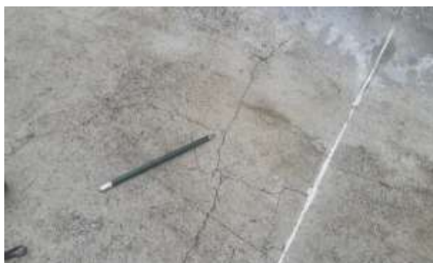
Fotografía N° 568. Fisuras presentadas
