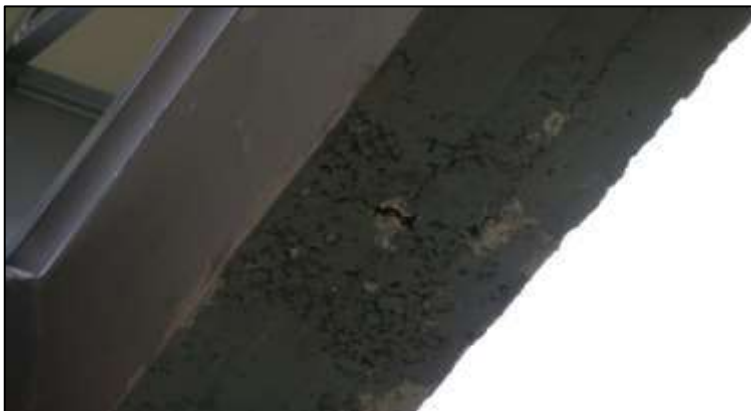
Fotografía 184. Detalle de la cara baja de una viga aérea de concreto. Al igual que en la imagen anterior, en esta fotografía se aprecia el hormigueo excesivo en una de las caras de esta viga de concreto, debido a debilidad en el proceso constructivo, específicamente en el vibrado y homogenización de la mezcla.
