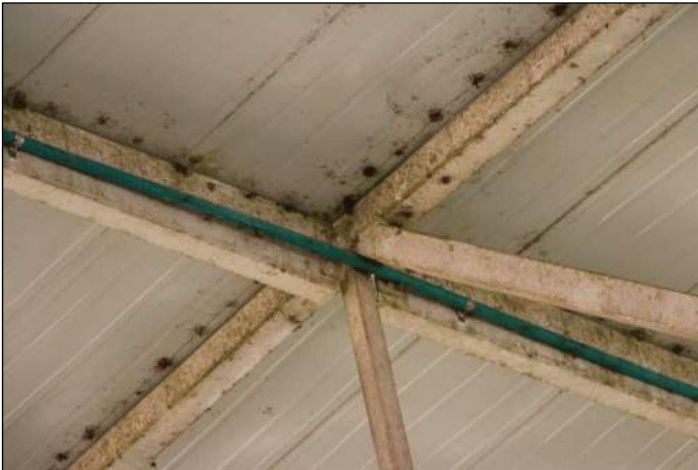
Fotografía 266. Detalle de la conexión entre correas metálicas a nivel de la cumbrera de la cubierta. En esta zona se evidenció lavado diferencial, manchado superficial y picadura de óxido, en los elementos metálicos que componen la estructura de la cubierta.
