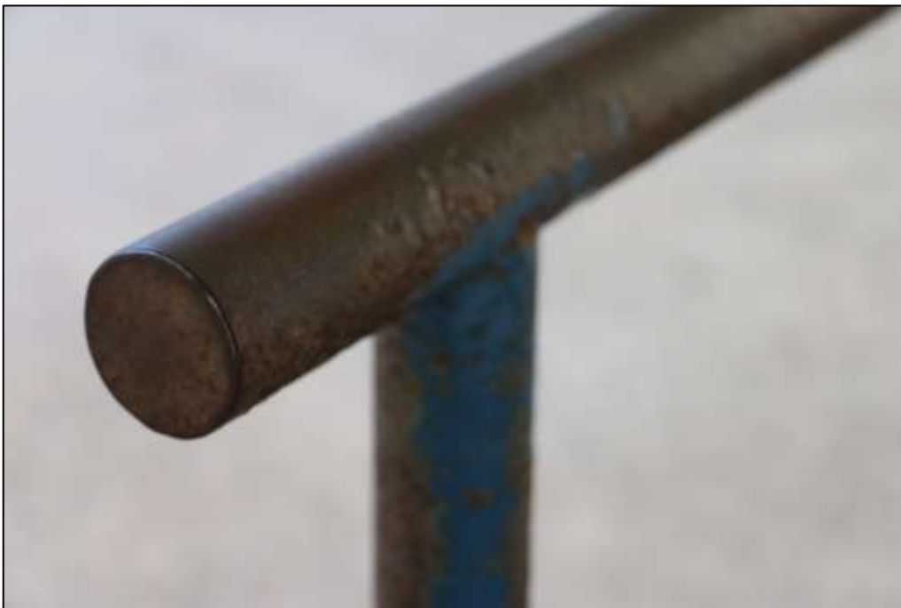
Fotografía 169. Detalle de una sección de tubería, en una de las barandas instaladas en la zona perimetral a la tarima al aire libre. Se evidenció la presencia de oxidación diferencial propagada a lo largo de las tuberías metálicas.
