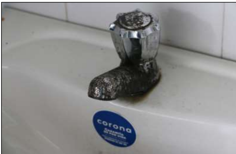
Fotografía 239. Detalle de la grifería instalada en uno de los lavamanos de los baños del edificio de polígono. Se evidencia el mal estado en el cual se encuentra este accesorio, instalado por el contratista de obra: manchado negro de la superficie por oxidación.
