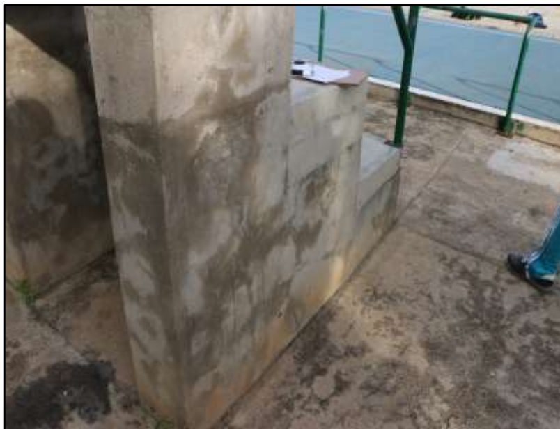
Fotografía 334 Vista general lateral de uno de los muros de soporte, de una de las graderías construidas en este escenario deportivo. El pañete de estos muros, evidencia humedad acumulada y huella de reparaciones antiguas.
