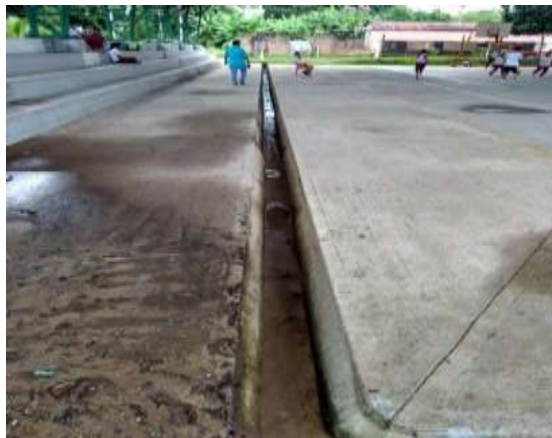
Fotografía N° 515. Detalle de la canalización
