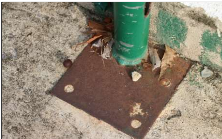
Fotografía 341 Detalle de la platina de conexión, de uno de los parales de la baranda, construida en una de las graderías de la pista de patinaje. En la imagen quedó registrado el estado en el cual se encontraron algunos de los elementos metálicos, los cuales evidencian oxidación avanzada.
