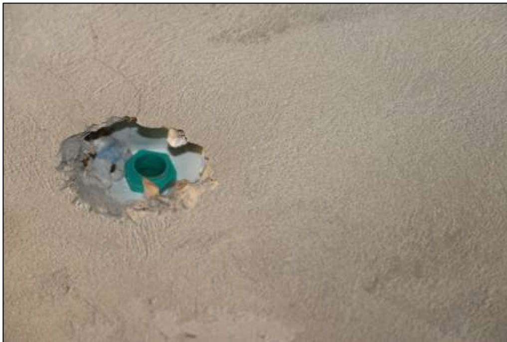
Fotografía 407 Detalle de una salida eléctrica, adecuada en uno de los camerinos ubicados bajo estas graderías. Se evidenció falta del aplique final de esta salida eléctrica.
