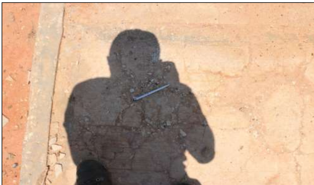
Fotografía 419 Detalle de una sección del pavimento, de uno de los andenes perimetrales construido sobre uno de los costados de este escenario deportivo. Este elemento de concreto, se evidenció con hundimientos, agrietamiento concentrado y desagregación parcial del material. La Secretaria de Planeación del municipio, manifestó que por el paso de vehículos (automóviles y motocicletas), se han deteriorado estos pavimentos.
