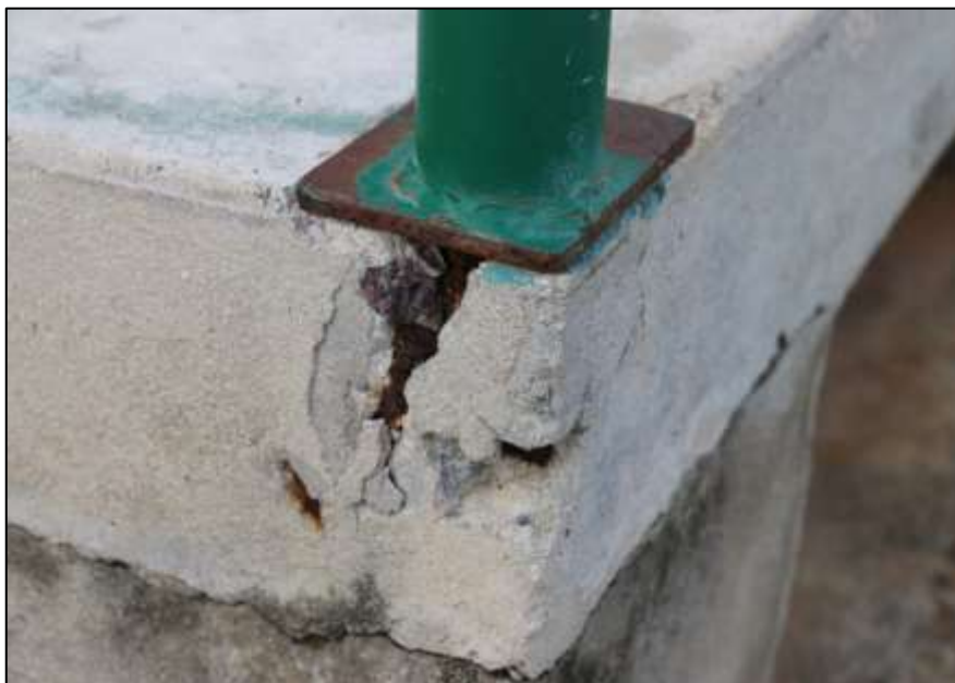
Fotografía 333 Detalle del sitio de conexión de uno de los parales de la baranda, instalada en una de las graderías construidas en este escenario deportivo. Por la baja calidad del proceso constructivo de estos detalles, en estas zonas se evidenció grieta del concreto, pérdida parcial de sección transversal, acero de refuerzo a la vista y oxidación de los elementos metálicos.
