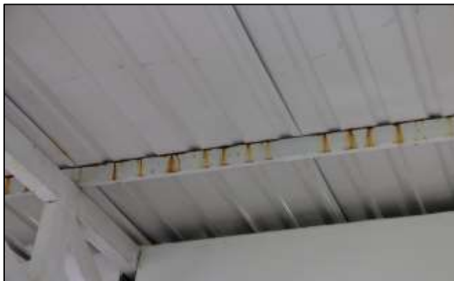
Fotografía 243. Detalle de una de las correas metálicas, instaladas en la cubierta de este escenario deportivo. Se evidencia la huella de óxido dejada sobre una de las caras de este elemento metálico, debido a filtración de agua lluvia desde la cubierta. Esta lesión se evidenció a lo largo de las correas, en especial sobre el costado hacia el embalse del Muña.
