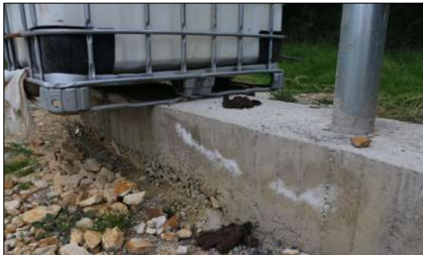
Fotografía 178. Detalle de la cimentación de una de las mallas de contención de balones. El manchado blanco sobre la superficie del concreto de esta obra, evidencia presencia de humedad interna y eflorescencia de sal. Lo anterior, se evidenció en diferentes zonas de este concreto.
