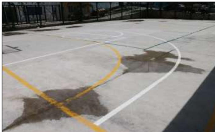
Fotografía 215. Vista general de las placas de concreto construidas en el área de la cancha multideportiva, de este escenario deportivo. Como quedó registrado en la imagen capturada por la CGR durante el recorrido, se evidenció agua encharcada y estancada, sin posibilidad de evacuación. Esta situación vulnera la calidad de la obra entregada.
