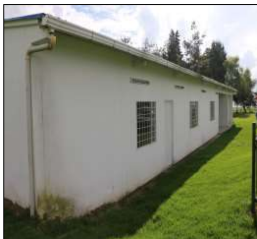
Fotografía 257. Vista general de la fachada principal del escenario deportivo. En la esquina de este muro, en la zona baja, se evidenció deterioro del pañete de este elemento.
