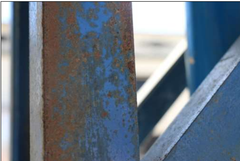
Fotografía 174. Detalle de uno de los elementos metálicos, de una de las columnas tipo celosía, construida como parte de la estructura de la cubierta, en el polideportivo adecuado. En diferentes secciones de estos elementos metálicos, se evidenció oxidación diferencial.
