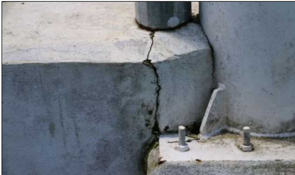
Fotografía 268. Detalle del ingreso de una de las bajantes a una caja de mampostería. Se evidenció grieta en este muro, en varios de estos detalles de la construcción realizada.
