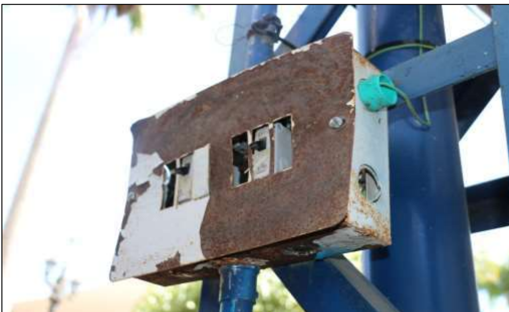
Fotografía 170. Detalle del tablero eléctrico instalado en el polideportivo construido, para controlar la iluminación de dicho escenario. En la imagen quedó registrado el estado en el cual se encontró este elemento. Se evidenció una profunda oxidación de este tablero, así como desubicación de los interruptores.
