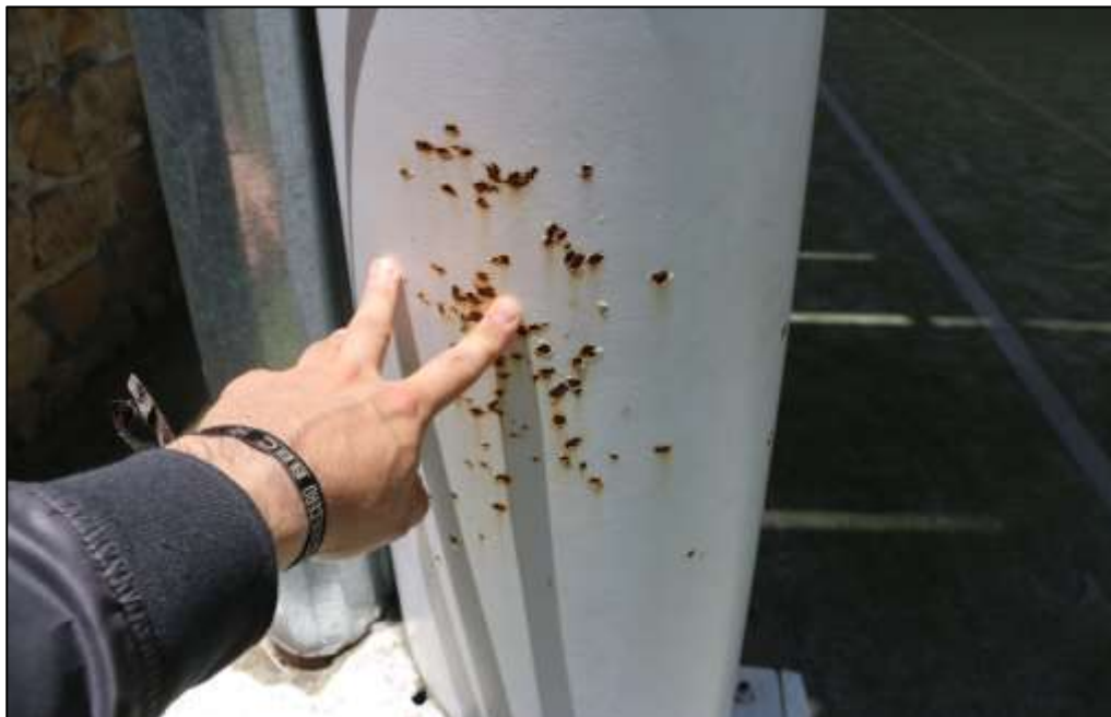
Fotografía 276. Detalle de una sección de una de las columnas metálicas, instaladas en este polideportivo. Como se aprecia en la imagen, la superficie de este elemento evidencia picadura de óxido, concentrada en el sitio registrado en la imagen.
