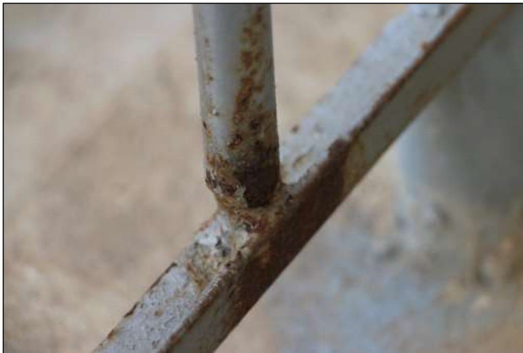
Fotografía 391 Fotografía 296. Detalle de unos elementos metálicos dentro de la malla de contención, instalada a espaldas de uno de las canchas deportivas, dentro del polideportivo. Se evidenció en esta obra la lesión descrita en imágenes anteriores.
