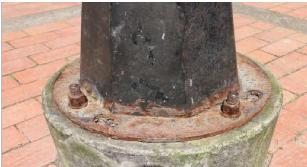
Fotografía 175. Detalle de la base de una de las luminarias instaladas en las zonas abiertas del parque intervenido. Los elementos metálicos de esta conexión, evidencian oxidación profunda, ondulaciones y distorsiones de la platina, así como aberturas en la platina sin ningún uso. Estas situaciones se evidenciaron en la mayoría de las luminarias.
