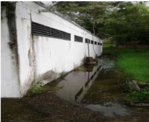
Fotografía N° 510. Conexión fraudulenta de agua
