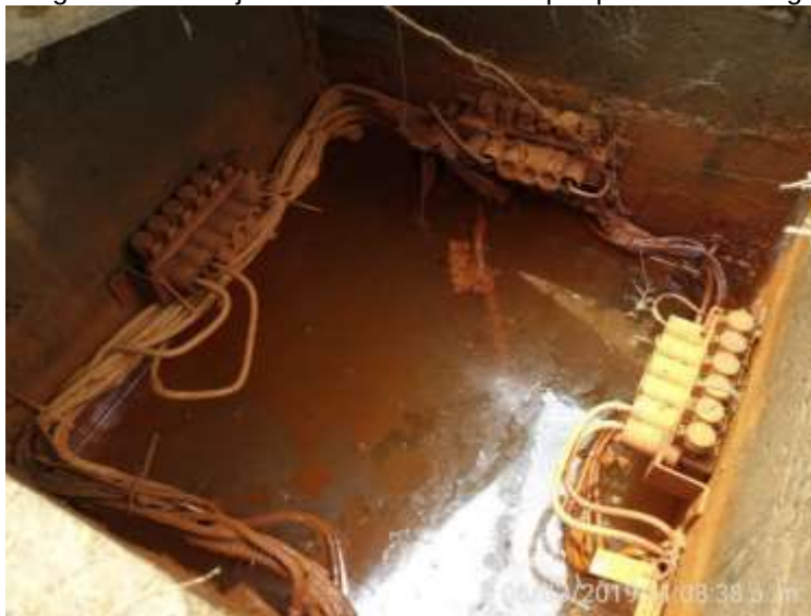
Fotografía 120. Caja eléctrica en deterioro por presencia de agua
