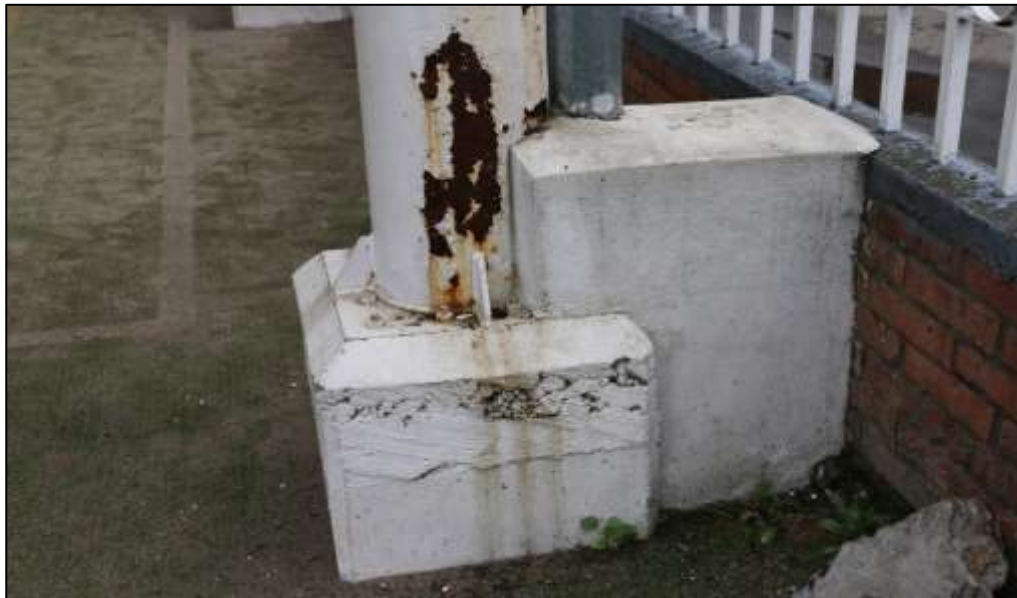
Fotografía 284. Detalle de una sección de una de las columnas metálicas, instaladas en este polideportivo. Se evidenció pérdida parcial y diferencial de pintura de acabado y oxidación de estos elementos.
