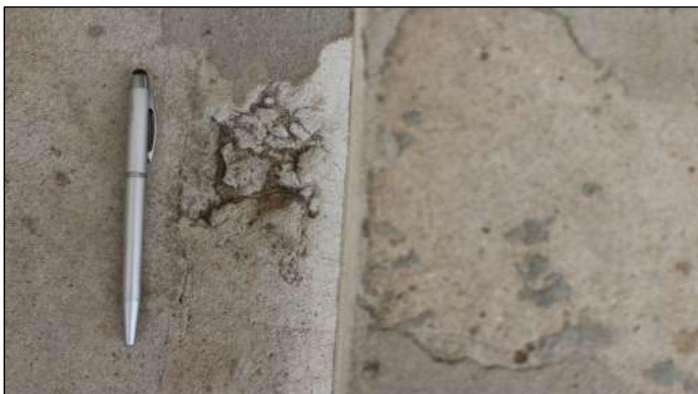
Fotografía 373 Detalle de una sección de material desagregada, evidenciada en el concreto de las graderías (vista en planta). La mezcla de concreto en general, evidenció problemas de continuidad en su adherencia y falta de uniformidad.
