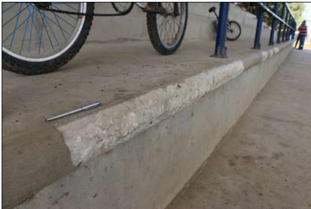
Fotografía 370 Detalle de una sección de grada (polideportivo, vista frontal). Se evidenció, en varias secciones de esta obra, el borde de las placas de concreto desportilladas y fracturadas.
