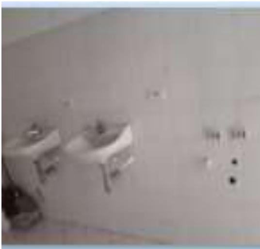
Fotografía N° 490. Alta lavamanos baño
