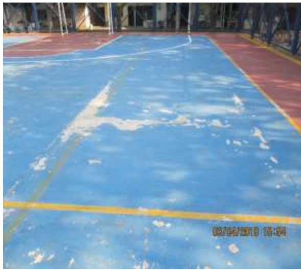
Fotografía 137. Muestra desprendimiento de pintura de la cancha multifuncional
