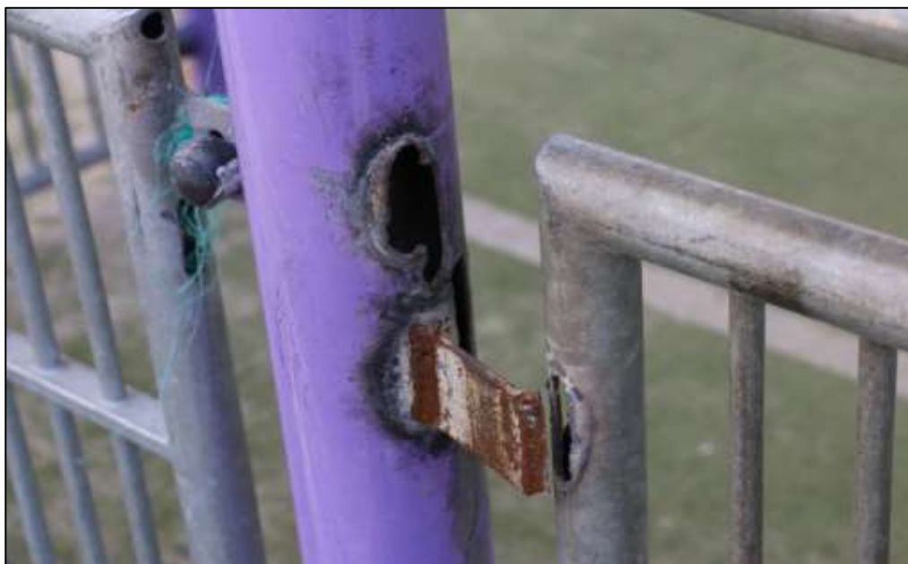
Fotografía 273. Detalle de una conexión interior entre elementos metálicos, en la estructura de uno de los arcos de fútbol. En la imagen quedó registrado el estado en el cual se encontró esta obra, en el sentido de fractura de algunas conexiones y pérdida de secciones metálicas.
