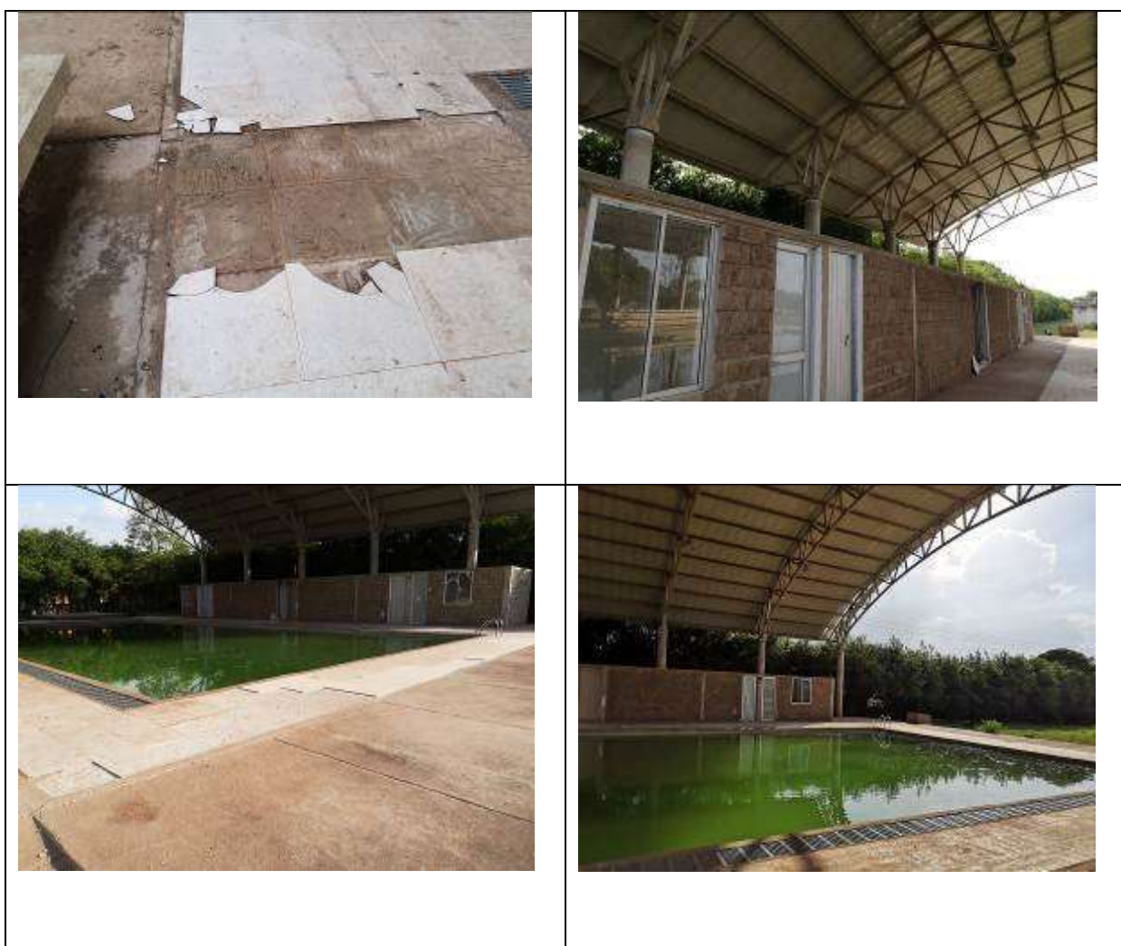
Fotografía 296 Condiciones de la piscina semiolímpica
