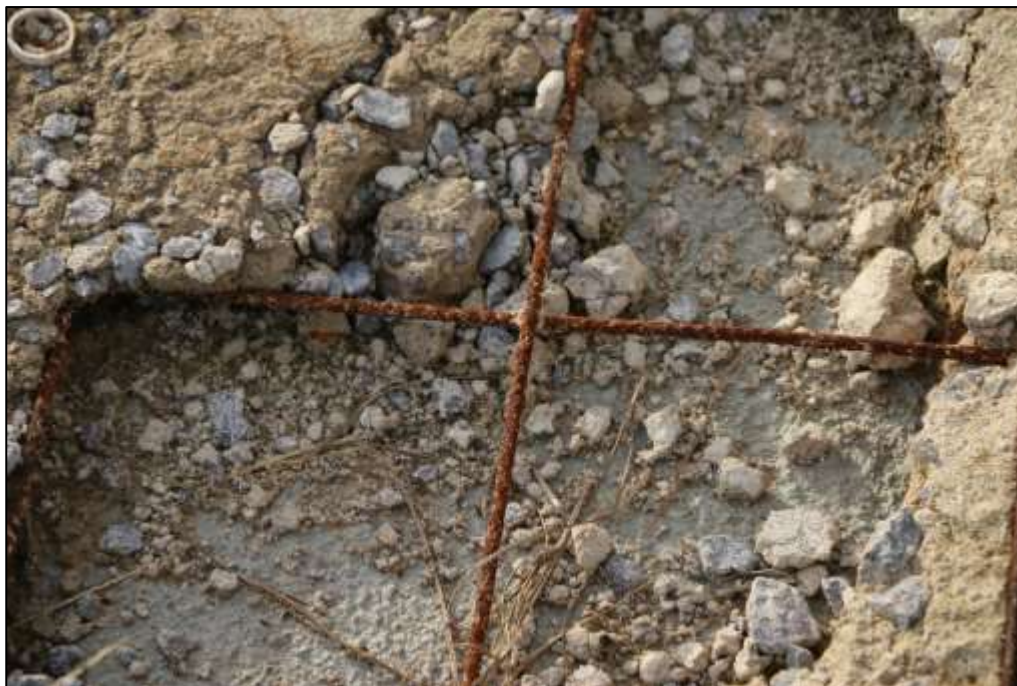
Fotografía 350 Detalle de la sección de concreto fracturada, imagen anterior. El concreto se evidenció desmoronado y desintegrado. Así mismo, el acero de refuerzo está totalmente oxidado.
