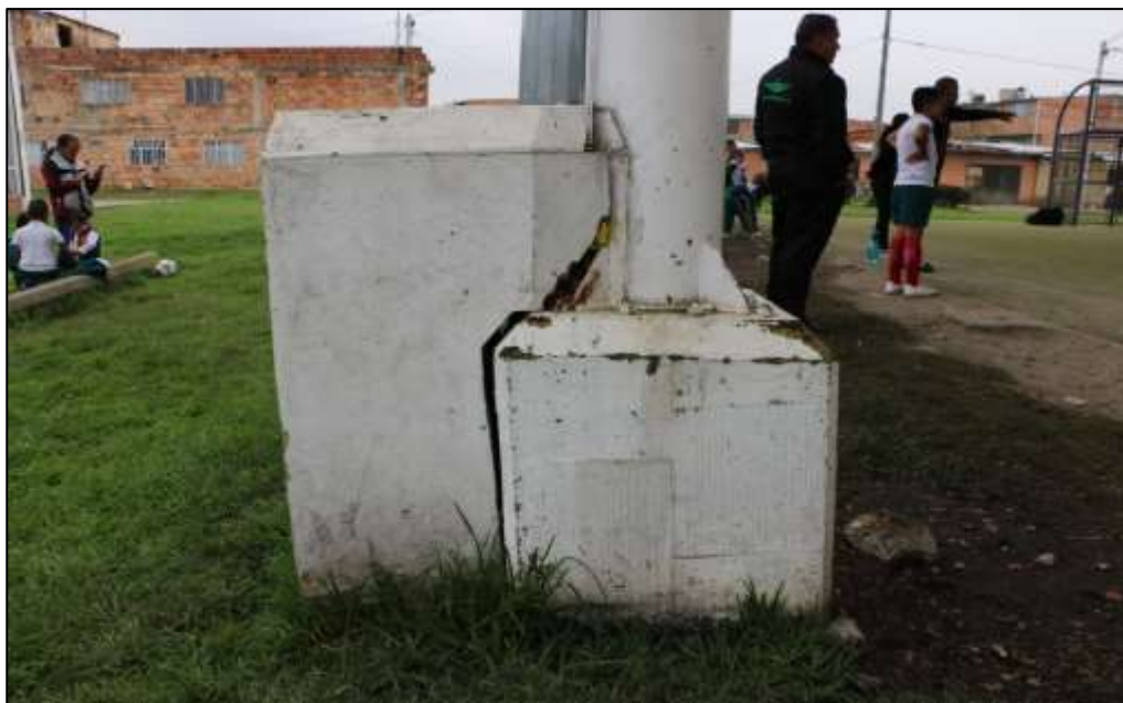
Fotografía 281. Detalle de una de las cajas de mampostería construidas para proteger a las bajantes en cercanía al nivel del terreno. Se evidenció grieta en algunos de estos muros.
