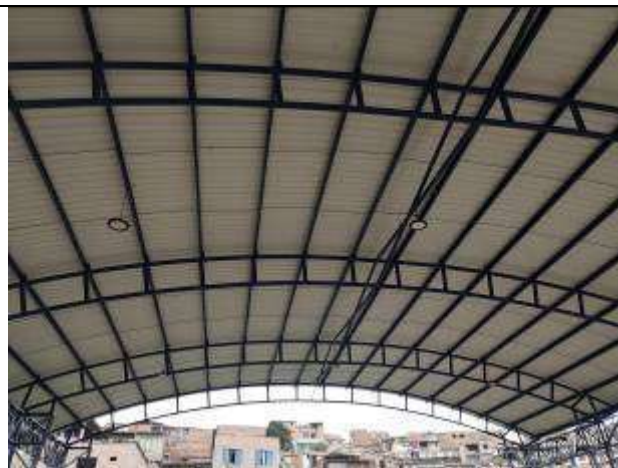
Fotografía 130 Cubierta en teja termoacústica
