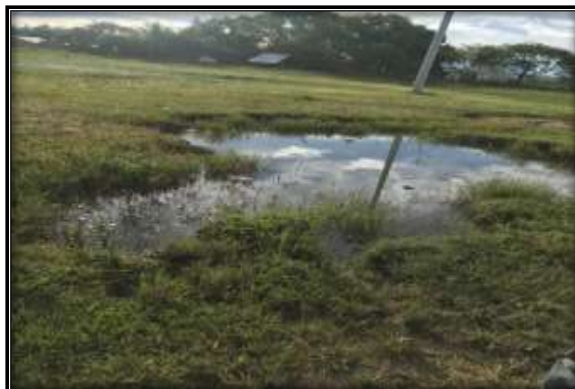
Fotografía N° 552. El pozo séptico no fue instalado correctamente, por este motivo no es funcional
