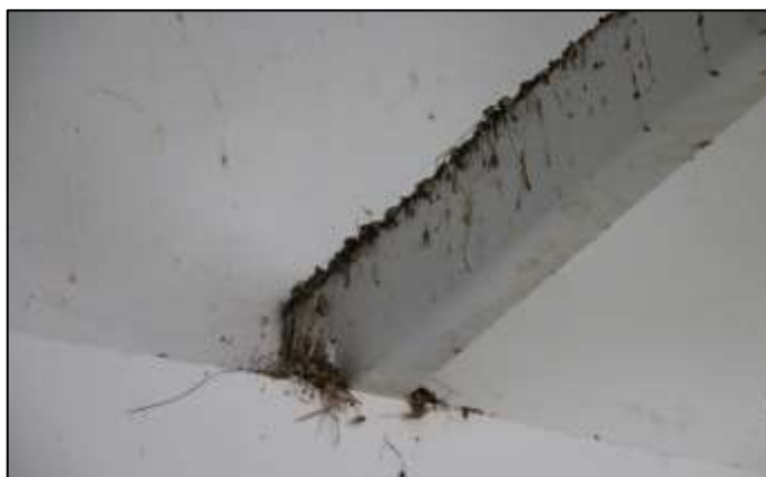
Fotografía 244. Detalle de otra de las correas metálicas, instaladas en la cubierta de este escenario deportivo. Se evidenció presencia de excremento de paloma, sobre los elementos metálicos y a nivel de la placa de contra piso. El escenario deportivo evidencia abandono por parte de la administración municipal.
