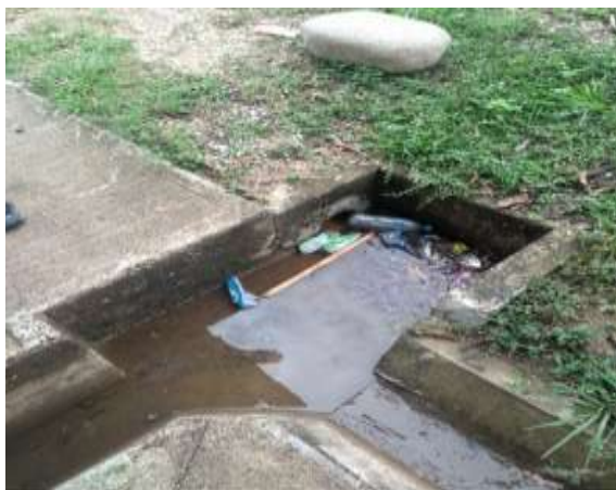
Fotografía N° 513. Desagues de aguas lluvias
