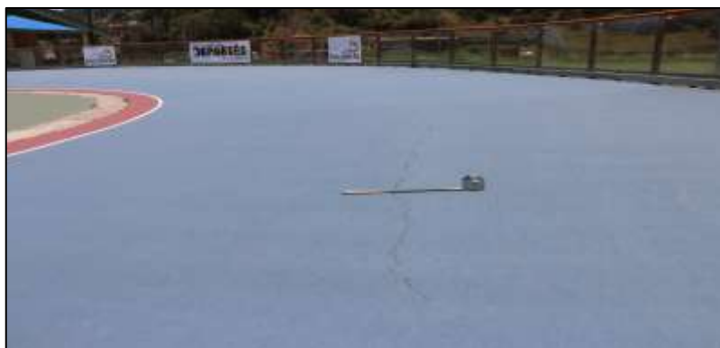
Fotografía 201. Detalle de otra sección de la pista de patinaje (patinódromo). Evidencia de fisura longitudinal, sobre una de las curvas de este escenario deportivo. Esta fisura tiene una longitud que supera los 2 m.
