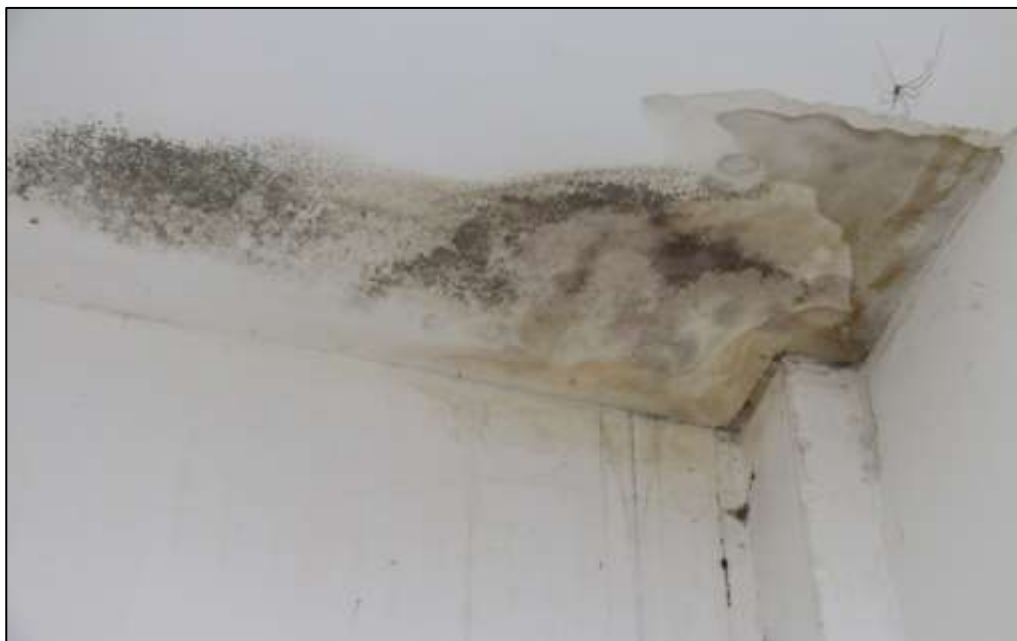
Fotografía 355 Detalle de la esquina superior de uno de los espacios adecuados, dentro del edificio administrativo. En algunas secciones de los cielos rasos, como la registrada en la imagen, se evidenció manchado diferencial del material por acumulación de humedad, proveniente de filtración desde la cubierta.
