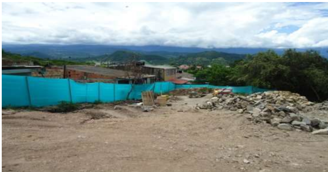
Fotografía 149. Vista general del terreno a construir. 26/04/2019
