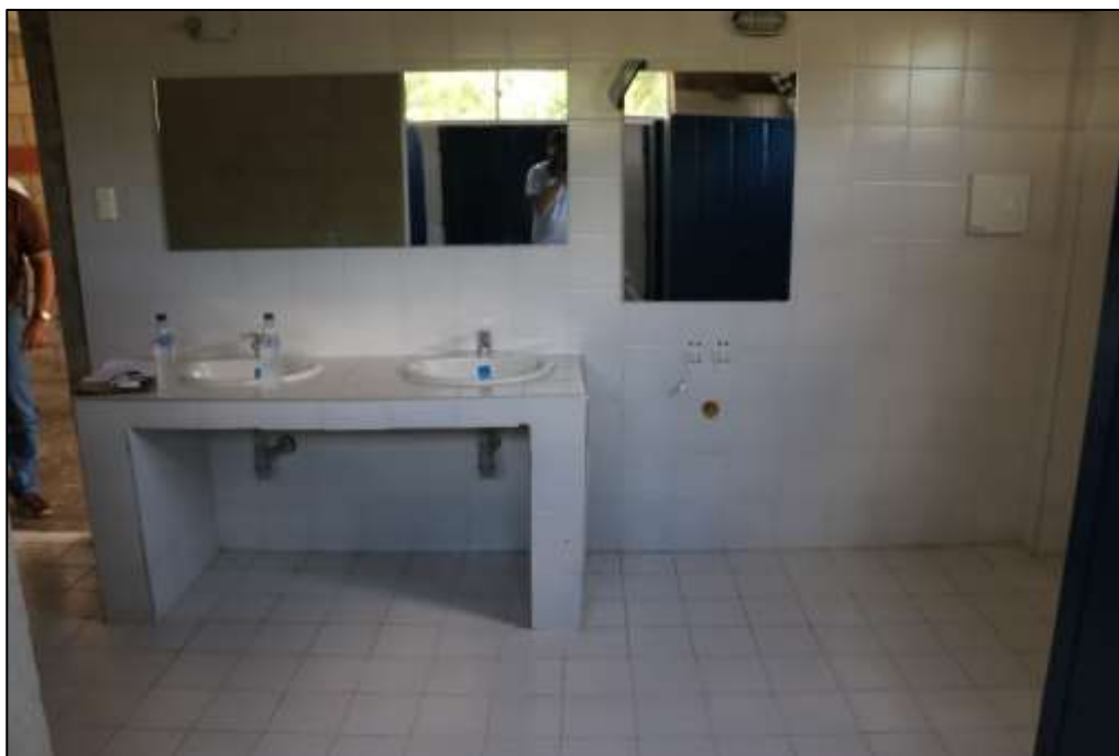
Fotografía 398 Vista general de una batería de lavamanos, en uno de los baños adecuados en el edificio administrativo del polideportivo. Durante el recorrido, se evidenció la ausencia de diferentes aparatos sanitarios, así como de grifería de otros.
