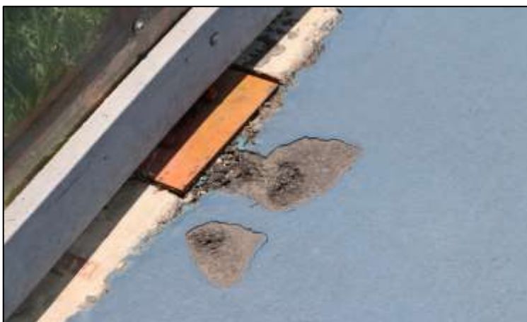
Fotografía 200. Detalle de otra sección de la pista de patinaje (patinódromo). Evidencia de desprendimiento de una sección del recubrimiento sintético.
