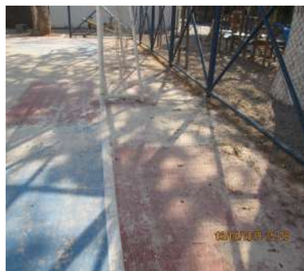
Fotografía 142. Muestra desgaste de pintura de la cancha multifuncional.
