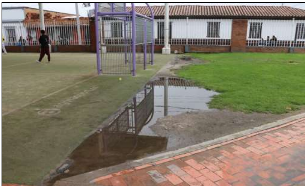
Fotografía 289. Vista general de unos de los costados cortos de este polideportivo (detrás de uno de los arcos instalados). Durante el recorrido se evidenció agua estancada, por dificultad del escenario en evacuar el agua de escorrentía. Se evidenció que las bajantes de la cubierta descargan el agua de manera directa a la superficie, sin ningún control.
