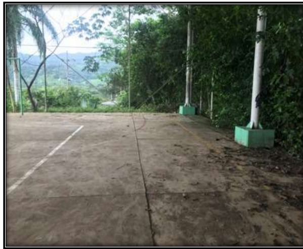
Fotografía N° 539. Las placas presentan niveles diferenciales
