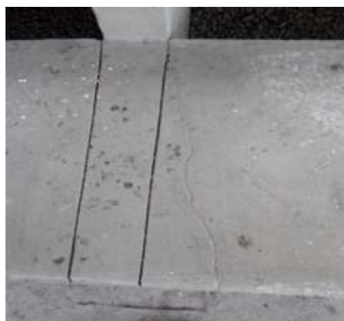
Fotografía N° 543. Gradería agrietada
