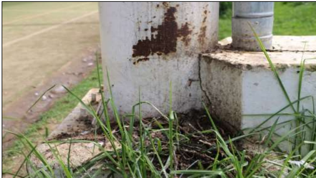
Fotografía 278. Detalle de una sección de una de las columnas metálicas, instaladas en este polideportivo. Se evidenció pérdida parcial y diferencial de pintura de acabado y oxidación de estos elementos.
