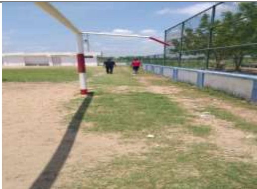
Fotografía 32 Parales de porterías en mal estado
