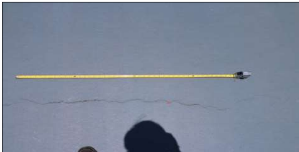
Fotografía 196. Detalle de otra sección de la pista de patinaje (patinódromo). Evidencia de otra fisura longitudinal.
