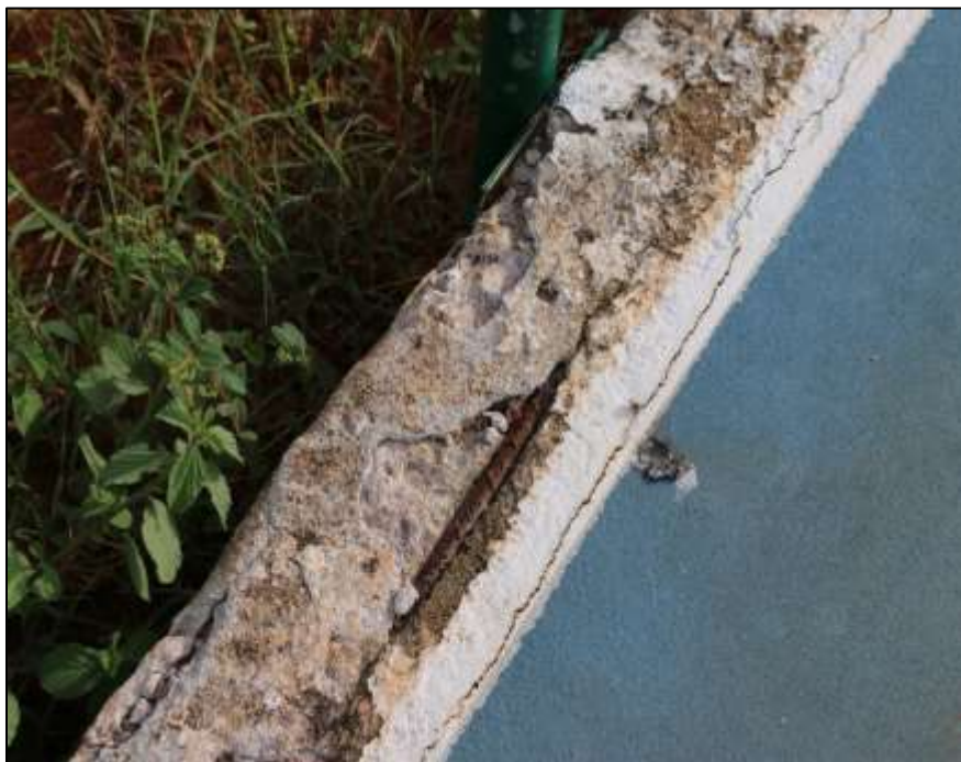
Fotografía 326 Detalle de una sección del bordillo perimetral externo, de la pista de patinaje (patinódromo). En varias secciones de esta obra, se evidenció pérdida parcial del concreto de recubrimiento, así como agregado y acero de refuerzo longitudinal a la vista. Este último ya evidencia oxidación profunda.
