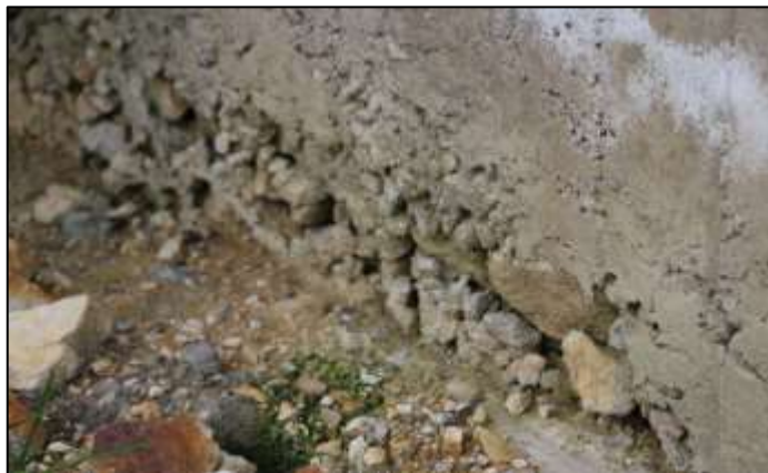
Fotografía 179. Detalle de la cimentación de una de las mallas de contención de balones (parte baja). En la imagen se aprecia el agregado a la vista, segregación de la mezcla y hormigueo excesivo. Lo anterior, es producto de mala calidad de obra. Este proceso patológico se evidenció en distintas secciones de estos concretos.
