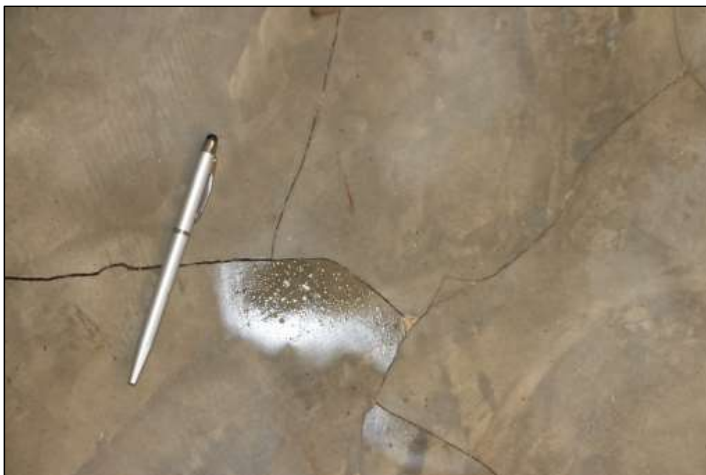
Fotografía 378 Detalle de una sección de la placa de contra piso, del espacio registrado en la imagen anterior. Se evidenció que el concreto presenta varias capas, con problemas de adherencia entre concretos de distintas edades.
