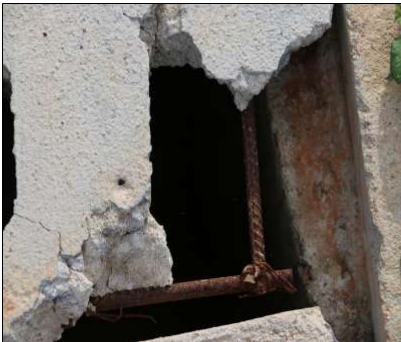
Fotografía 332 Detalle de una sección del elemento presentado en la imagen anterior. En la imagen, el acero de refuerzo longitudinal a la vista. Se evidencia, además, que el acero de refuerzo no cuenta con la longitud de desarrollo requerido por norma, para garantizar su desempeño estructural (NSR-10, título C).
