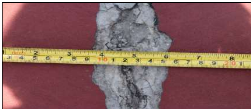
Fotografía 207. Detalle de la lesión identificada en la imagen anterior. La abertura de la grieta en algunos sitios es de 7 cm. En esta fotografía se evidencia que el concreto de la placa bajo el acabado superficial, también está afectado.
