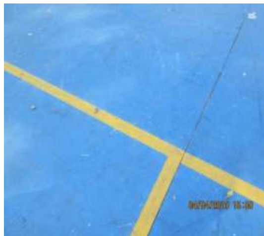
Fotografía 145. Muestra grieta transversal presentada en una losa de la cancha multifuncional.
