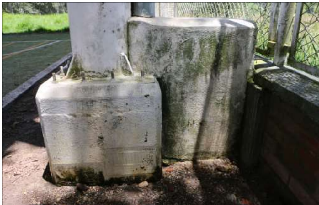
Fotografía 270. Detalle de otro pedestal construido. La superficie de los concretos evidencia lavado diferencial y manchado por acumulación de humedad.
