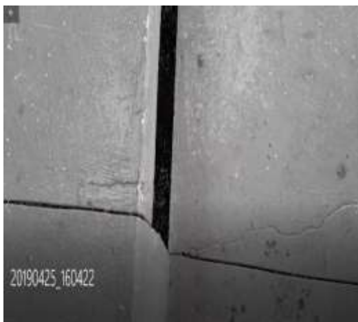
Fotografía N° 542. Gradería agrietada
