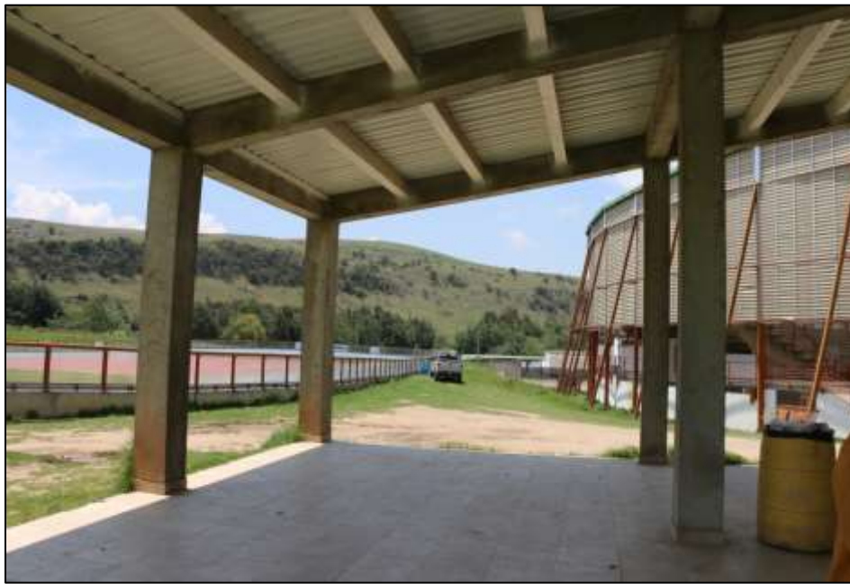
Fotografía 192. Vista general del espacio de circulación a un costado de las baterías sanitarias adecuadas. Se evidencia el tipo de estructura metálica de la cubierta, la cual corresponde únicamente a correas en perfiles tubulares rectangulares.
