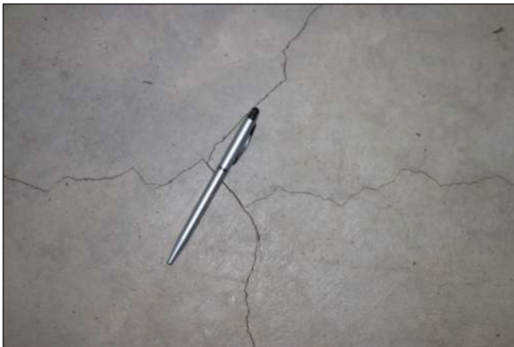
Fotografía 381 Detalle de otra de las fisuras interconectadas, evidenciadas en la superficie del pavimento construido como placa de contra piso, en el pasillo adecuado entre camerinos.
