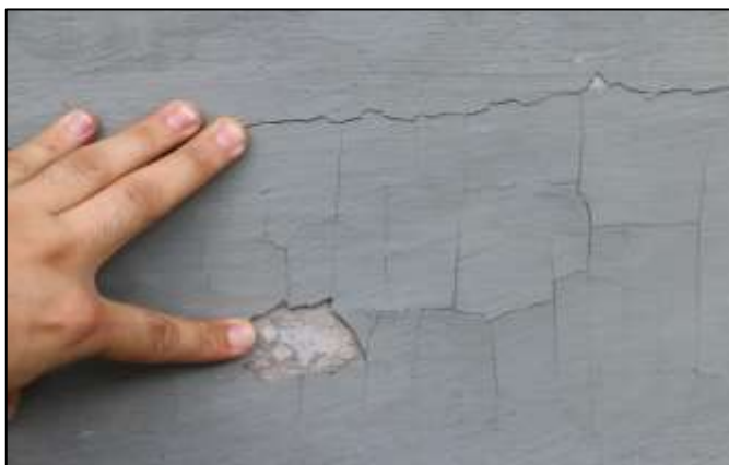
Fotografía 223. Detalle de otra sección de contrahuella en una de las graderías construidas. El pañete en esta zona evidencia fisuras interconectadas en formato “piel de cocodrilo” y pérdida parcial de sección de este material.
