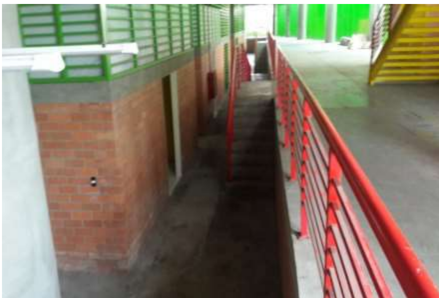
Fotografía N° 556. Baños bajo la gradería occidental que se inundan por capacidad insuficiente del canal exterior de recolección de aguas lluvias. Foto tomada por el auditor Abril de 2019.
