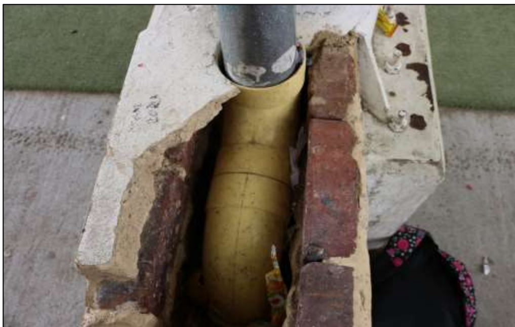
Fotografía 267. Detalle de la conexión plástica de una de las bajantes instaladas en esta estructura. Se evidencia la ejecución de una caja de mampostería, desportillada y con elementos desprendidos.
