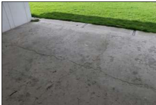
Fotografía 250. Vista general de la placa de contra piso, a lo largo del pasillo principal de este escenario deportivo. Las fisuras se evidenciaron interconectadas.
