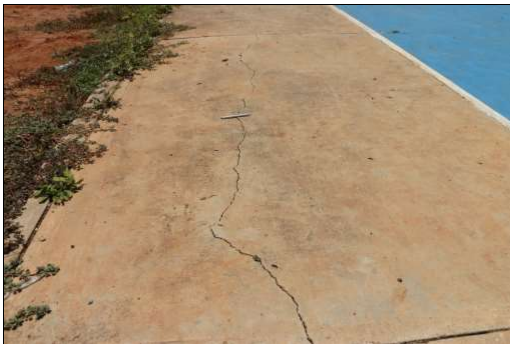
Fotografía 387 Vista general de otra sección del andén perimetral, construido en zonas aledañas a este escenario deportivo. En otras zonas de esta obra, se evidenciaron fisuras longitudinales, paralelas a la dimensión mayor de este pavimento.
