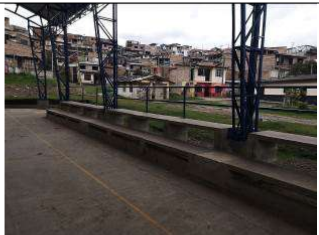
Fotografía 131 Gradería en mampostería instalada en el polideportivo.
