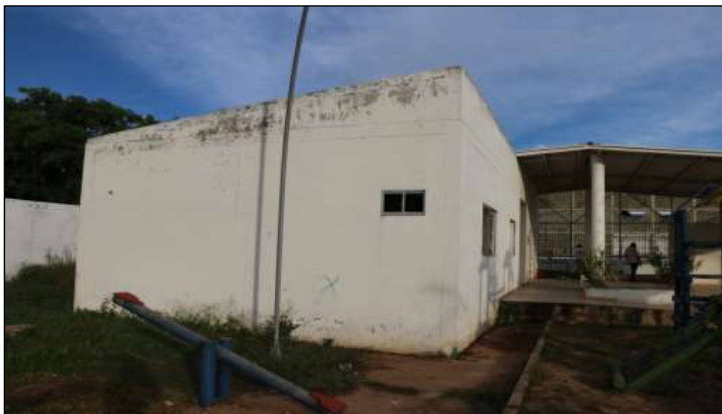
Fotografía 358 Vista general de una de las fachadas laterales, del edificio administrativo. Sobre la superficie de estos muros, al igual que en los bordes de la placa de contra piso externa y los muros de las materas, se evidenció lavado diferencial por escurrimiento de agua lluvia y pérdida parcial de la pintura de acabado.
