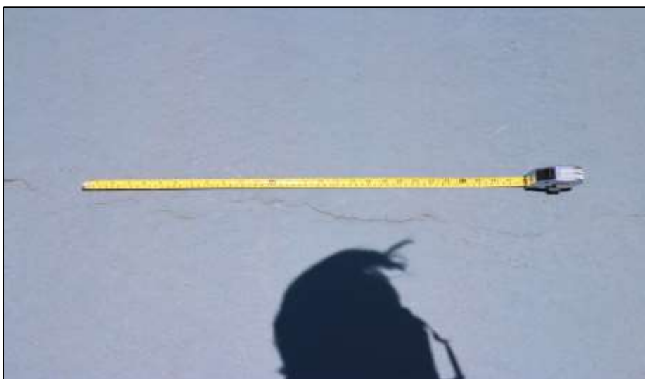
Fotografía 194. Detalle de una sección de la pista de patinaje (patinódromo). En la superficie de la capa de rodadura de esta estructura y en diferentes secciones, se evidenciaron fisuras longitudinales, como la registrada en la imagen.
