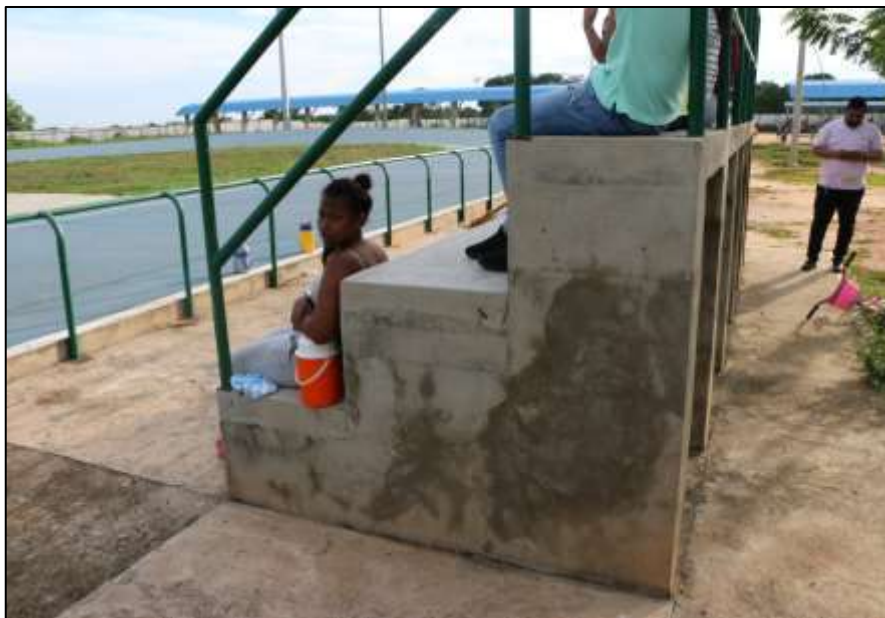
Fotografía 336 Vista general lateral de uno de los muros de soporte, de una de las graderías construidas en este escenario deportivo. El pañete de estos muros, evidencia humedad acumulada y huella de reparaciones antiguas.
