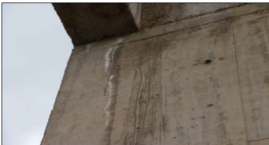
Fotografía 187. Detalle de la superficie de otra de las columnas de concreto construidas en este polideportivo. Otra de las lesiones evidenciadas es la registrada en la imagen: humedad acumulada y eflorescencia de sal.
