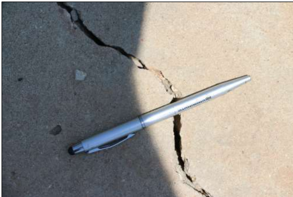
Fotografía 386 Detalle de una grieta, registrada en una sección de andén. Según la escala utilizada en la imagen (esfero de ancho 10 mm), la abertura de la lesión es aproximadamente de 10 mm.
