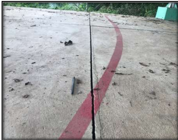
Fotografía N° 538. Las placas presentan niveles diferenciales
