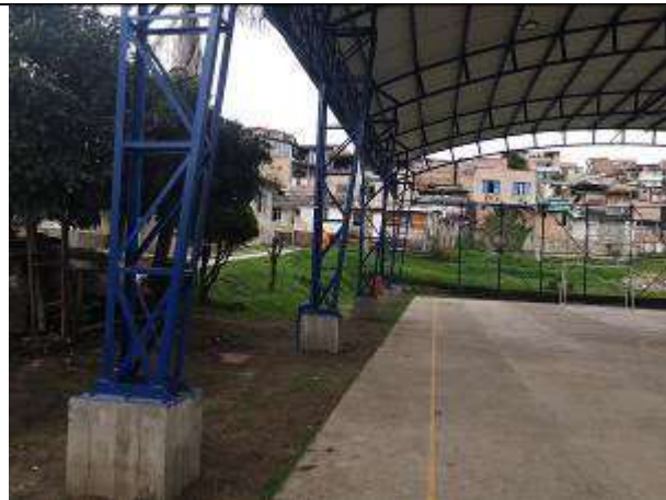
Fotografía 128 Detalle de la estructura de cubierta, basada en dados de concreto reforzado
