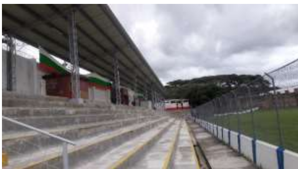
Fotografía N° 566. Vista general del proyecto
