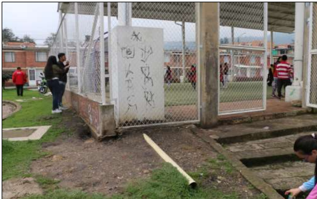
Fotografía 292. Detalle una de las tuberías de descarga del agua lluvia recogida por la cubierta (junto al acceso peatonal). Se evidenció esta tubería a la vista, la cual se encuentra desprotegida y susceptible de ser aplastada. Así mismo, la descarga del agua lluvia se realiza de manera directa a la superficie, sin ningún control.
