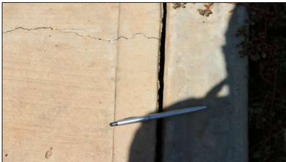
Fotografía 385 Detalle de la sección del andén perimetral, registrado en la imagen anterior. Según la escala utilizada en la imagen (esfero de ancho 10 mm), la dilatación generada entre bordillo y andén, es aproximadamente 15 mm. En la fotografía también quedó capturada una fisura transversal.
