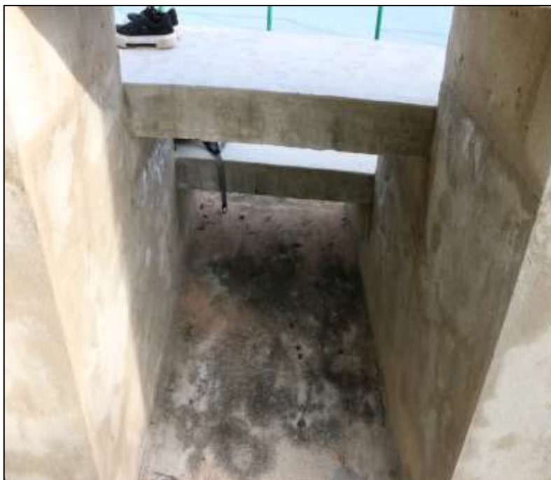
Fotografía 335 Detalle de una sección interna de una de las graderías construidas en este escenario deportivo. En los muros se evidencia eflorescencia de sal y acumulación de humedad en los pañetes, en la cara superior de la placa de contra piso, manchado diferencial por acumulación de humedad. Lo anterior, por baja calidad de los materiales utilizados.
