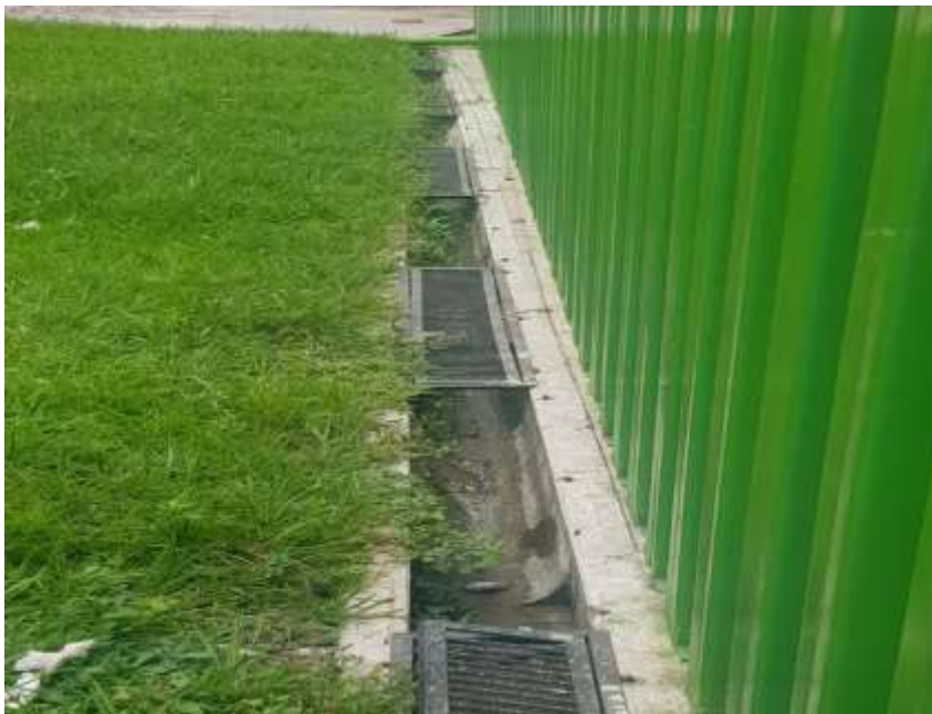
Fotografía N° 555. Concreto con capacidad insuficiente que cuando llueve rebosa su capacidad y el agua lluvia se introduce a la parte interna del Coliseo, inundando la zona de los baños. Foto tomada por El Auditor Abril de 2019.
