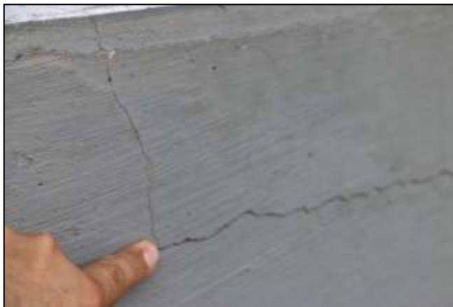
Fotografía 221. Detalle de otra sección de contrahuella en una de las graderías construidas. En la imagen se evidencian fisuras presentes en la obra construida.
