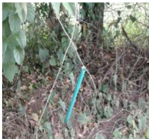
Fotografía N° 507. Redes eléctricas saqueadas
