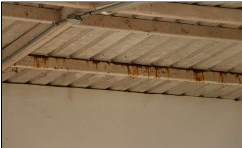
Fotografía 361 Detalle de una sección de la cubierta construida, sobre el área libre frente al edificio administrativo. En esta zona, se evidenció lavado diferencial por flujo de agua con óxido, sobre la superficie de los elementos metálicos de la estructura de cubierta. La cantidad de óxido presente permite concluir que la lesión es antigua.
