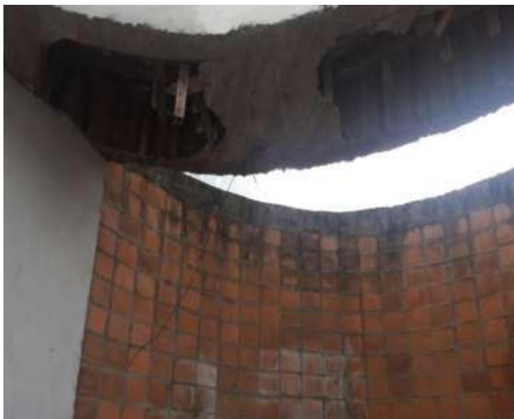
Fotografía N° 565. Espacio que se deja como ventilación, lugar por donde entra el agua a las gradas y por allí baja hasta los camerinos y baños.
