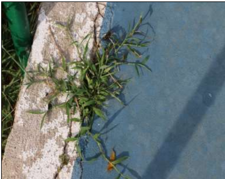
Fotografía 315 Detalle de una sección de la pista de patinaje (patinódromo). En la imagen quedó registrada la presencia de materia vegetal, que ha crecido dentro de una de las grietas del pavimento de concreto.
