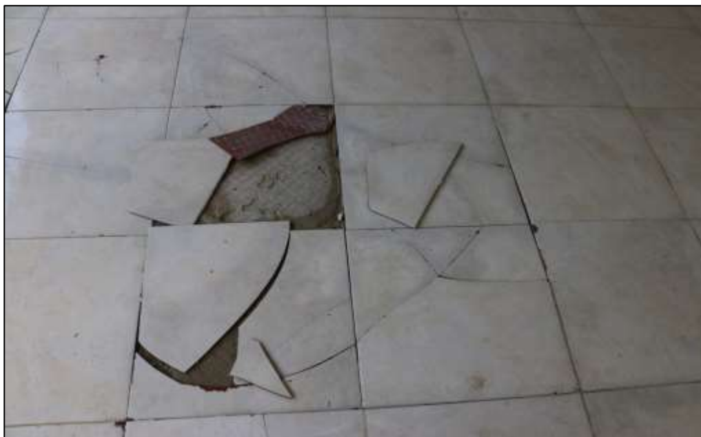
Fotografía 405 Detalle de una sección de enchape de piso, en uno de los espacios adecuados en el edificio administrativo del polideportivo. En algunas zonas internas de esta edificación, se evidenció fractura del enchape de piso, como en la zona registrada en la imagen. El mal uso por parte de la comunidad y administradores del edificio, así como el abandono por parte de la Alcaldía, son la causa.
