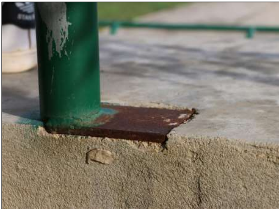
Fotografía 343 Detalle de otra platina. Se evidencia la lesión ya descrita en imágenes anteriores.
