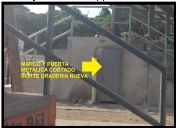
Fotografía 122 Marcos y puertas metálicas colocadas por contratista bajo gradería nueva
