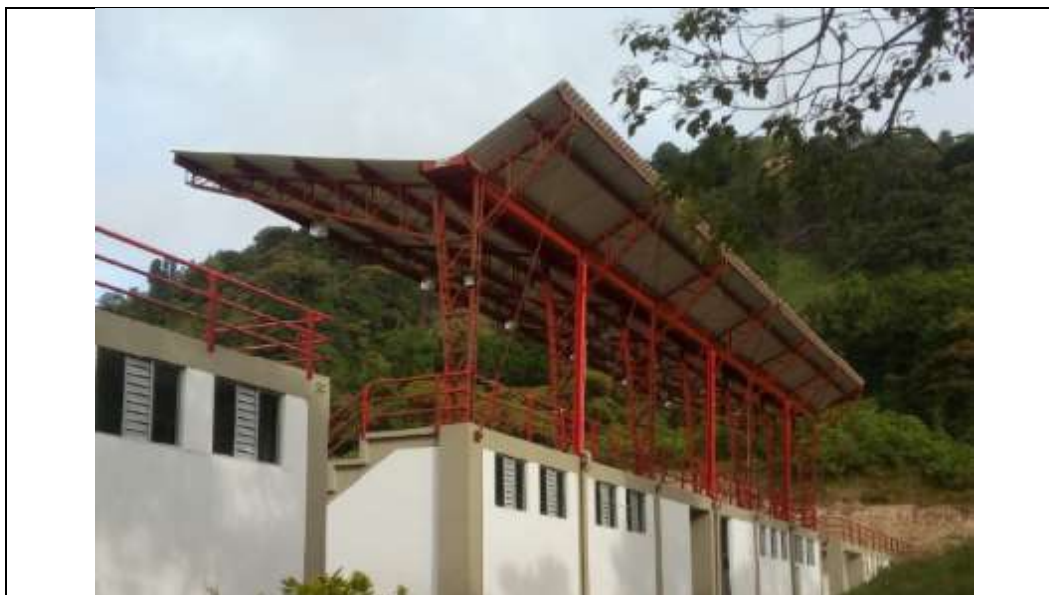
Fotografía 425 Las graderías del centro cuentan con cubierta y solo hay tres bajantes de aguas lluvias.
