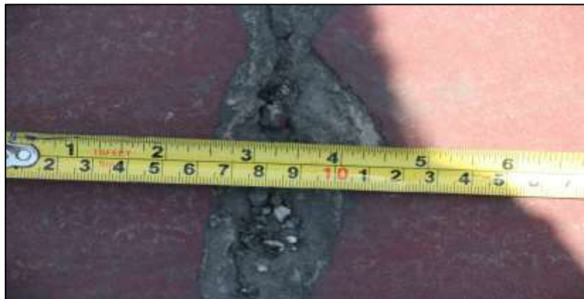
Fotografía 205. Detalle de la lesión identificada en la imagen anterior. La abertura de la grieta en algunos sitios es de 5 cm. En esta fotografía se evidencia que el concreto de la placa bajo el acabado superficial, también está afectado.
