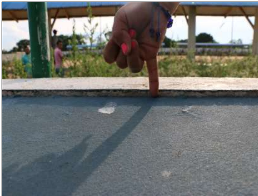
Fotografía 323 Detalle de una sección de la pista de patinaje (patinódromo). En la imagen se aprecia el asentamiento que ha sufrido el pavimento construido, con respecto al muro de contención, ubicado de manera posterior del sitio de la imagen. Según la escala utilizada, se evidencia un asentamiento aproximado de 15 mm.
