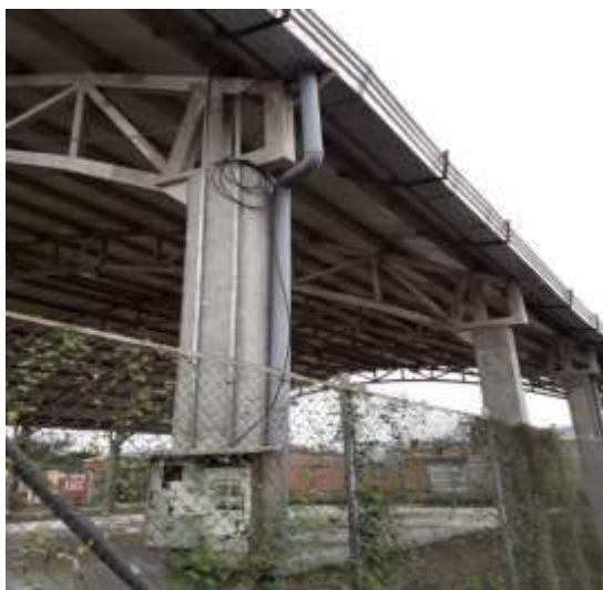
Fotografía N° 518. Maleza en el área perimetral
