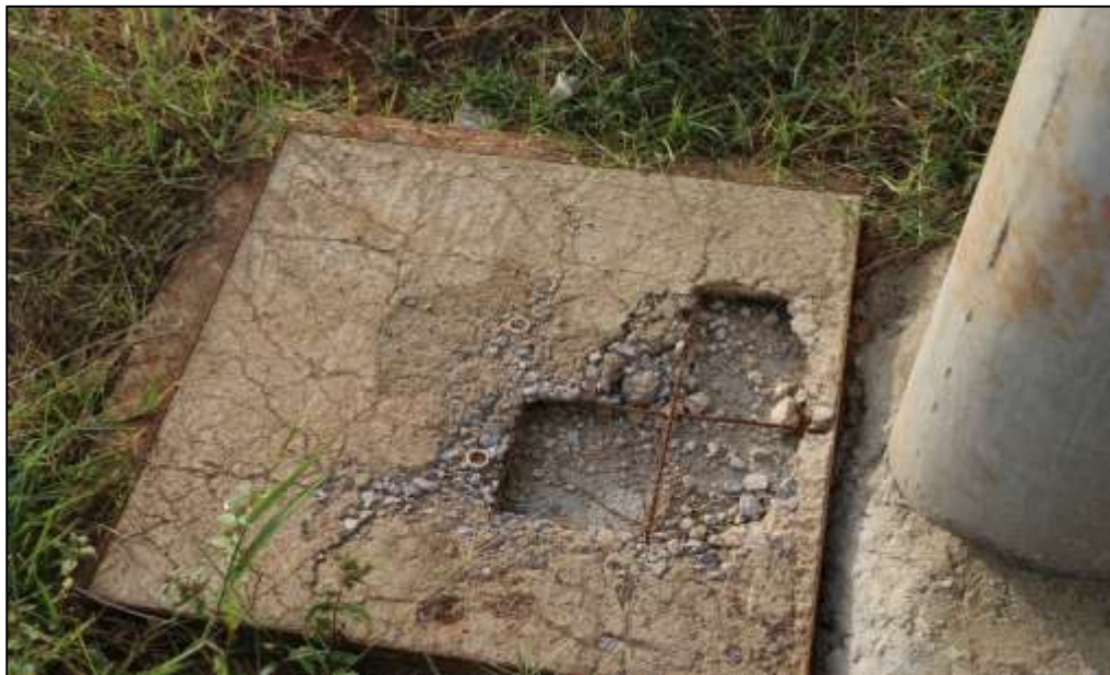
Fotografía 349 Detalle de una de las cajas eléctricas de inspección, construida junto de uno de los postes de la iluminación. Como se aprecia en la imagen, la placa de concreto evidencia fractura y desintegración. El acero de refuerzo, a su vez, está a la vista y totalmente oxidado.
