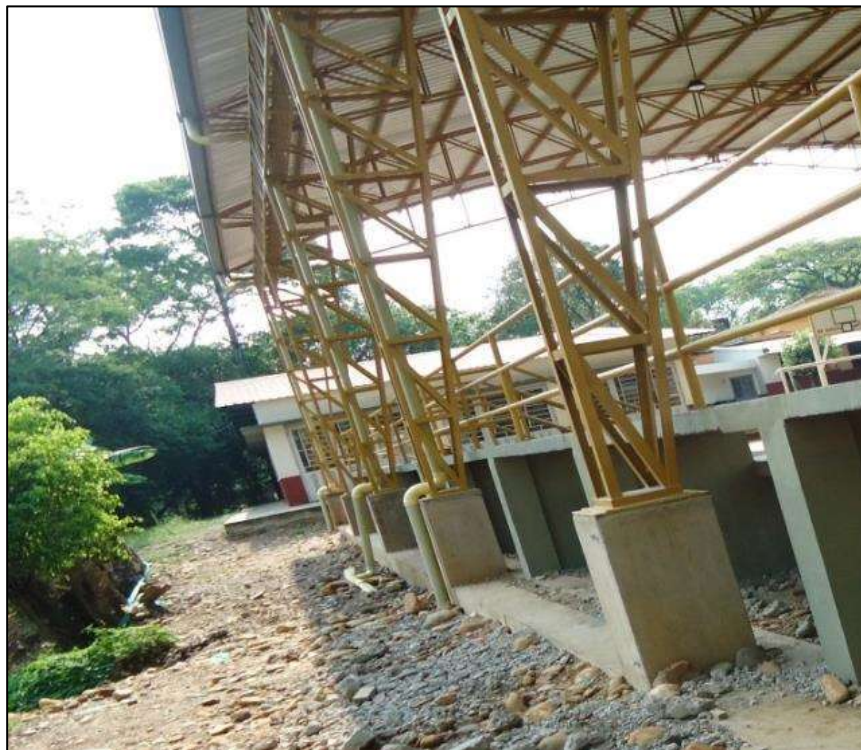
Fotografía 238. Vista general posterior del polideportivo
