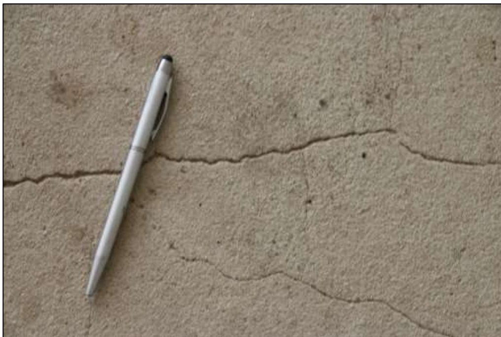
Fotografía 375 Detalle de una fisura, evidenciada en el concreto de las graderías (vista en planta). Algunas fisuras evidenciadas, presentan otras cercanas ubicadas de manera diagonal. No obstante, no se evidenciaron interconectadas.
