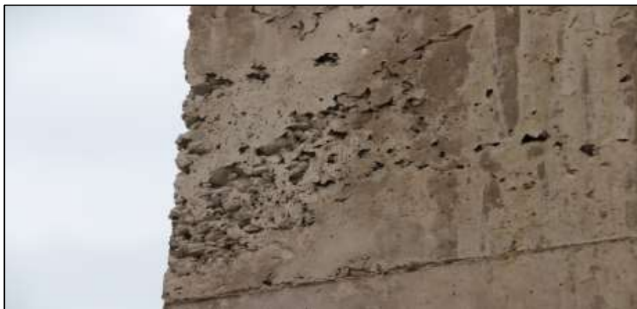
Fotografía 186. Detalle de la superficie de una de las columnas de concreto construidas en este polideportivo. Estos elementos evidencian hormigqueo y agregado a la vista. Lo anterior, ocasionado por problemas constructivos (debilidad en el vibrado y homogenización de la mezcla).
