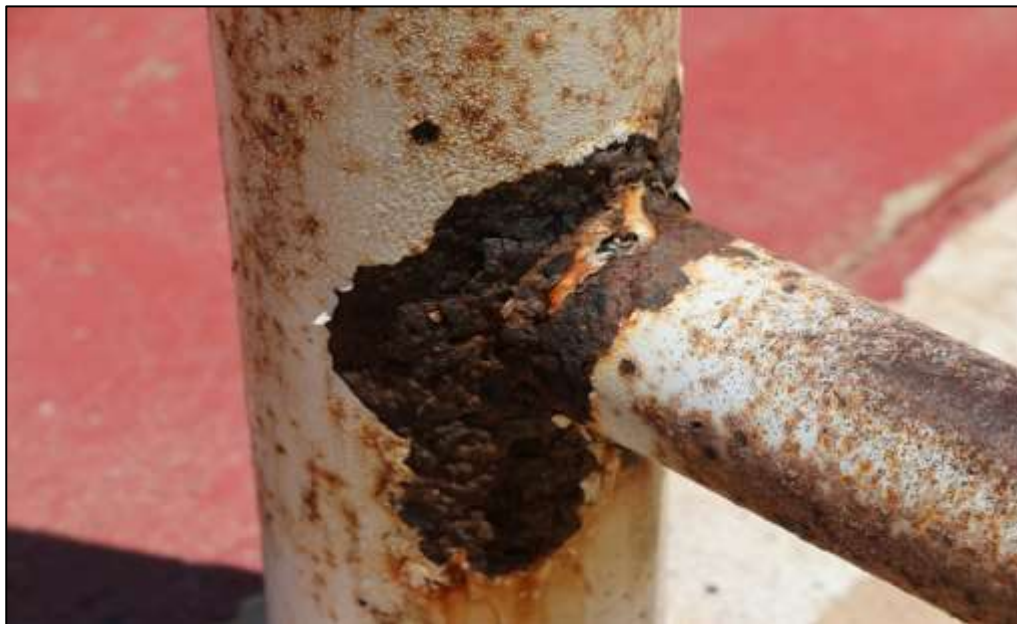
Fotografía 416 Detalle de la unión entre elementos metálicos, de una de las canchas deportivas instaladas en este escenario. Estos elementos evidenciaron oxidación profunda generalizada, pérdida parcial de la pintura de acabado (en algunas zonas por presencia de ampollas) y en algunas secciones, corrosión.
