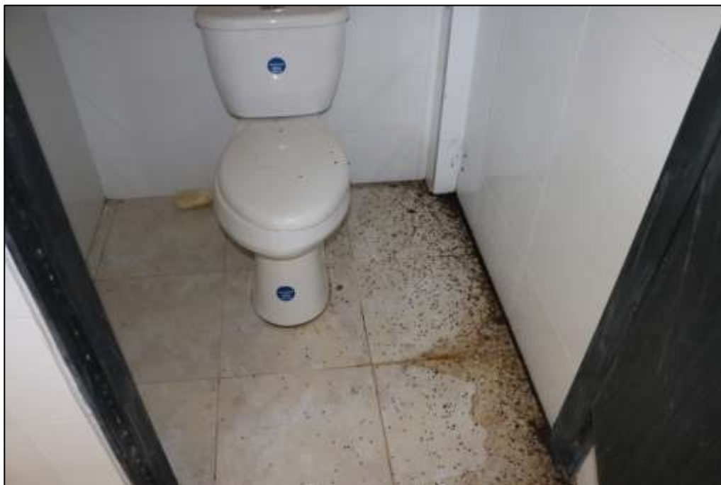
Fotografía 352 Detalle del cubículo para uno de los sanitarios instalados en el edificio administrativo. En varios de estos espacios, se evidenció manchado diferencial del enchape de piso y acumulación de materia orgánica (excremento de animales).
