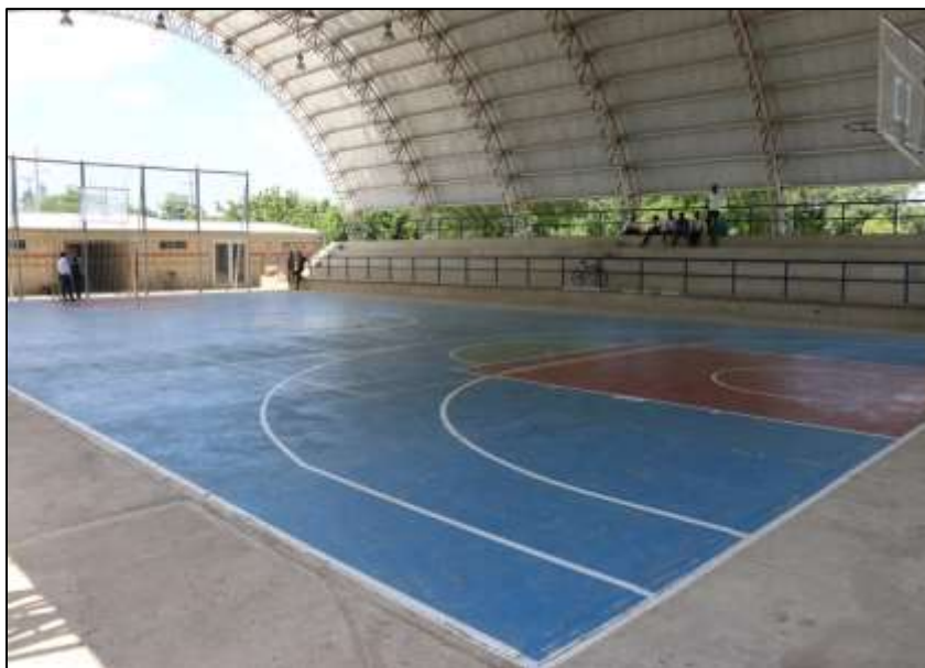
Fotografía 363 Vista general de la cancha multideportiva cubierta.
