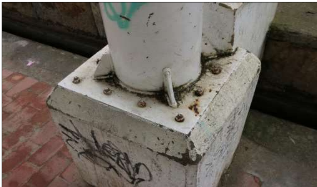
Fotografía 290. Detalle de la conexión metálica de una de las columnas de la estructura de cubierta, en su pedestal de concreto. Se evidenció en estos detalles constructivos, la presencia de óxido diferencial en la superficie de las platinas, tuercas y varillas roscadas.
