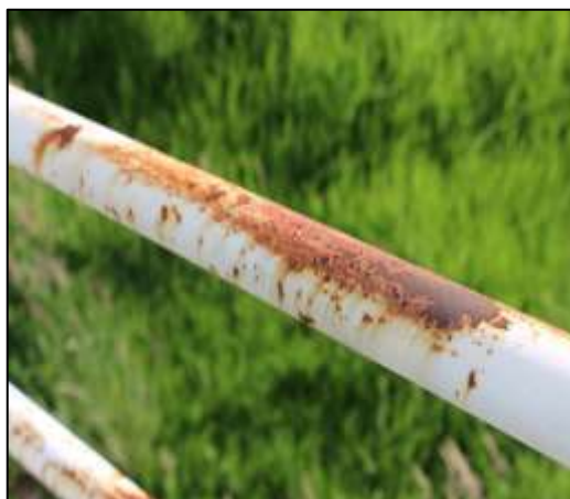
Fotografía 261. Detalle de una sección de baranda, de la escalera registrada en la imagen anterior. En la fotografía quedó registrado el nivel de oxidación de la baranda.
