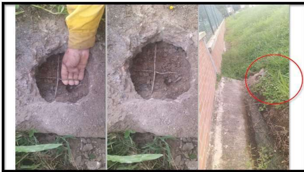
Fotografía 124. Verificación de refuerzo en cunetas
