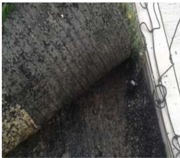
Fotografía N° 475. Levantamiento Grama Sintética
