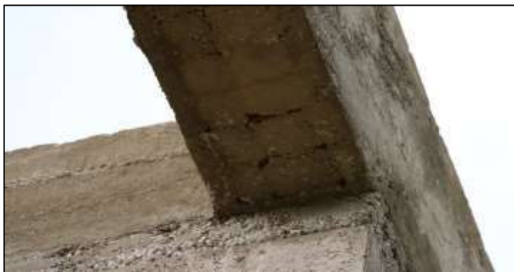
Fotografía 180. Detalle del nudo superior en uno de los pórticos de concreto construidos. Se evidenció, como lo registró la imagen, agregado y refuerzo de acero a la vista, en varias secciones de algunos concretos. Lo anterior, producto de baja calidad de obra.
