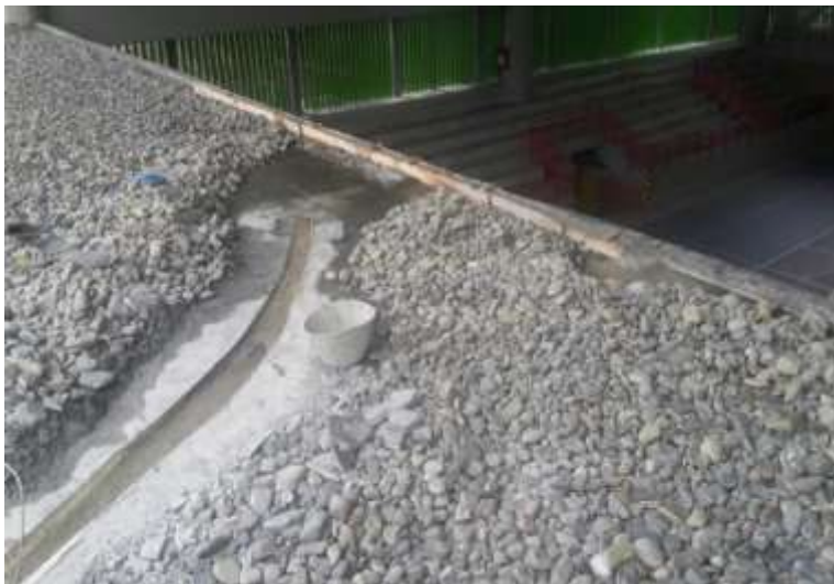
Fotografía N° 559. Reparación realizada por las personas de mantenimiento del Coliseo, esto ocasiona que se dañe la impermeabilización y se produzcan filtraciones al interior de la losa de concreto.
