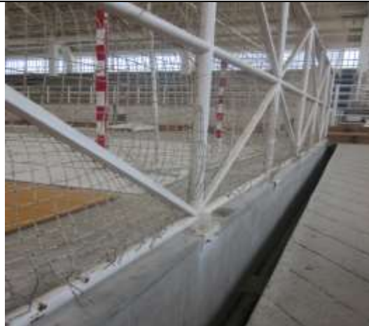
Fotografía 304 Malla eslabonada se encuentra en algunas áreas desprendida
