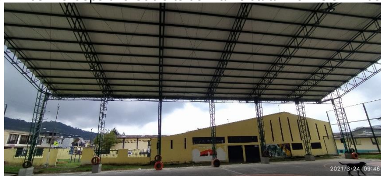
Foto N° 64. Polideportivo Cubierto del Barrio Jaramillo – OCI 24-03-2021
