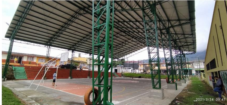
Foto N° 65. Polideportivo Cubierto del Barrio Jaramillo – OCI 24-03-2021
