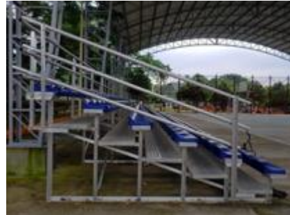
Foto N° 92 La Gradería no permite Transito ni Evacuación
