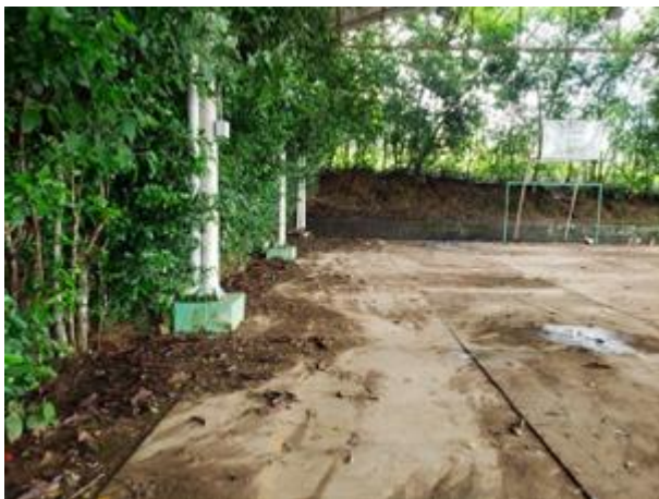
Foto N° 19. Niveles Diferenciales de Placas
