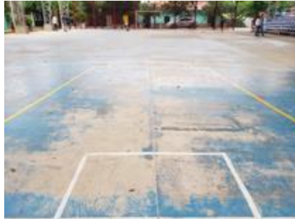
Foto N° 91 Mantenimiento Pintura de Canchas
