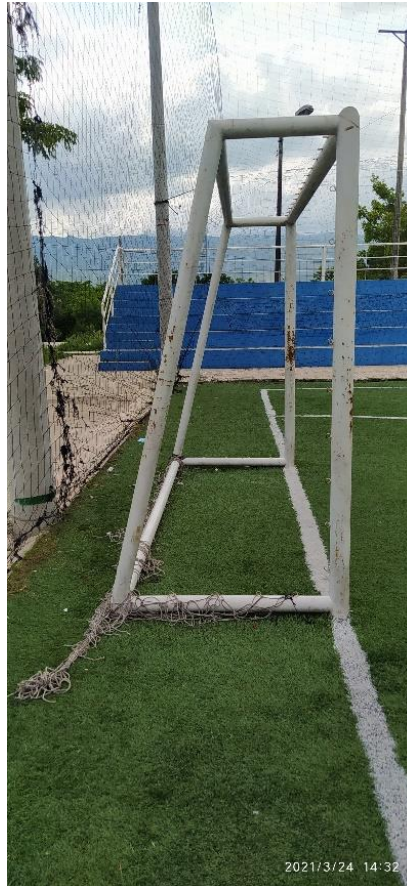
Foto N° 49. Deterioro de las mallas de los arcos de la cancha – OCI 24-03-2021
