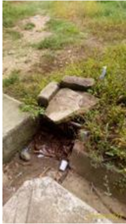
Foto N° 68 Tapa de desagüe rota Foto N° 69 Limpieza de canales Foto N° 70 Cárcamos sin Rejillas
