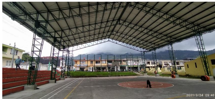
Foto N° 63. Polideportivo Cubierto del Barrio Jaramillo – OCI 24-03-2021
