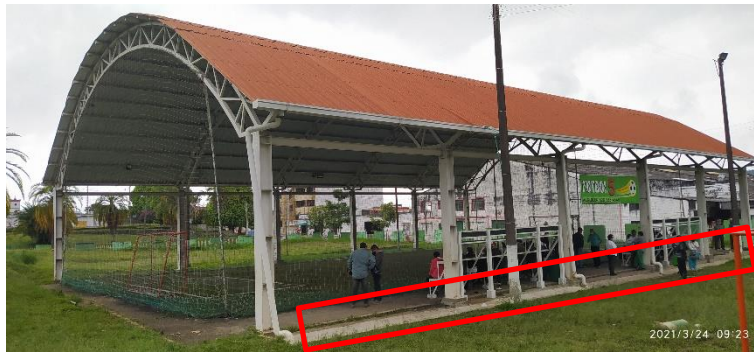
Foto N° 56. Canal para conducción de Aguas lluvias – OCI 24-03-2021
