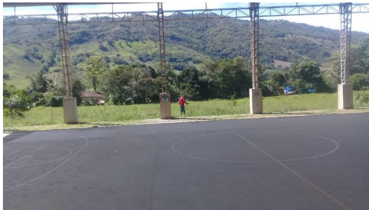
Foto N° 103. Mantenimiento Polideportivo - Vereda La Manga – Secretaria De Planeación Obras Civiles Y TIC Municipio Valle De San Juan 30-03-2021
