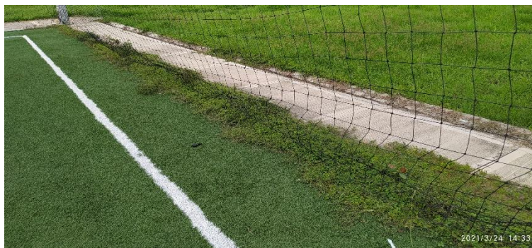
Foto N° 43. Levantamiento grama en unión del material – OCI 24-03-2021
