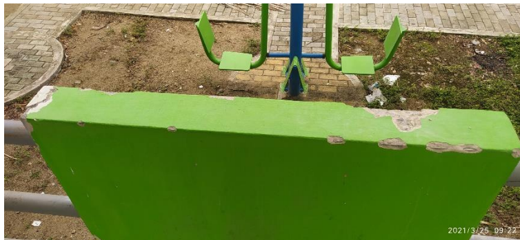
Foto N° 4. Desprendimiento pintura en antepechos – OCI 25-03-2021
