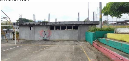
Foto N° 36. Baños en construcción Polideportivo 12 de octubre – OCI 26-03-2021
