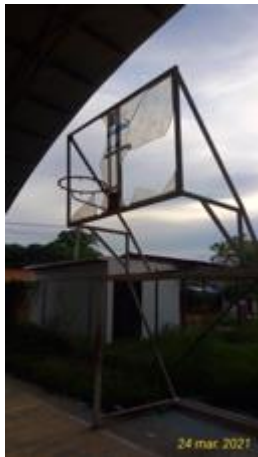
Foto N° 88 Tableros Acrílicos Rotos Deteriorada
