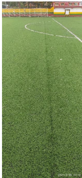
Foto N° 35. Levantamiento grama en unión – OCI 24-03-2021
