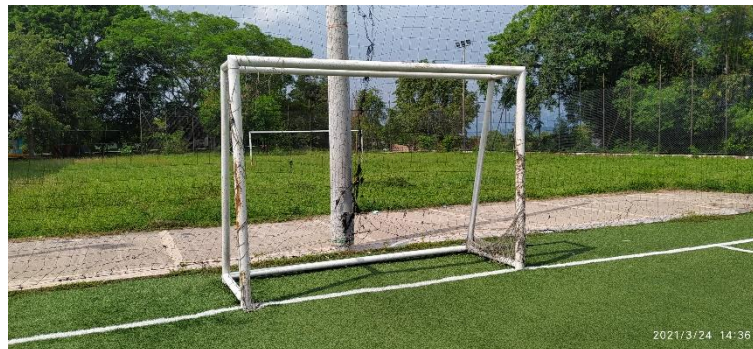
Foto N° 45. Corrosión en arcos de la cancha – OCI 24-03-2021
