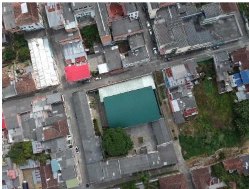
Foto 8. Convenio N°1150 De 2017 “ADECUACIÓN Y MEJORAMIENTO DE ESCENARIO DEPORTIVO INSTITUCIÓN EDUCATIVA SAN ANDRÉS MUNICIPIO DE QUINCHÍA”
