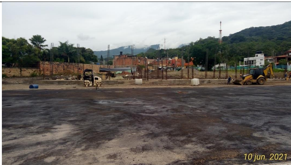
Foto No. 26. Vista desde la pista de alta velocidad hacia cimentación de Graderías
