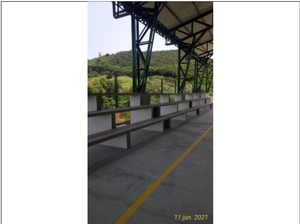
Foto N°. 21. Medida de 0.50 cm en huella y 0.50 cm de contrahuella de graderías, área destinada a circulación, permanencia de espectador y transito a graderías superiores
