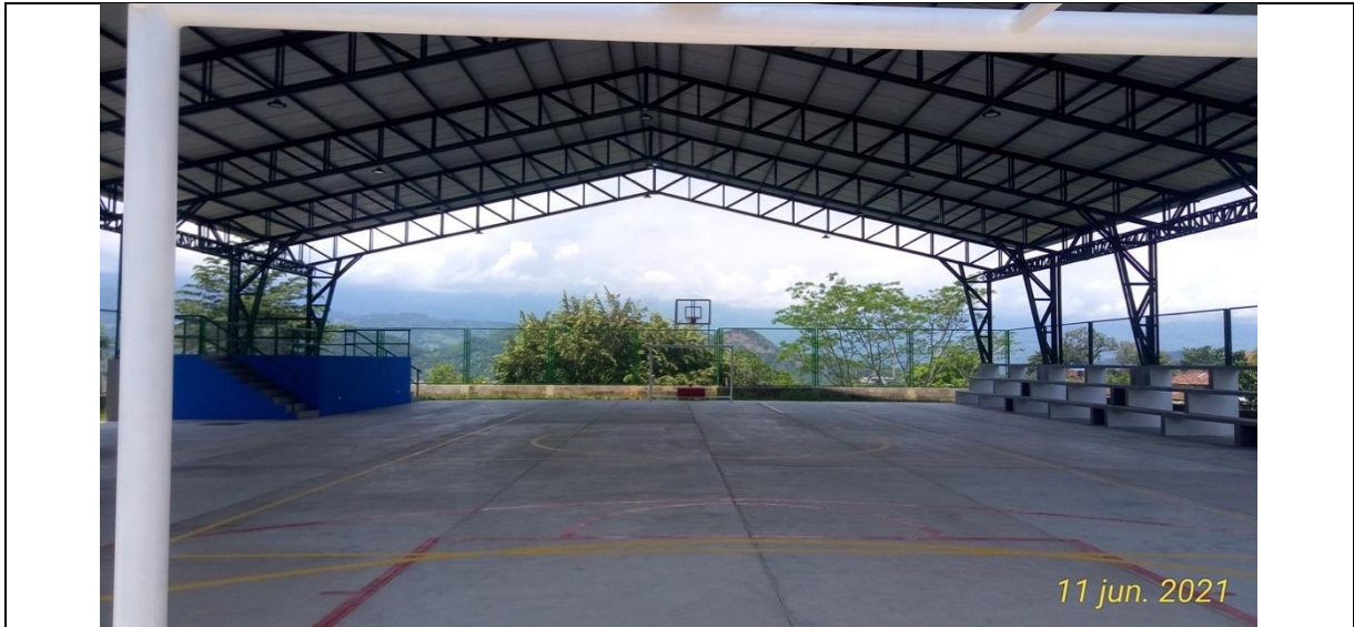
Foto N°. 15. Evidencia de estado terminado de la obra, Convenio Interadministrativo no. 1180 Aunar esfuerzos técnicos, administrativos y financieros entre Coldeportes y el Municipio de Anapoima, Cundinamarca, para la ejecución del proyecto denominado "Construcción Polideportivo, gradería, cubierta y cerramiento barrio Altos de Santorini Municipio de Anapoima" OCI 11/06/2021
