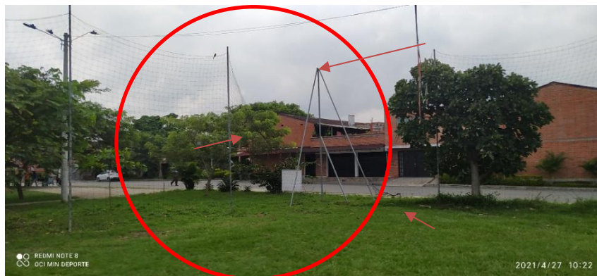
Foto No 12. Evidencia de deficiencia en la instalación de malla de cerramiento de cancha Urbanización La Aldea Corregimiento Villagorgona – OCI 27/04/2021.
