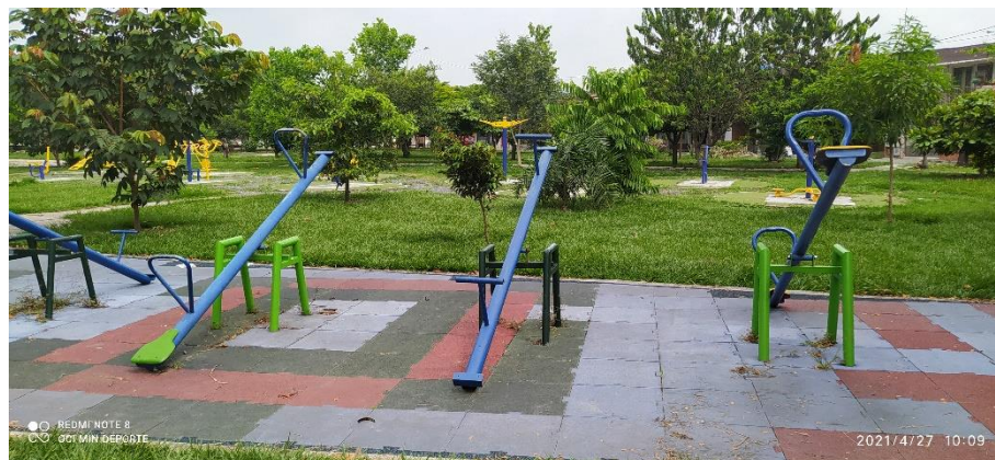
Foto No 4. Evidencia elementos no instalados en parque infantil y desniveles en piso táctil del parque infantil Urbanización La Aldea Corregimiento Villagorgona – OCI 27/04/2021
