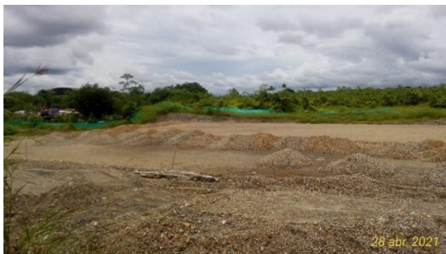
Foto N.º14. Evidencia estado actual de la obra Convenio N.º. 854 de 2017, "Aunar esfuerzos técnicos, administrativos y financieros entre Coldeportes y el Municipio de Condoto-Choco, para la ejecución del proyecto denominado "Construcción de cancha de futbol con césped sintético en el Municipio de Condoto – Occidente Choco" – OCI 28/04/2021
