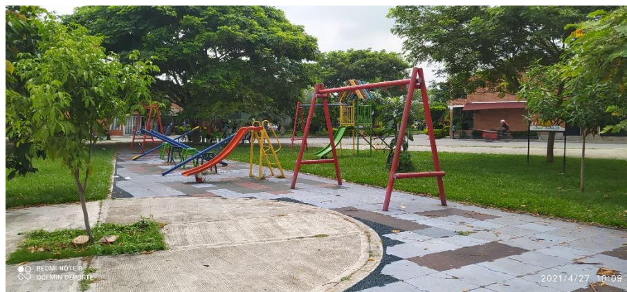
Foto No 7. Desnivel en piso, losa táctil parque infantil Urbanización La Aldea Corregimiento Villagorgona – OCI 27/04/2021
