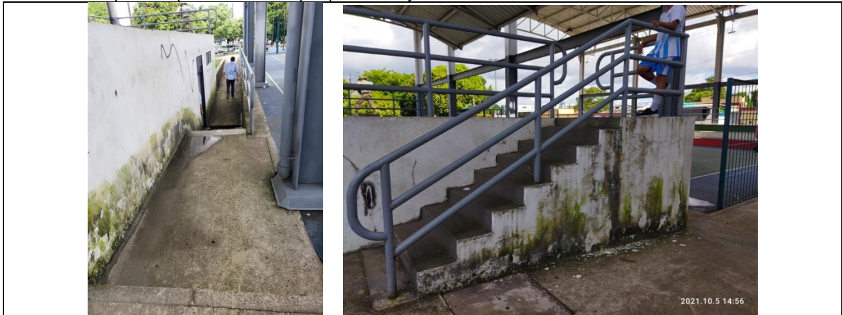
Foto 2. Muros placa deportiva cubierta, parque infantil y biosaludable Juan XXIII
