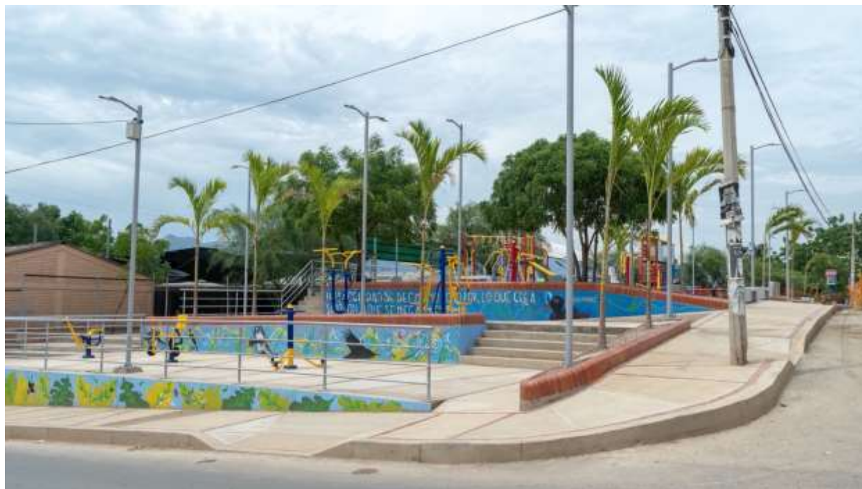
Imagen 20. Rampas y escaleras en espacios recreativos, Norte de Santander. Fuente: MINDEPORTE
