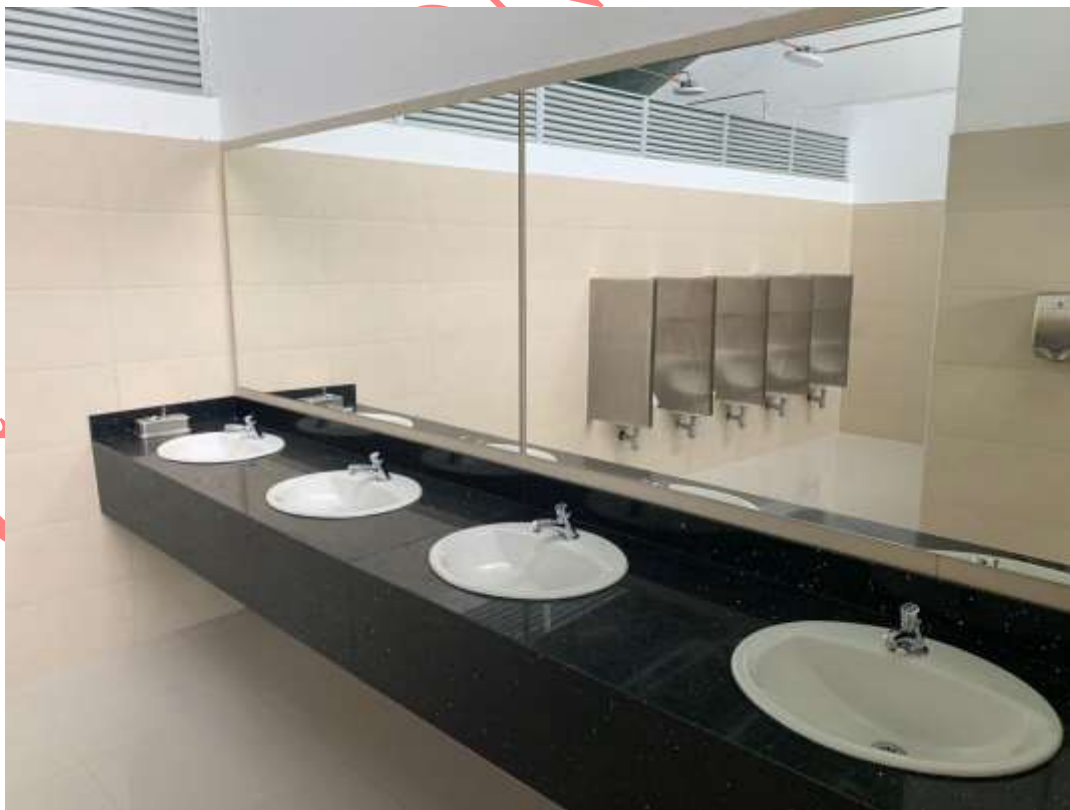
Imagen 22. Baterías sanitarias, Unidad deportiva, Quibdó, Chocó. Fuente: MINDEPORTE
