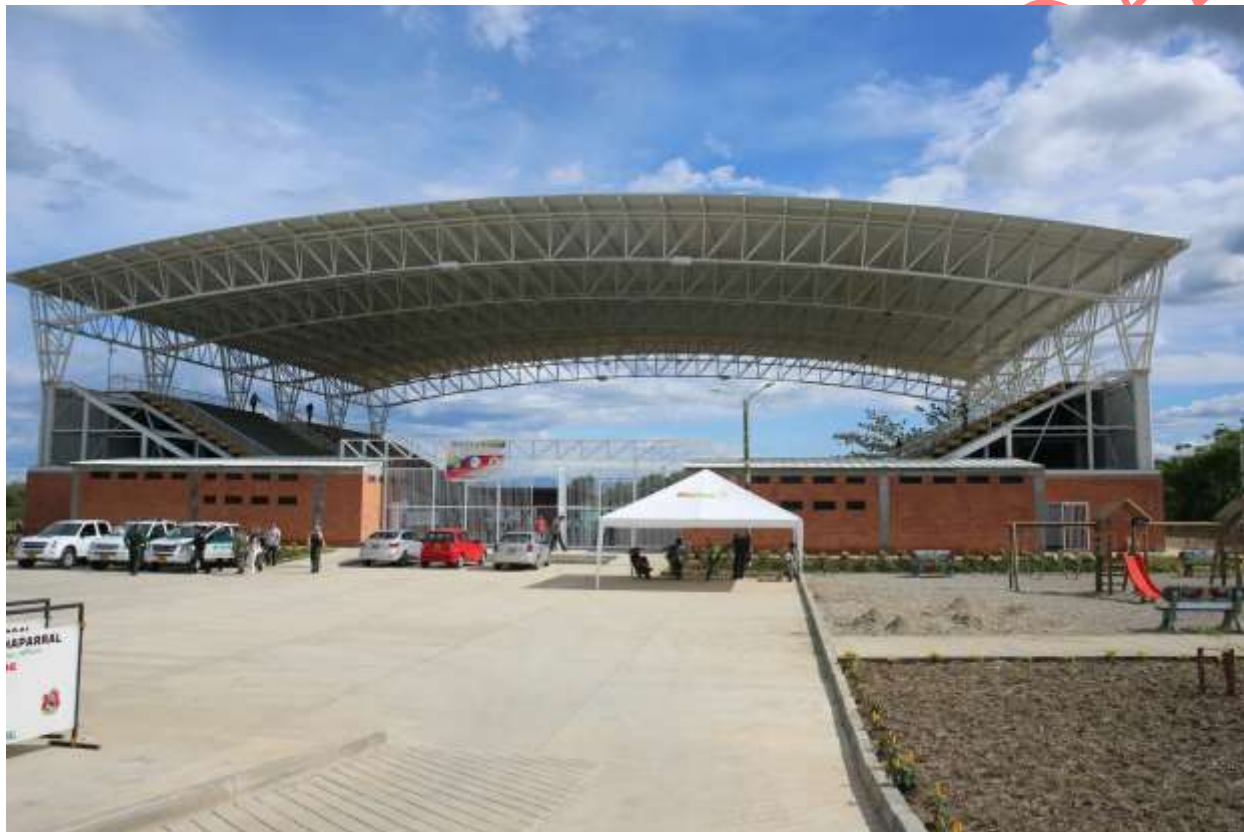
Imagen 21. Acceso y zona de parqueaderos, Coliseo Chaparral Tolima. Fuente: MINDEPORTE
