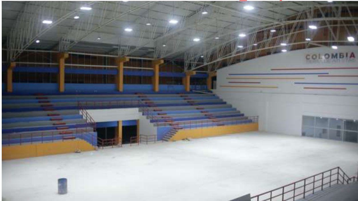
Imagen 19. Puntos de evacuación, Coliseo Luis Yarzagaray, Arjona, Bolívar. Fuente: MINDEPORTE
