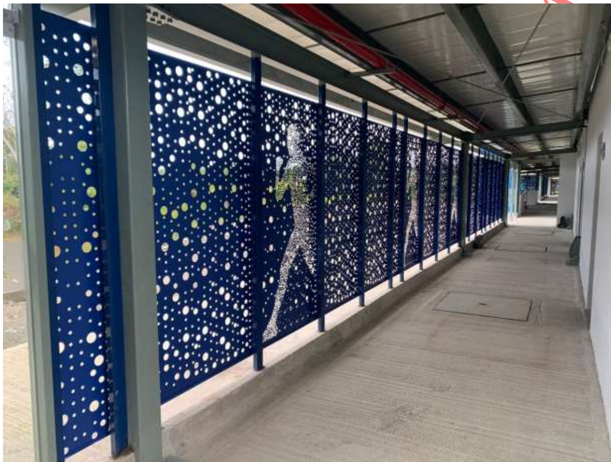
Imagen 27. Cerramiento en fachada, unidad Deportiva, Quibdó, Chocó. Fuente: MINDEPORTE.
