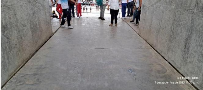
Plataforma de ingreso a la zona de graderías, donde se evidencia junta entre elementos estructurales sin protección
