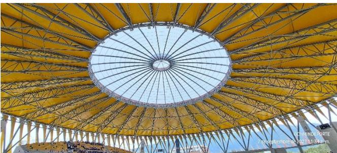
Vista interna cubierta en estructura metálica y membrana
