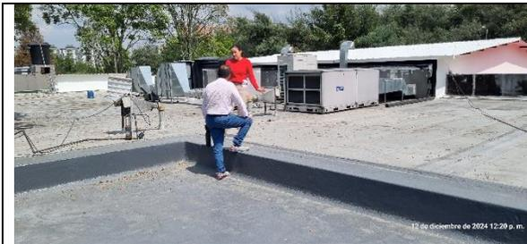
Impermeabilización de cubierta con poliurea.
