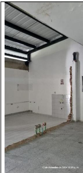
Apoyo estructura de cubierta nueva sobre estructura viciada.
