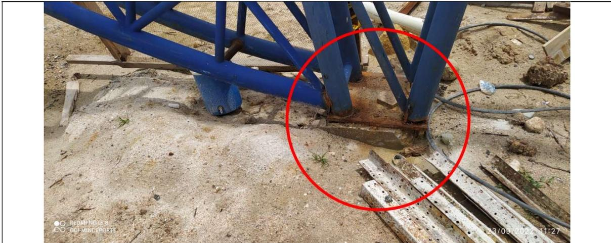
En la construcción de la estructura de cubierta de la gradería del estadio municipal de Softbol ubicado en el municipio de Fundación, se evidencia debilidades en los procesos de soldadura, elementos con corrosión, elementos que no cumplen la longitud para el ensamble. No es posible verificar planos de taller de la estructura metálica ni despiece de los elementos de estructura metálica.
