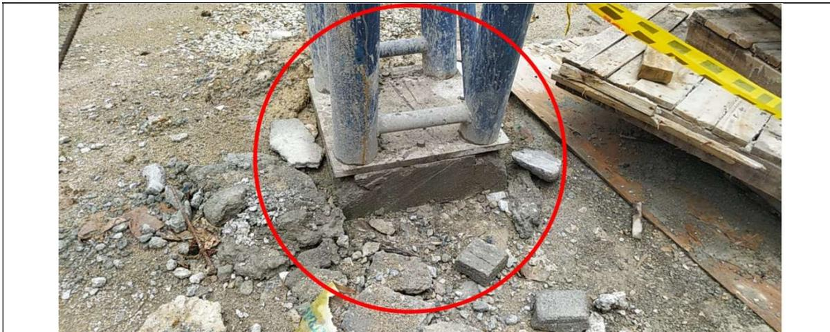
En la construcción de la estructura de cubierta de la gradería del estadio municipal de Softbol ubicado en el municipio de Fundación, se evidencia debilidades en los pedestales en concreto reforzado y conexión con la estructura metálica, como se evidencia en la imagen.
