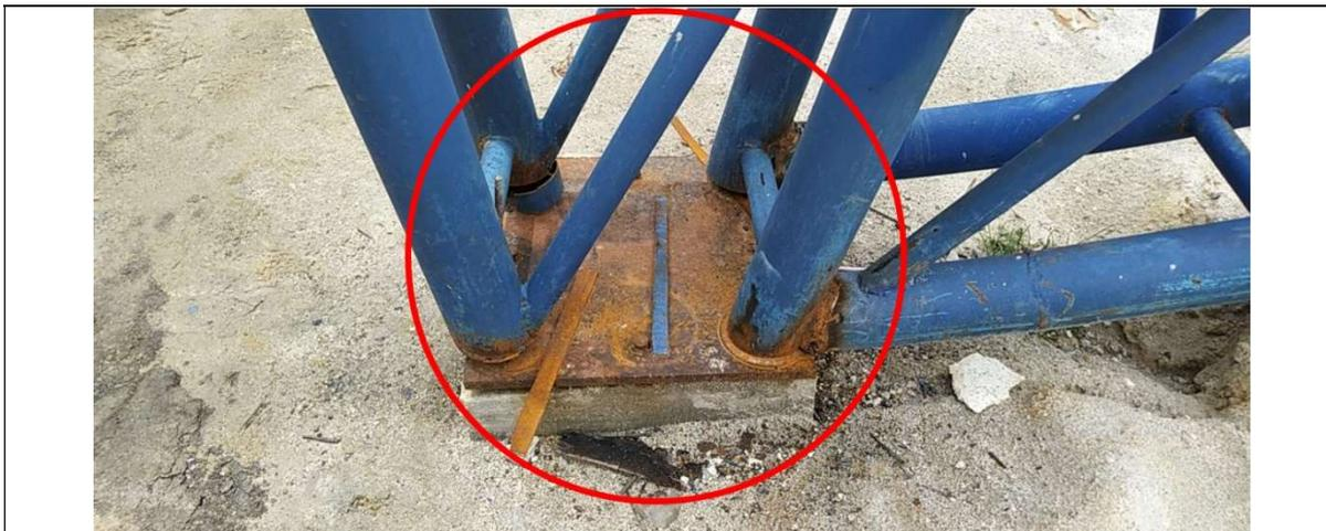
En la construcción de la estructura de cubierta de la gradería del estadio municipal de Softbol ubicado en el municipio de Fundación, se evidencia debilidades en los procesos de soldadura. No se evidencia la aplicación de pruebas para verificación de la calidad del proceso de soldadura. Se evidencia que hay elementos que no tienen la longitud correspondiente, lo cual con lleva a realizar labores de ajuste de la longitud de los elementos.
