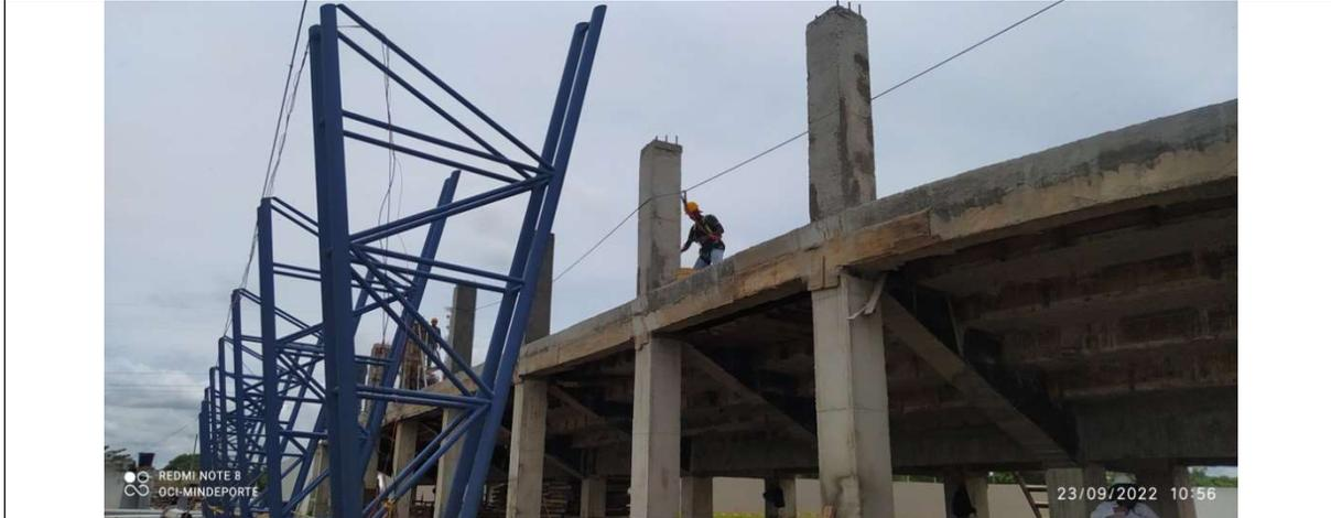
En la construcción de la estructura de cubierta de la gradería del estadio municipal de Softbol ubicado en el municipio de Fundación, se evidencia debilidad en el cumplimiento del Sistema de Gestión de la Seguridad y Salud en el trabajo, donde se observó las líneas de vida no se encontraban instaladas correctamente, poniendo en riesgo a los trabajadores que realizaban trabajo en alturas.
