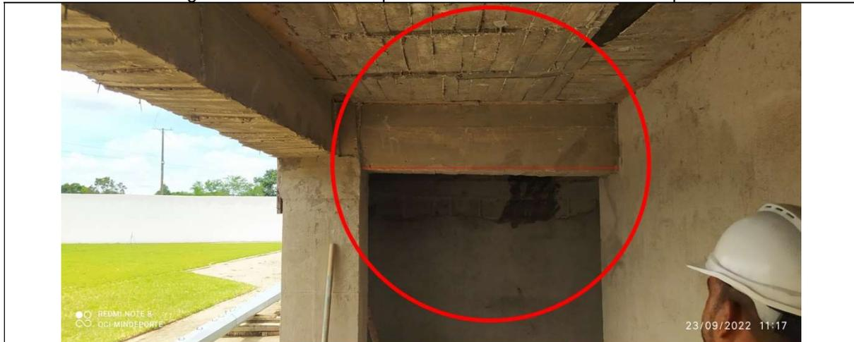
En la construcción de la gradería del estadio municipal de Softbol ubicado en el municipio de Fundación, se evidencia desniveles en algunos elementos estructurales, aparentemente por efecto de la formaleta utilizada.
