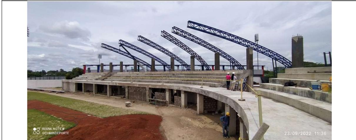
En la construcción de la estructura de cubierta de la gradería del estadio municipal de Softbol ubicado en el municipio de Fundación, no es posible verificar la aplicación de pruebas de calidad a las soldaduras, existiendo elementos izados y que se encuentran a una altura considerable, lo cual puede dificultar la labor de aplicación de las pruebas correspondientes.
