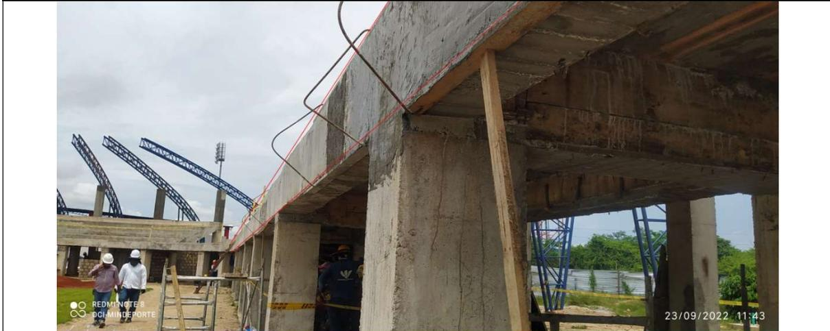
En la construcción de la gradería del estadio municipal de Softbol ubicado en el municipio de Fundación, se evidencia que, para la construcción de los elementos estructurales de gradería, fue utilizada formaleta en madera y presentan deformaciones, las cuales pueden llegar a generar afectación al momento de la instalación del acabado final.
