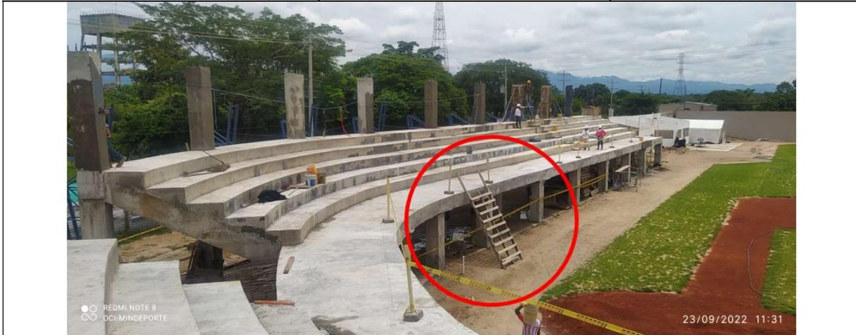
En la construcción de la estructura de cubierta de la gradería del estadio municipal de Softbol ubicado en el municipio de Fundación, se evidencia debilidad en el cumplimiento del Sistema de Gestión de la Seguridad y Salud en el trabajo, donde se observó inadecuada disposición de escaleras para acceso a la parte superior de las graderías, como se observa en la imagen.
