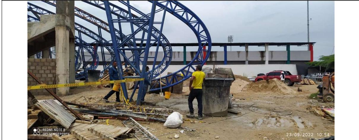
En la construcción de la estructura de cubierta de la gradería del estadio municipal de Softbol ubicado en el municipio de Fundación, se evidencia debilidad en el cumplimiento del Sistema de Gestión de la Seguridad y Salud en el trabajo, donde se observó que parte del personal no portaba debidamente los elementos de protección personal.
