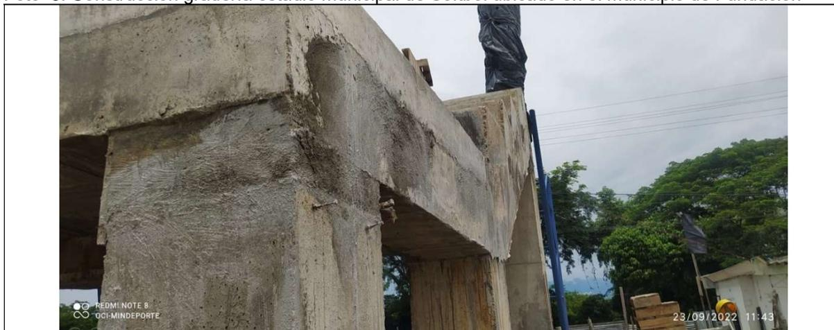
En la construcción de la gradería del estadio municipal de Softbol ubicado en el municipio de Fundación, se observa las reparaciones realizadas para lograr el alineamiento del elemento, para lo cual no es posible verificar el uso del aditivo respectivo.
