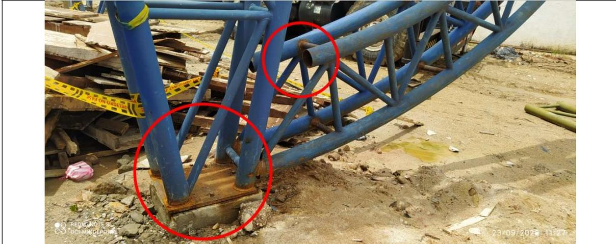
En la construcción de la estructura de cubierta de la gradería del estadio municipal de Softbol ubicado en el municipio de Fundación, se evidencia debilidades en los procesos de soldadura, elementos con corrosión, elementos que no cumplen la longitud para el ensamble. No es posible verificar planos de taller de la estructura metálica ni despiece de los elementos de estructura metálica.
