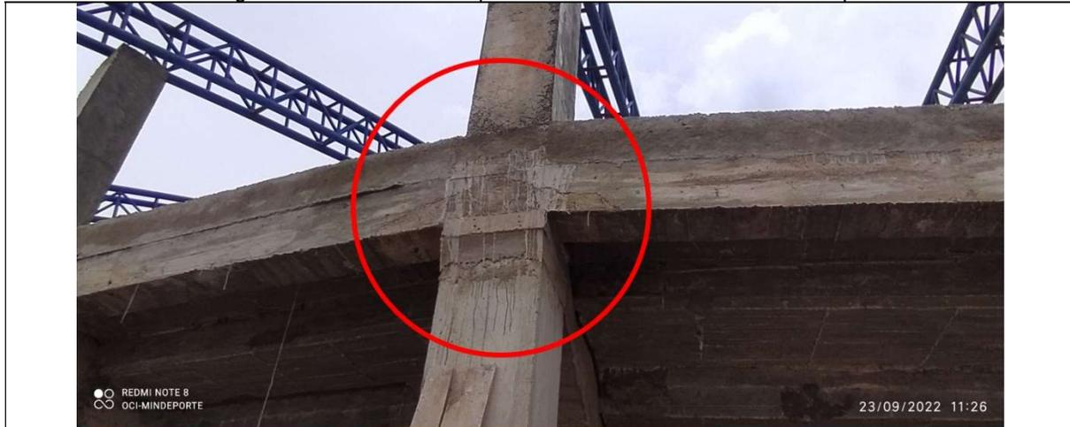
En la construcción de la gradería del estadio municipal de Softbol ubicado en el municipio de Fundación, se evidencia discontinuidad de los elementos estructurales en los nudos entre vigas y columnas.
