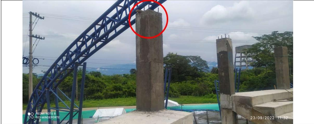
En la construcción de la estructura de cubierta de la gradería del estadio municipal de Softbol ubicado en el municipio de Fundación, se evidencia posibles debilidades en la conexión entre la estructura metálica de cubierta y los elementos de estructura en concreto reforzado de la gradería.
