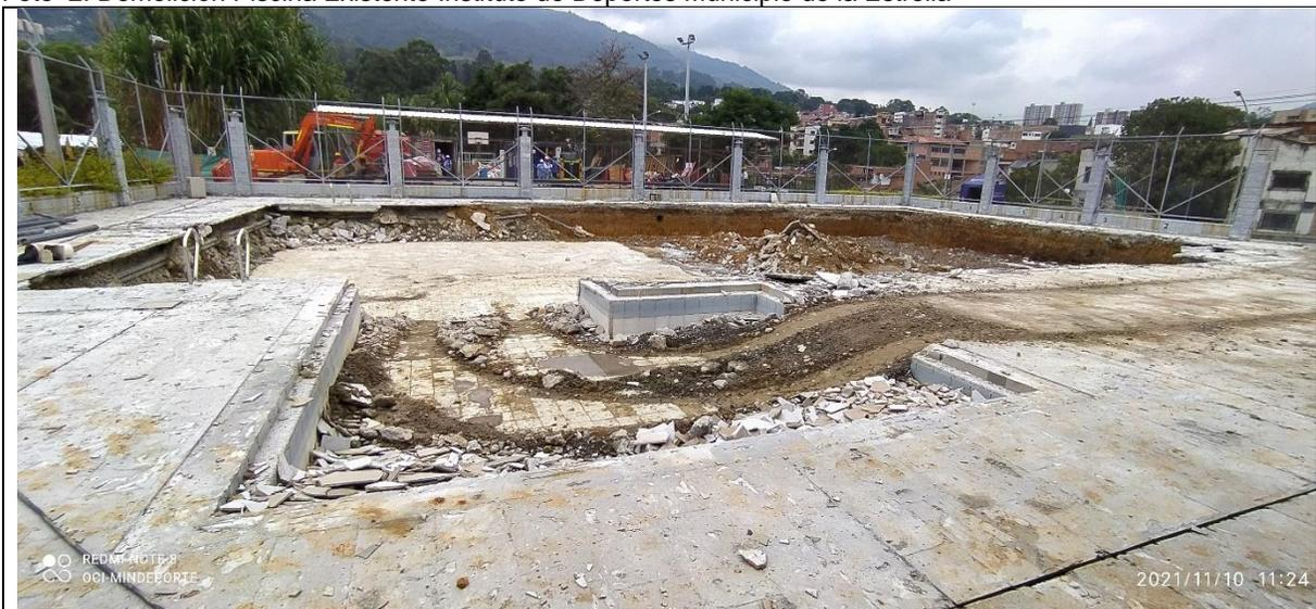
Se evidencia avance proceso de demolición piscina existente en el escenario deportivo
