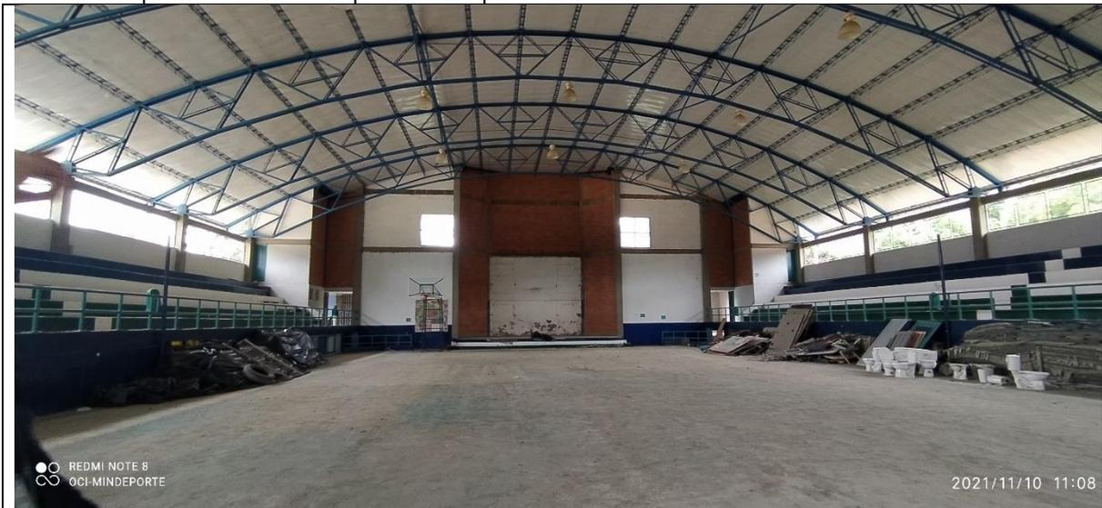
En el polideportivo se realizó retiro del piso existente y muro de escalada
