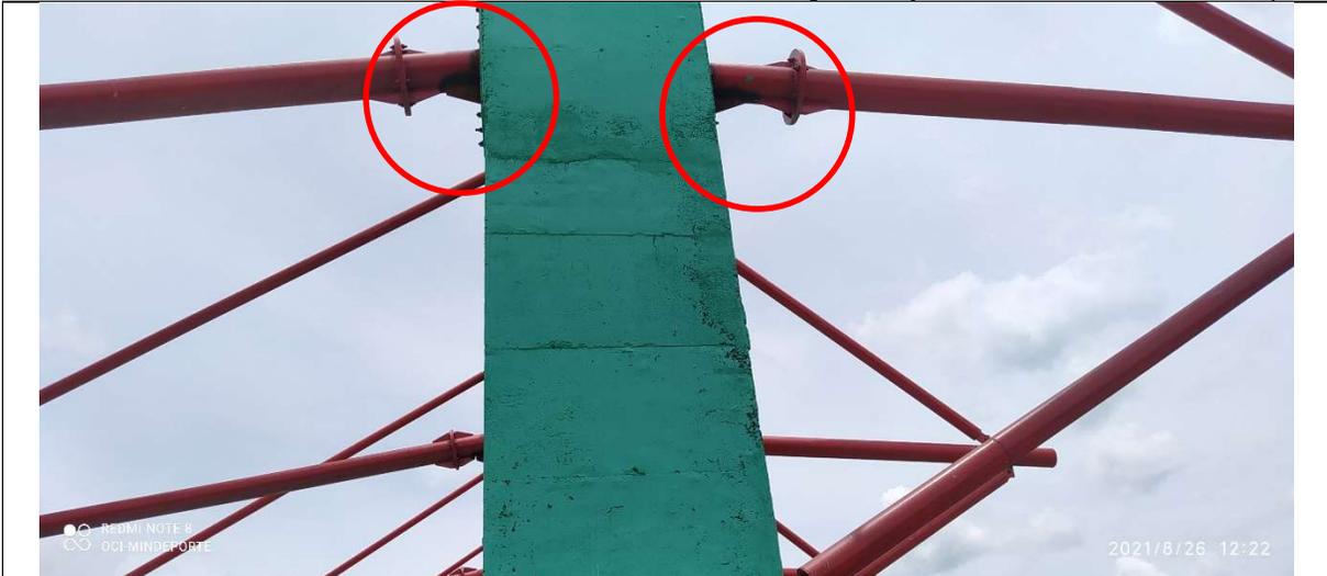
En las actividades ejecutadas del contrato de obra derivado del convenio 1384 de 2017, “*Construcción del estadio de fútbol José Chelo de Castro en el municipio de Aracataca - Magdalena*”, se evidencia corrosión en estructura metálica de cubierta instalada.
