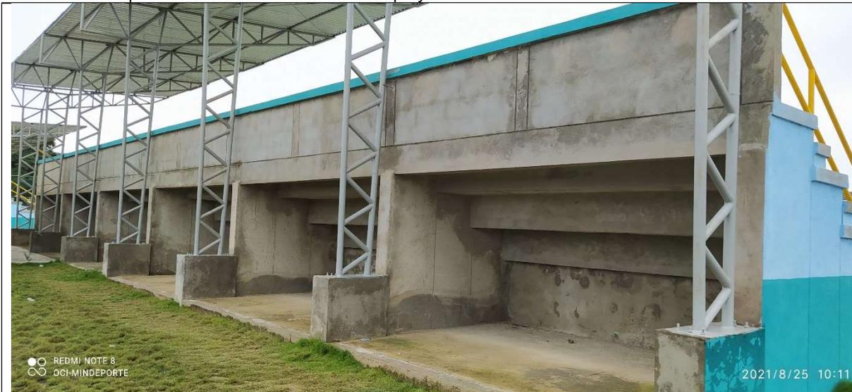
Se evidencia la falta de pintura en elementos metálicos del cerramiento, rejilla de canal perimetral y estructura metálica de cubierta de graderías
