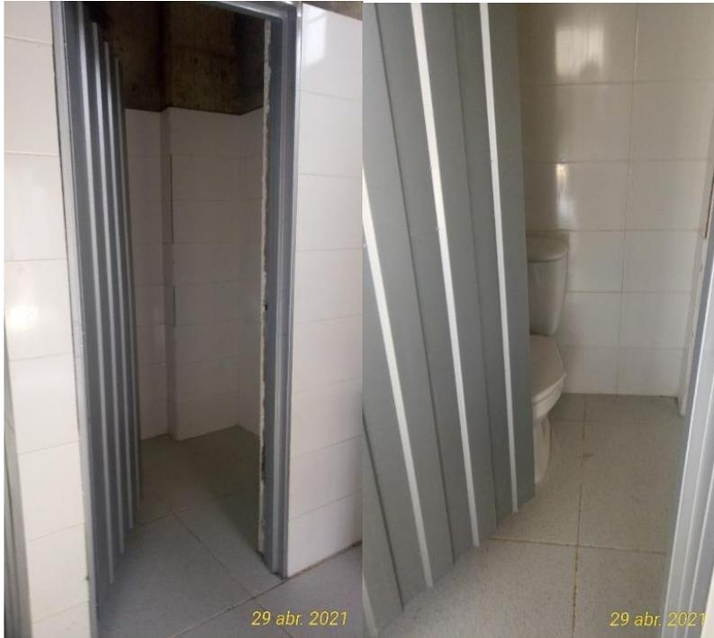
Foto No 1. Evidencia baño Mujeres (dentro de la batería de baños mujeres la unidad destinada Personas con Movilidad Reducida presenta apertura de la puerta hacia interior y vano de 0.70) – OCI 29/04/2021
