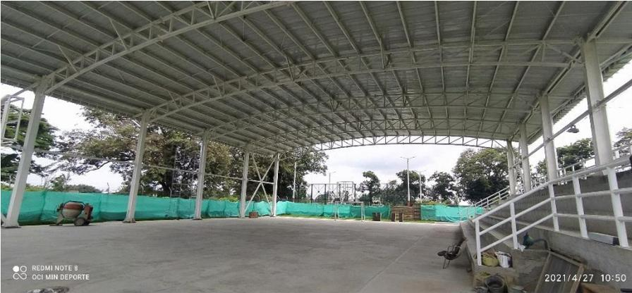
Foto N° 7. Evidencia avance de obra en actividad de cubierta sin supervisión técnica por parte de interventoria – OCI 27/04/2021
