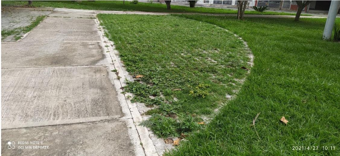
Foto N° 18. Evidencia falta mantenimiento y desnivel en piso gramoquin Urbanización La Aldea Corregimiento Villagorgona – OCI 27/04/2021
