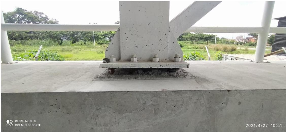
Foto N° 13. Conexión estructura metálica sin terminar en cancha cubierta en la urbanización Zafra – OCI 27/04/2021
