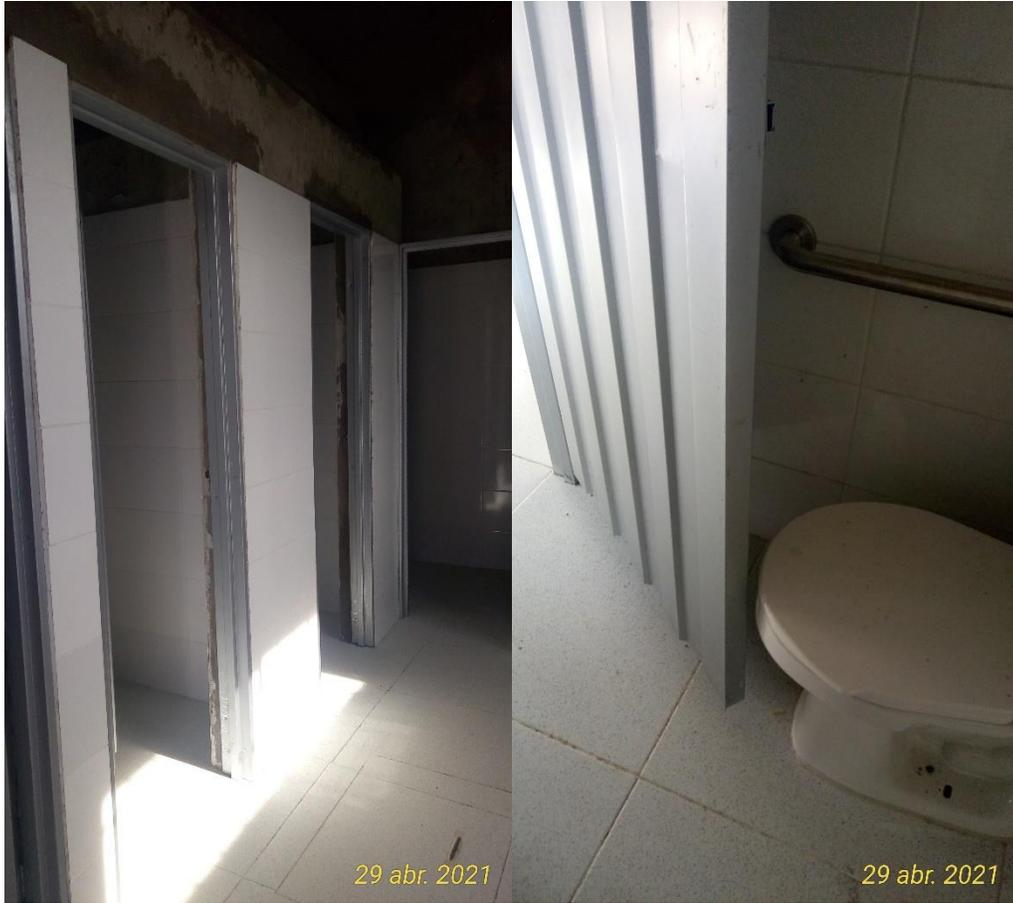
Foto N° 38. Vista batería baños mujeres, con unidad sanitaria para Personas con Movilidad Reducida (no permite acceso y/o maniobra, se sugiere cambio dirección de apertura de la hoja de la puerta hacia el exterior) Convenio 725-2019 – OCI 29/04/2021
