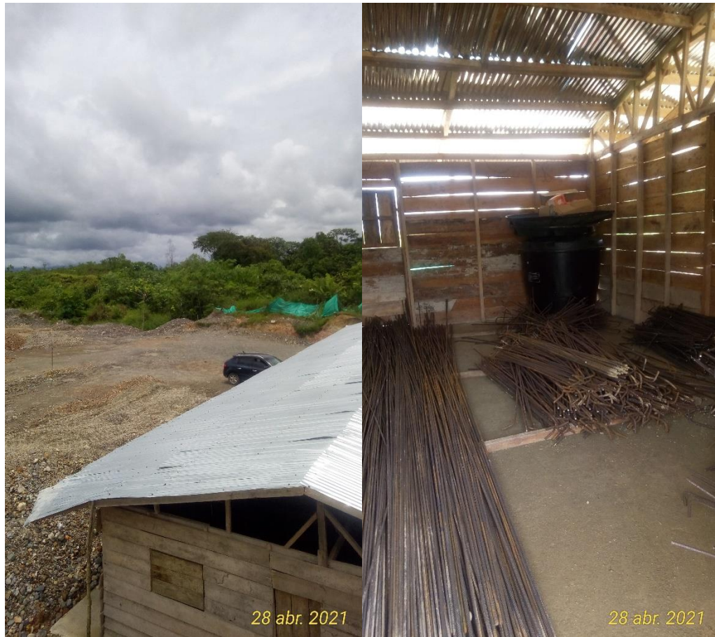
Foto N° 18. Vista campamento / deposito materiales obra Cancha de Futbol Condoto – OCI 28/04/2021
