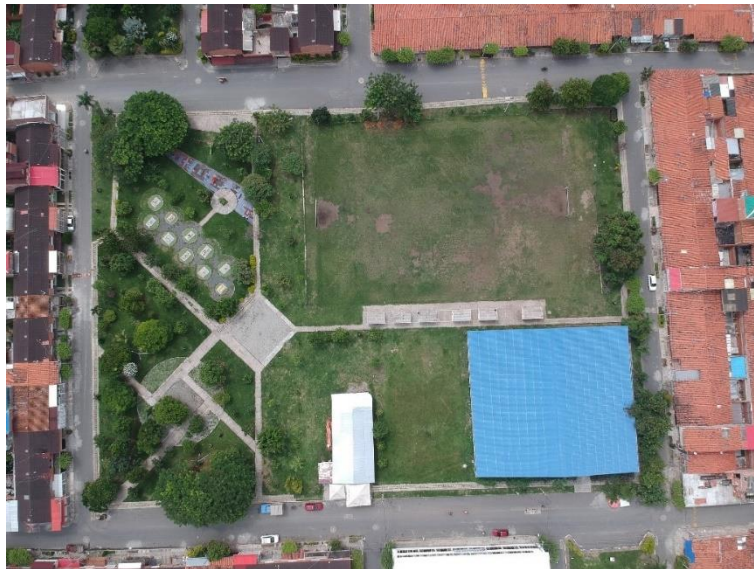
Foto No 1. Vista aérea Construcción Parque Urbanización La Aldea Corregimiento Villagorgona – OCI 27/04/2021
