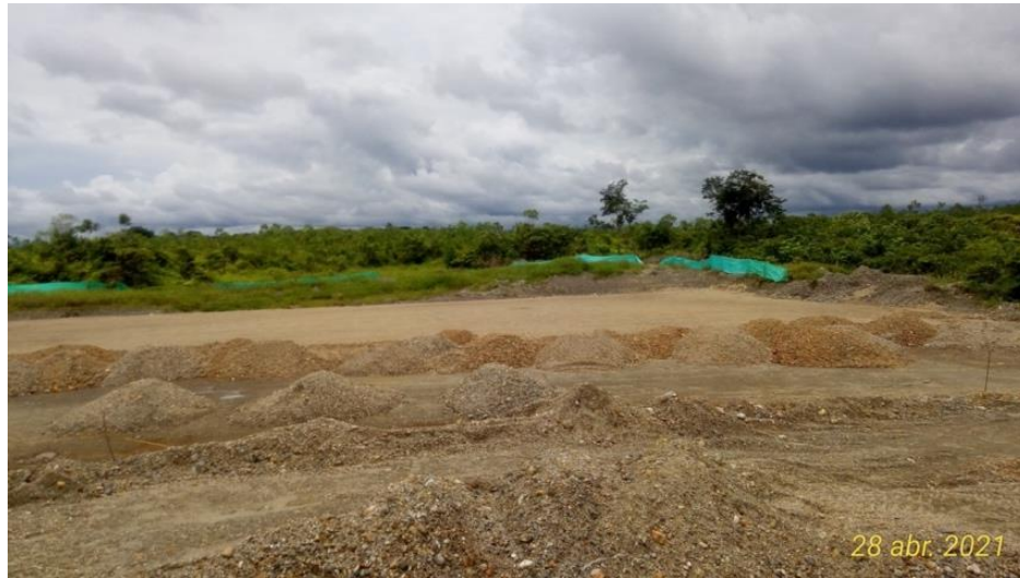
Foto N° 17. Evidencia estado actual de la obra Convenio 854-2017 Construcción Cancha de Futbol con Césped Sintético, municipio de Condoto– OCI 28/04/2021
