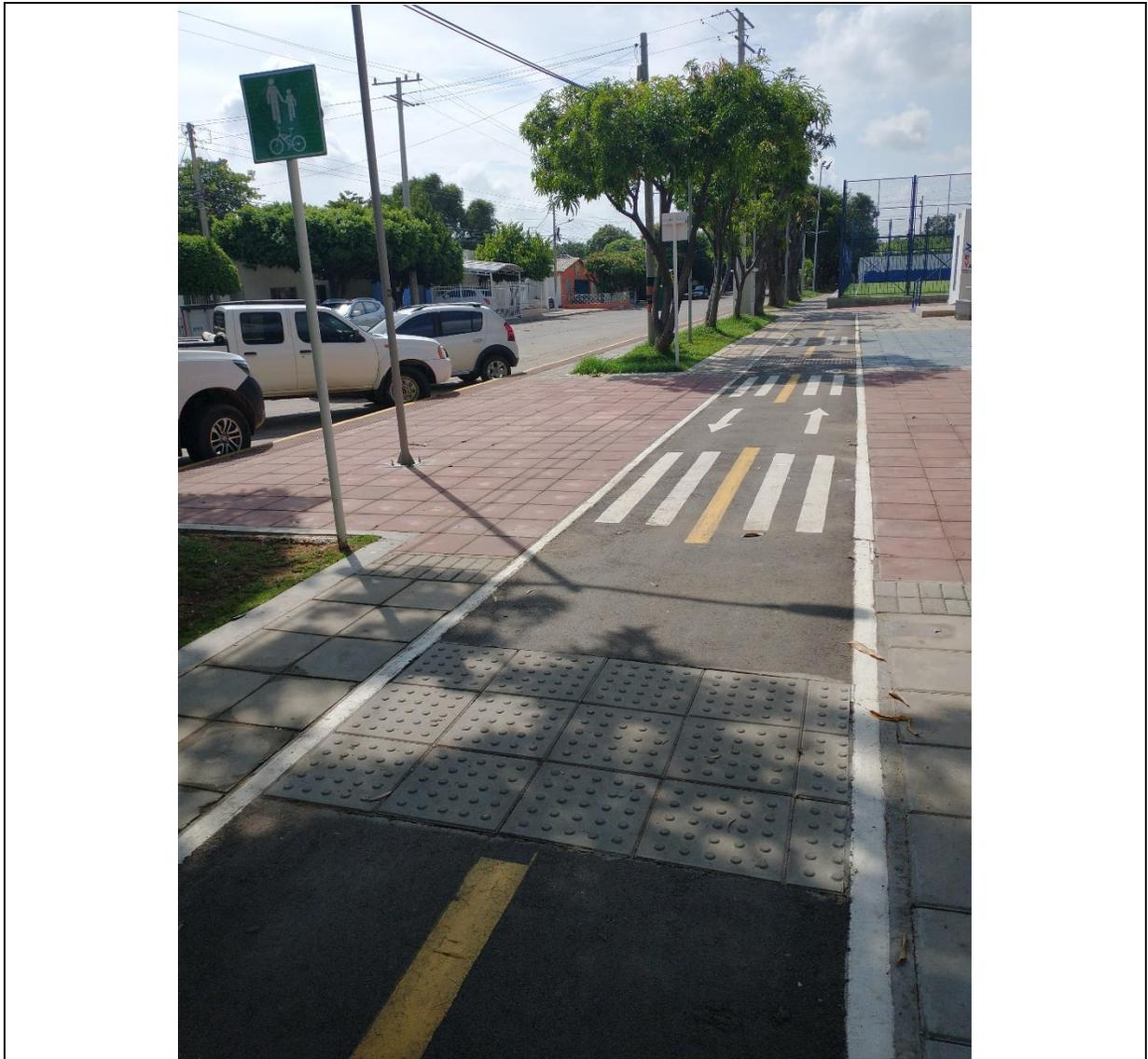
**Foto No.22.** Señalización podotáctil para cruce de cicloruta.
