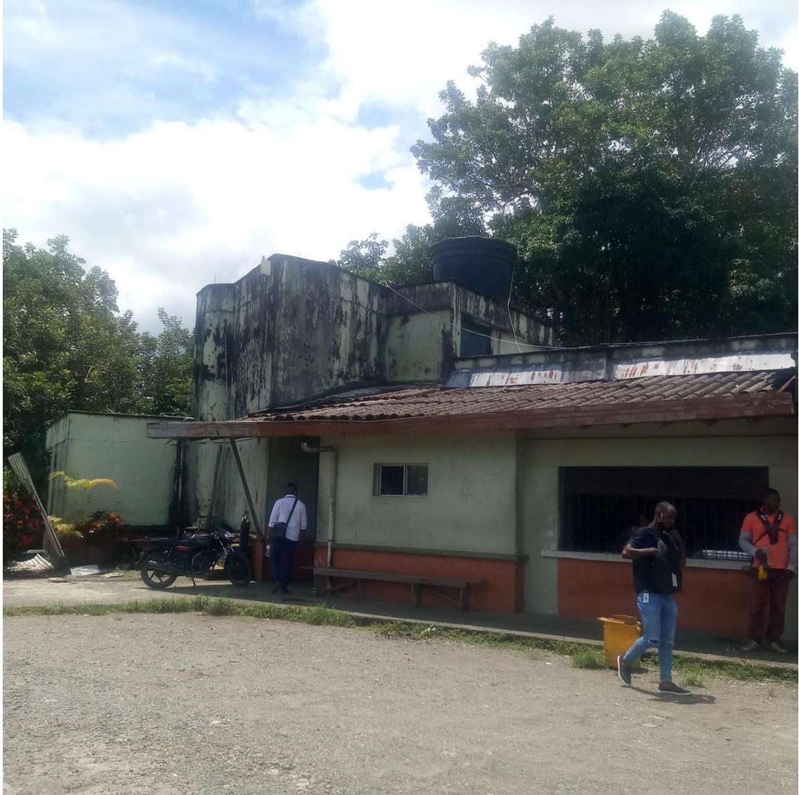
Foto No.11 Edificio de atletismo.
