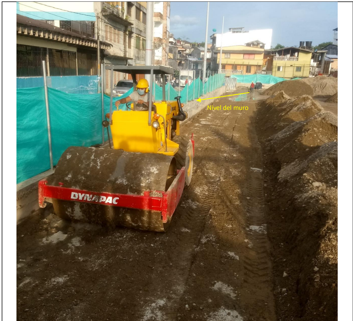
Foto No.22 Obras de compactación del terreno a medida que se va rellinando. El nivel de relleno es aproximadamente 20 a 30 cm por debajo del nivel del muro de contención
