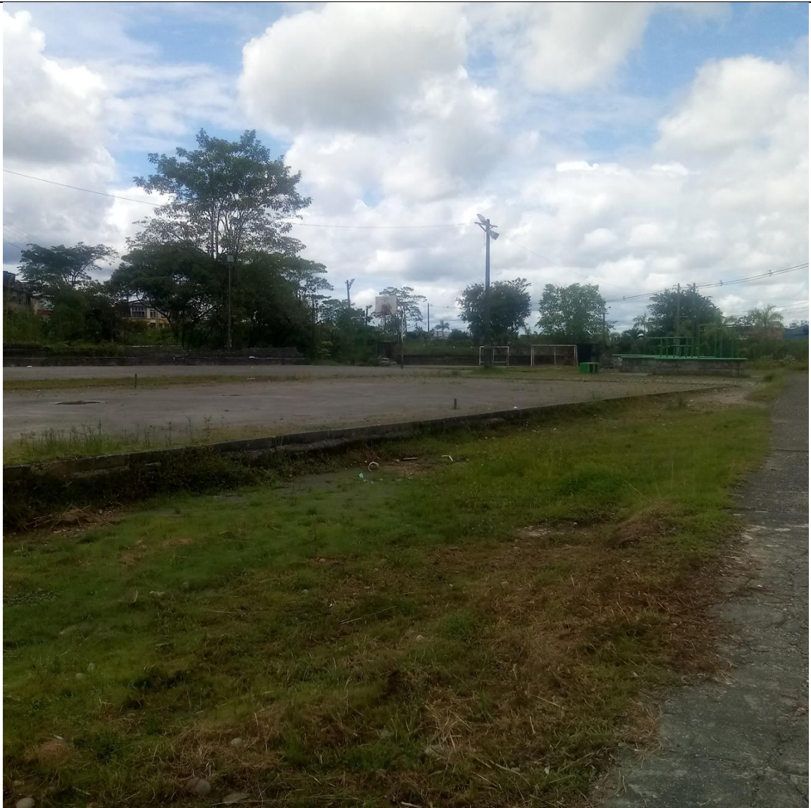
Foto No.14 Estado actual Multicanchas
