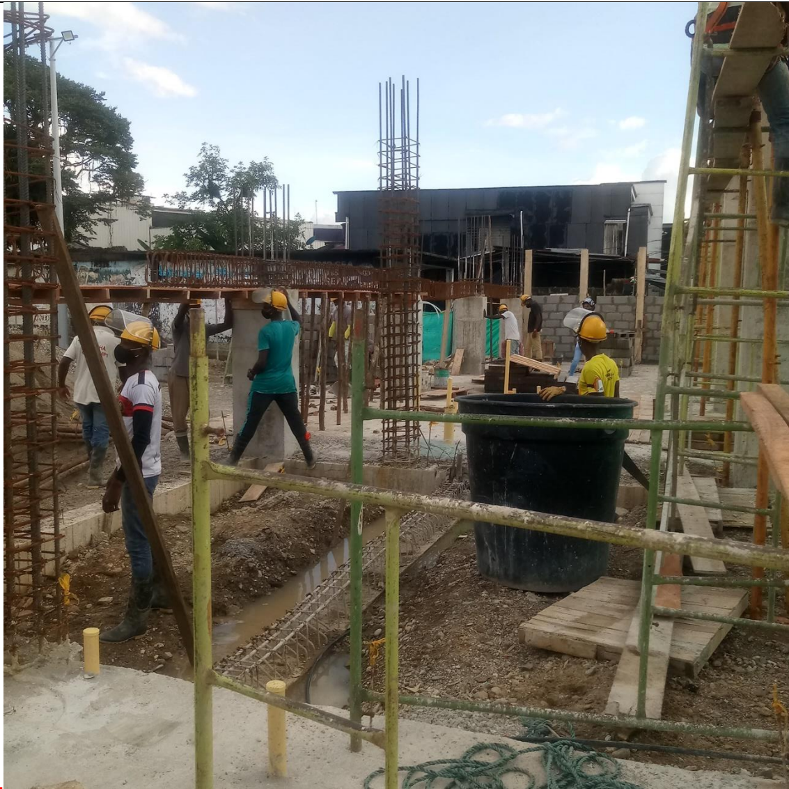
Foto No.20. Zona occidental. Construcción de graderías.
