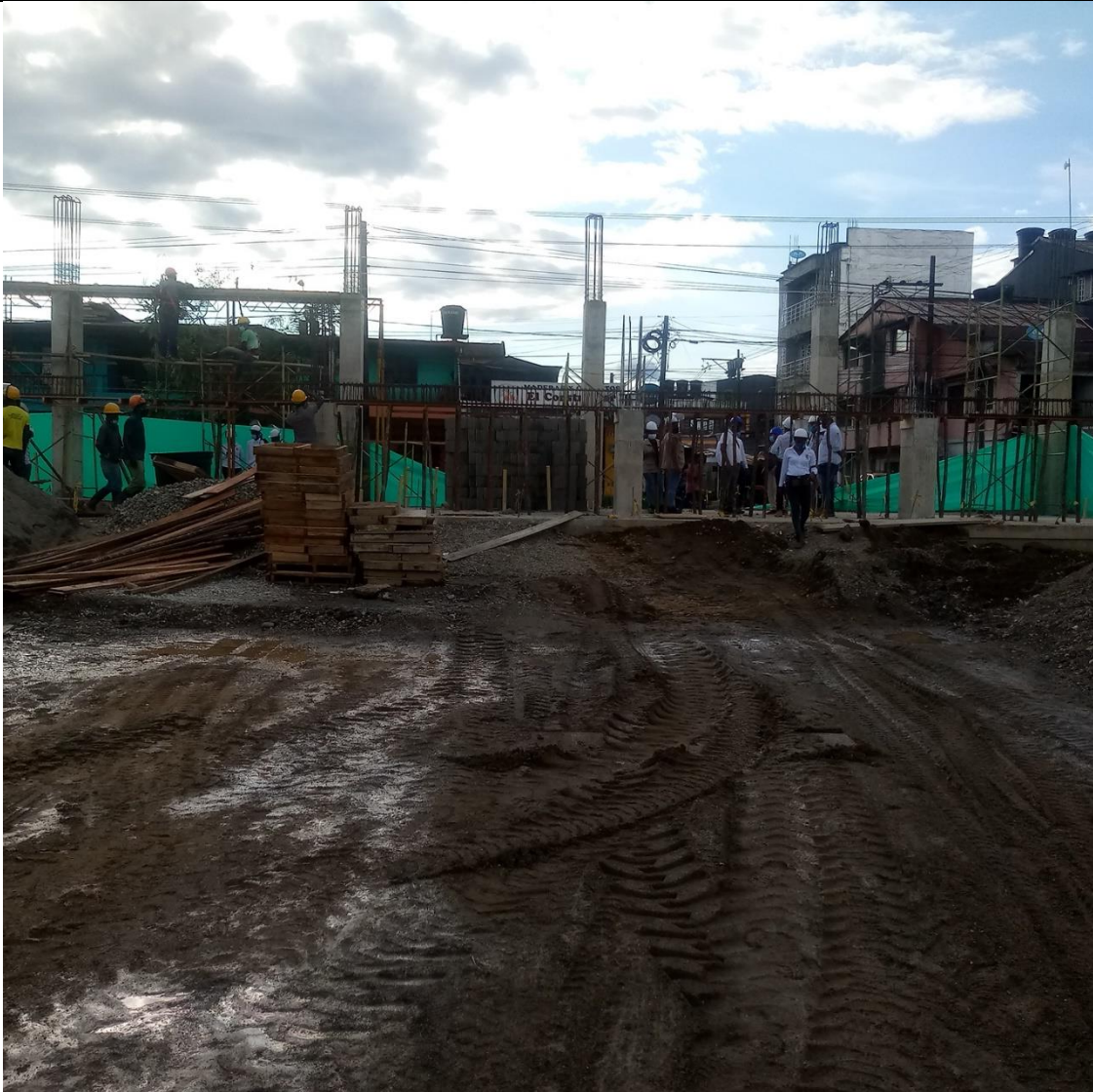
Foto No.21 Construcción de graderías y relleno de la cancha.
