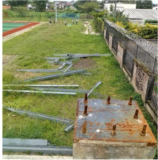
Foto No.28. Platina estructura metálica para cubierta de gradería. 21-07-2020.
