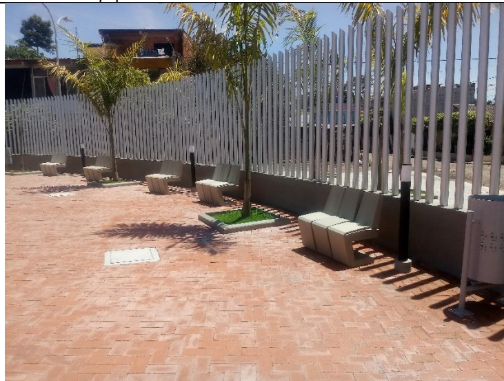
Foto No.16, zonas comunes, bancas y bolardos con luz. Foto: equipo auditor Oficina de Control Interno. 11-07-2019
