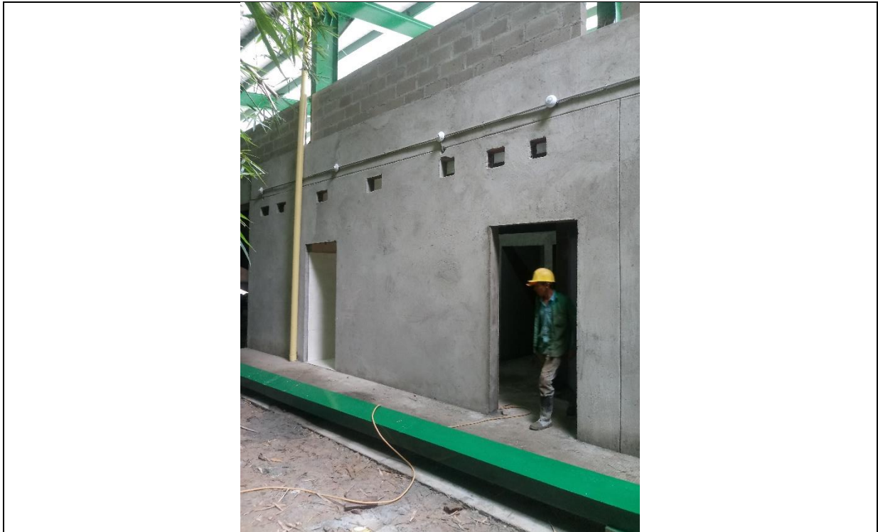
Foto No.7, Duchas hombres (entrada izquierda), duchas y baños mujeres (entrada derecha). Foto: equipo auditor Oficina de Control Interno. 10-07-2019
