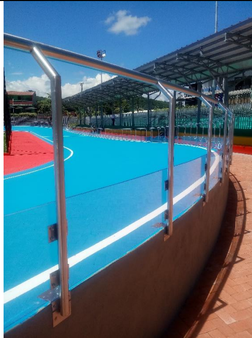
Fotos No.19, cerramiento perimetral pista de patinaje en policarbonato de 6mm. Foto: equipo auditor Oficina de Control Interno. 11-07-2019
