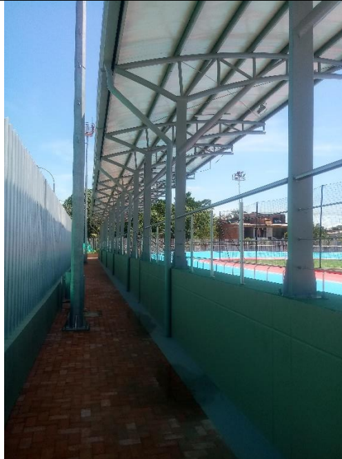
Fotos No.20, estructura y cubierta graderías. Foto: equipo auditor Oficina de Control Interno. 11-07-2019
