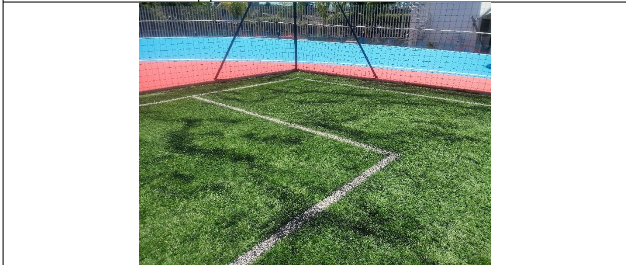
Fotos No.18, Campo sintético. Caucho granulado no uniforme Foto: equipo auditor Oficina de Control Interno. 11-07-2019
