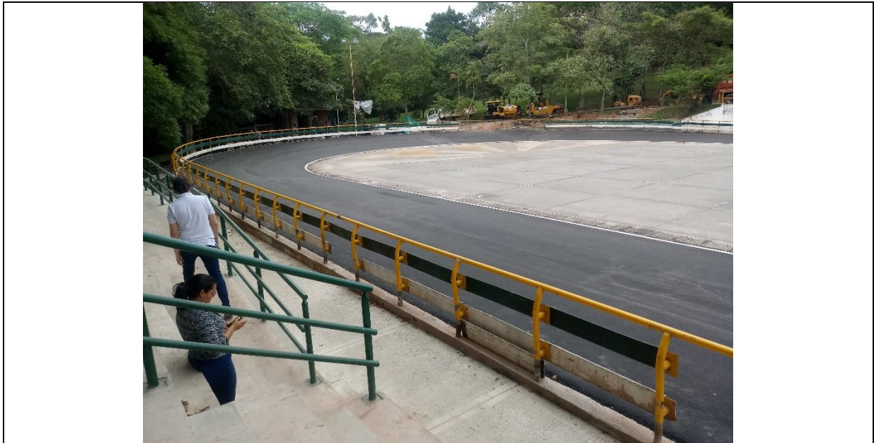
Foto No.5, Pista de patinaje en asfalto. Foto: equipo auditor Oficina de Control Interno. 10 -07-2019
