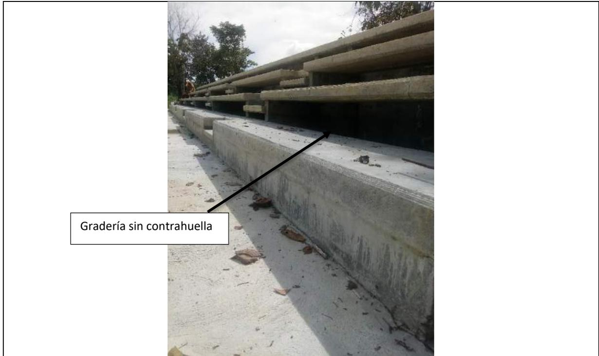
Foto No.7, Gradería sin contrahuella y drenaje.
