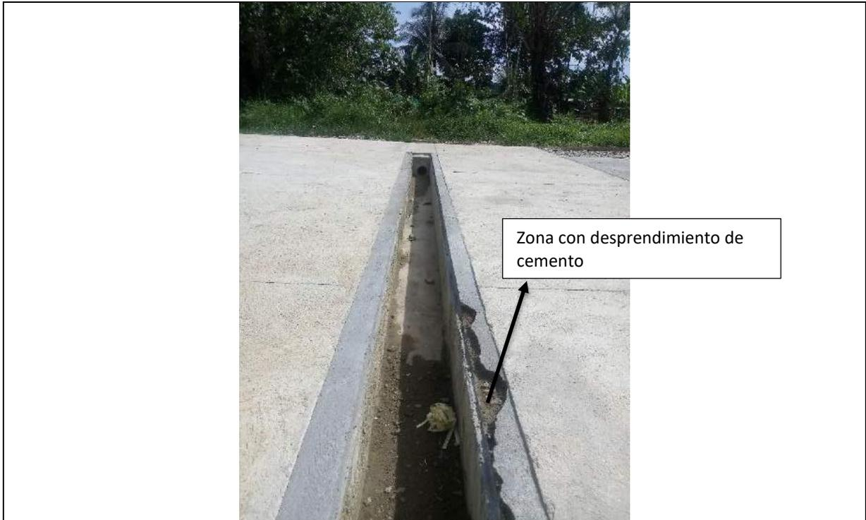
Foto No.5, cárcamo o canal de recolección de aguas lluvias cancha.
