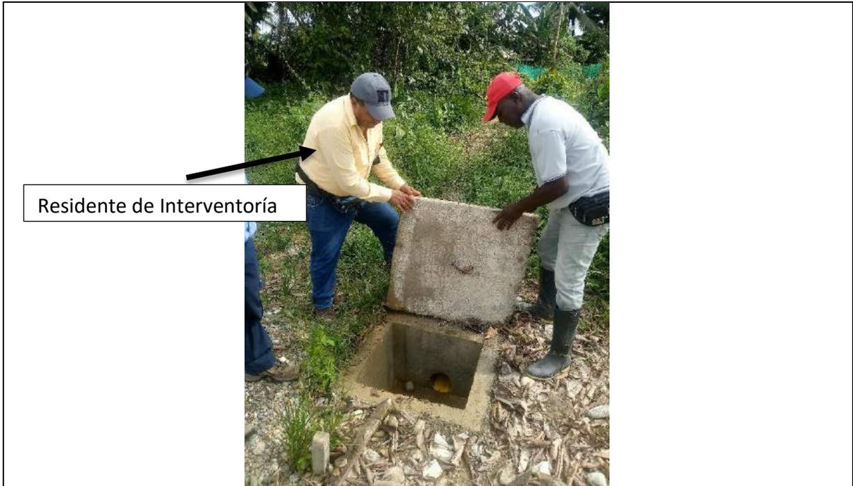
Foto No.13, Caja de inspección sistema recolección aguas lluvias.
