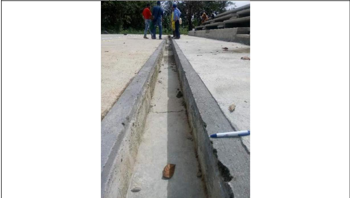
Foto No.6, cárcamo o canal de recolección de aguas lluvias cancha.
