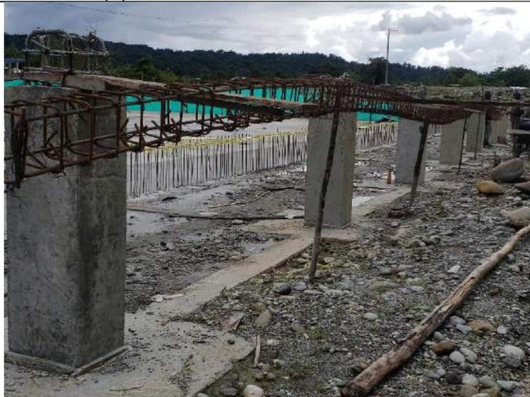
Foto No.18, Construcción viga cerramiento perimetral sobre columnas soportes graderías.
