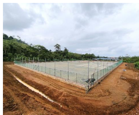
Fotografía 8. Vista general ortogonal del proyecto.
