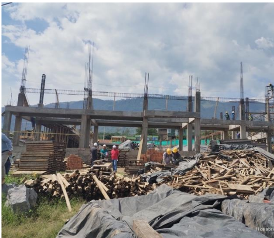
Fotografía 9. Vista general del interior del coliseo en construcción, hacia el suroccidente del predio.
