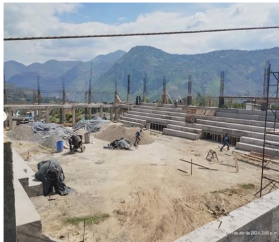
Fotografía 10. Vista general de la fachada sur del proyecto.
