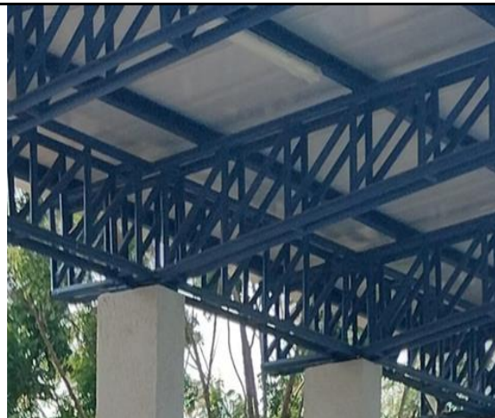
Fotografía 20. Falla en lámpara hermética de tubos – Gradería Sur. (imagen tomada por la CGR en la visita de abril de 2024)
