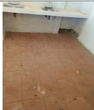
**10.2.27 TABLETA GRES LISO DE 33 x 33 MORTERO 1:4** en la instalación de la tableta. se evidencia desgaste en los materiales.
