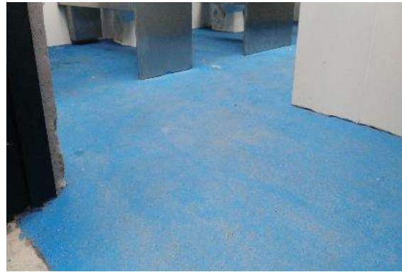
Foto No. 49: Detalle acabado placa de concreto baño mujeres segundo nivel de la gradería occidental.
