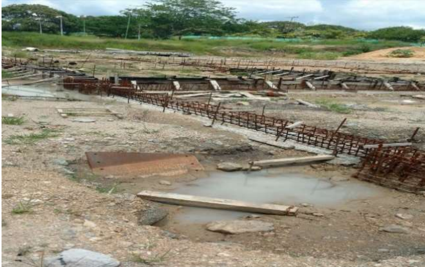
Foto No. 14: Estado de la obra - Edificio BMX (Pago total de la estructura metálica del edificio) Fuente: Equipo Auditor visita in situ
