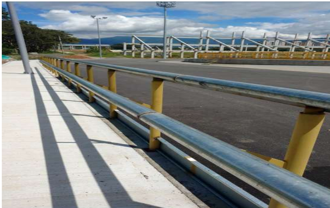
Foto No. 6: Estado de la obra - pista de ruta y edificio Fuente: Equipo Auditor visita in situ
