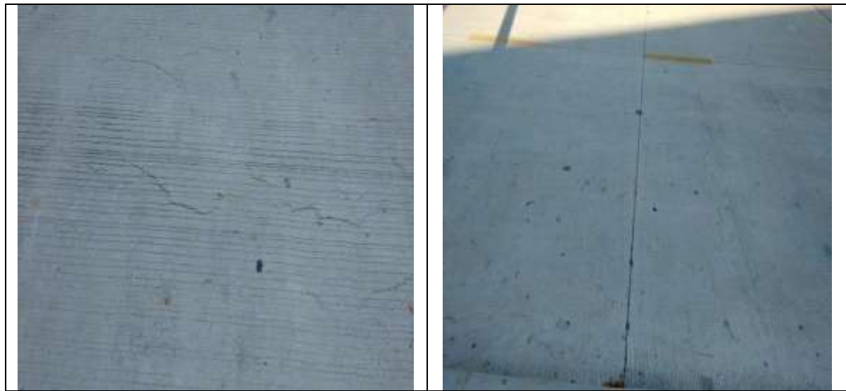
Foto No. 91: Placa de Contrapiso
