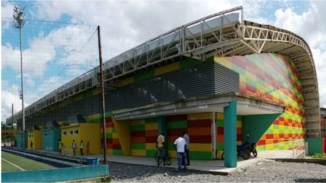
Foto No. 99: Fachada Principal Coliseo
