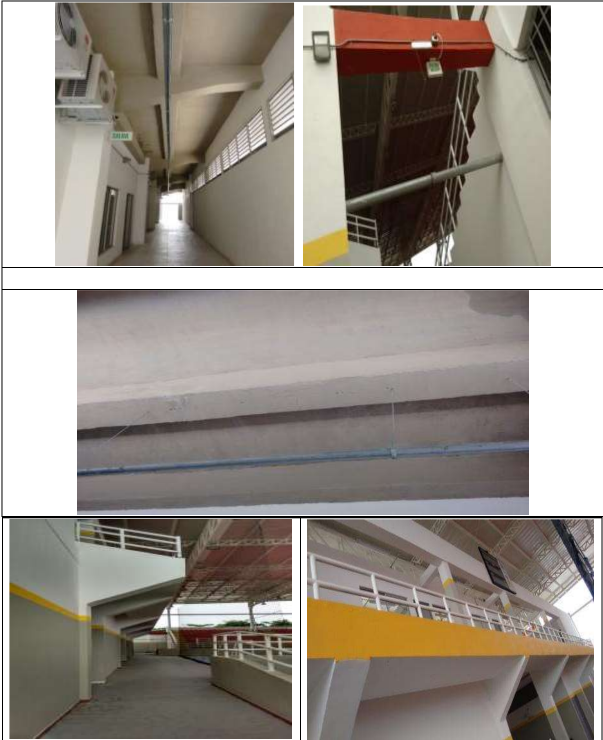
Foto No. 84: Columnas y vigas masilladas y pintadas
