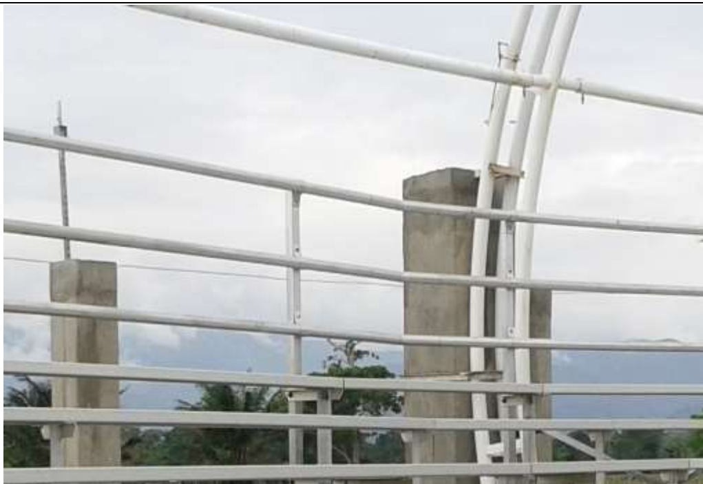
Foto No. 97: Columnas ejecutadas.
