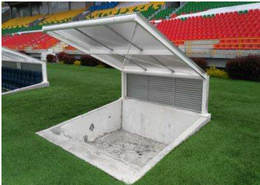
Foto No. 64: Vista general banco de árbitros.
