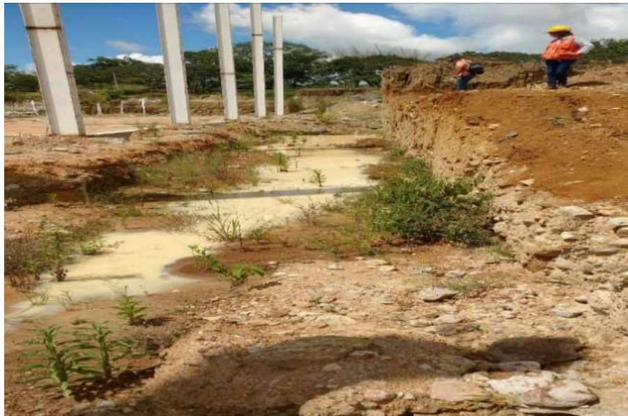
Foto No. 12: Estado de la obra - Edificio coliseo mayor Fuente: Equipo Auditor visita in situ
