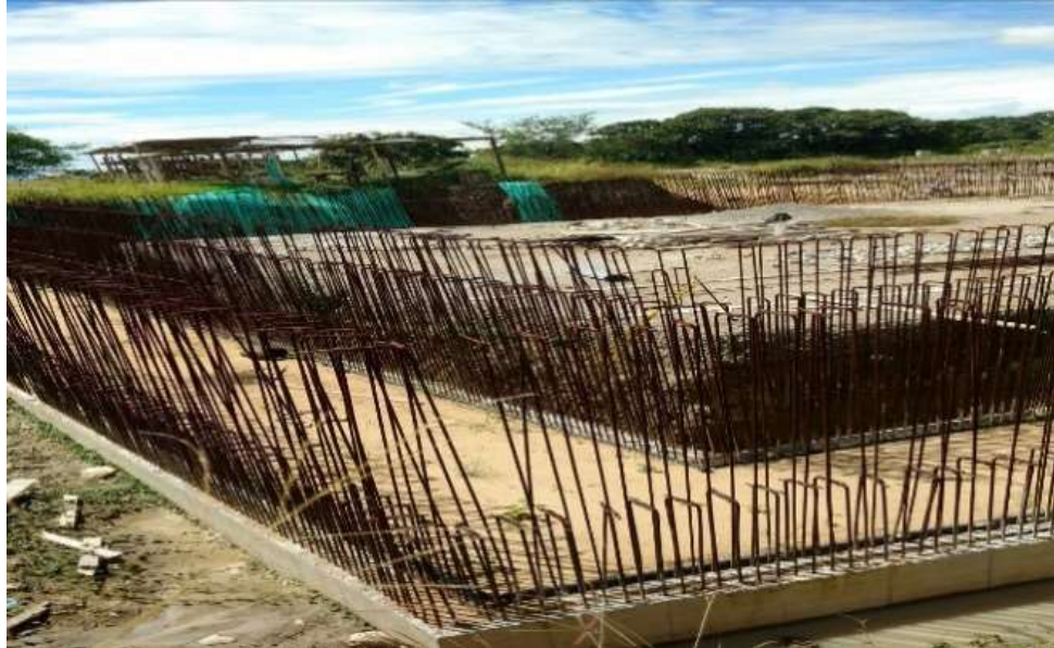
Foto No. 10: Estado de la obra - Piscina de calentamiento Fuente: Equipo Auditor visita in situ
