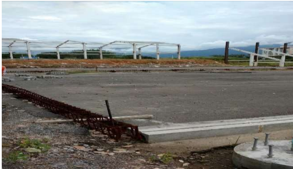
Foto No. 8: Estado de la obra - Canchas auxiliares 1 y 2 de tenis y edificio de squash Fuente: Equipo Auditor visita in situ
