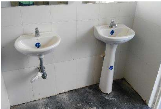
Foto No. 46: Detalle acabado placa de concreto baño de hombres tercer nivel de la gradería occidental.
