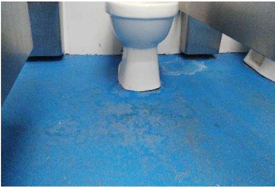
Foto No. 48: Detalle acabado placa de concreto baño mujeres segundo nivel de la gradería occidental.
