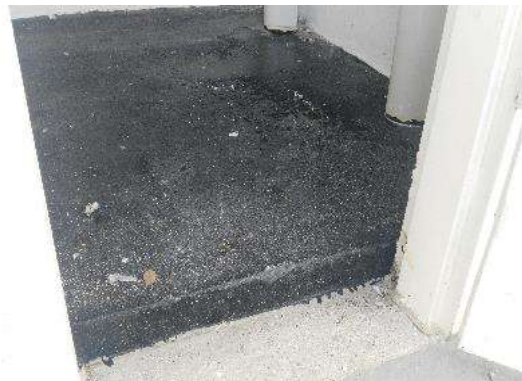
Foto No. 47: Detalle acabado placa de concreto baño costado norte, tercer nivel de la gradería occidental.
