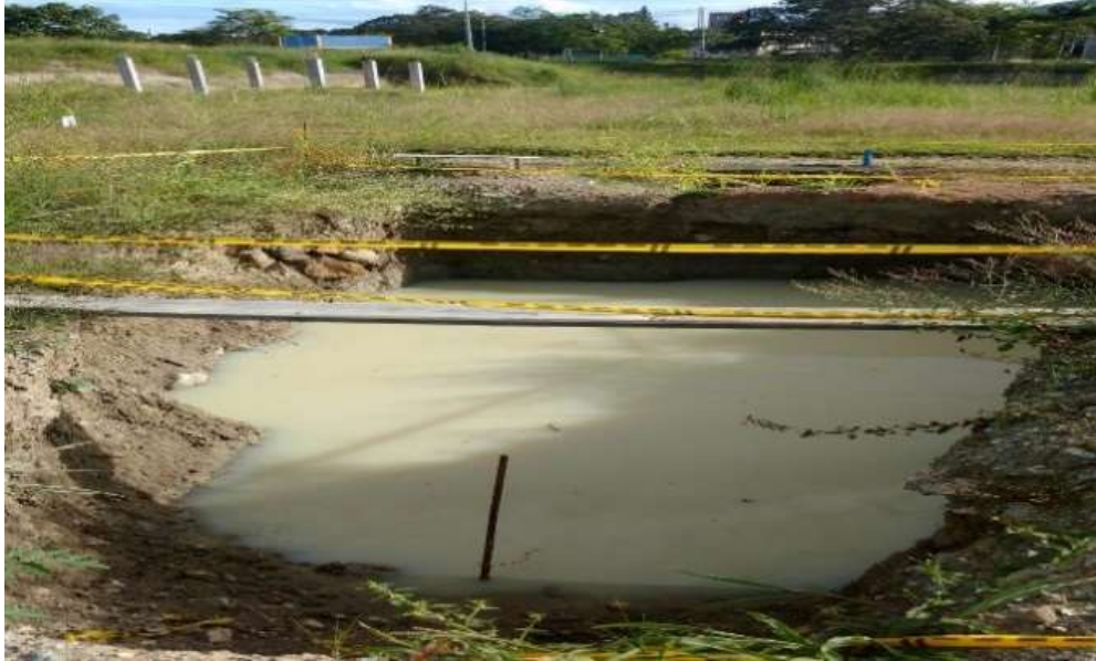
Foto No. 16: Estado de obra - Escenario softbol- Excavaciones en cancha Fuente: Equipo Auditor visita in situ
