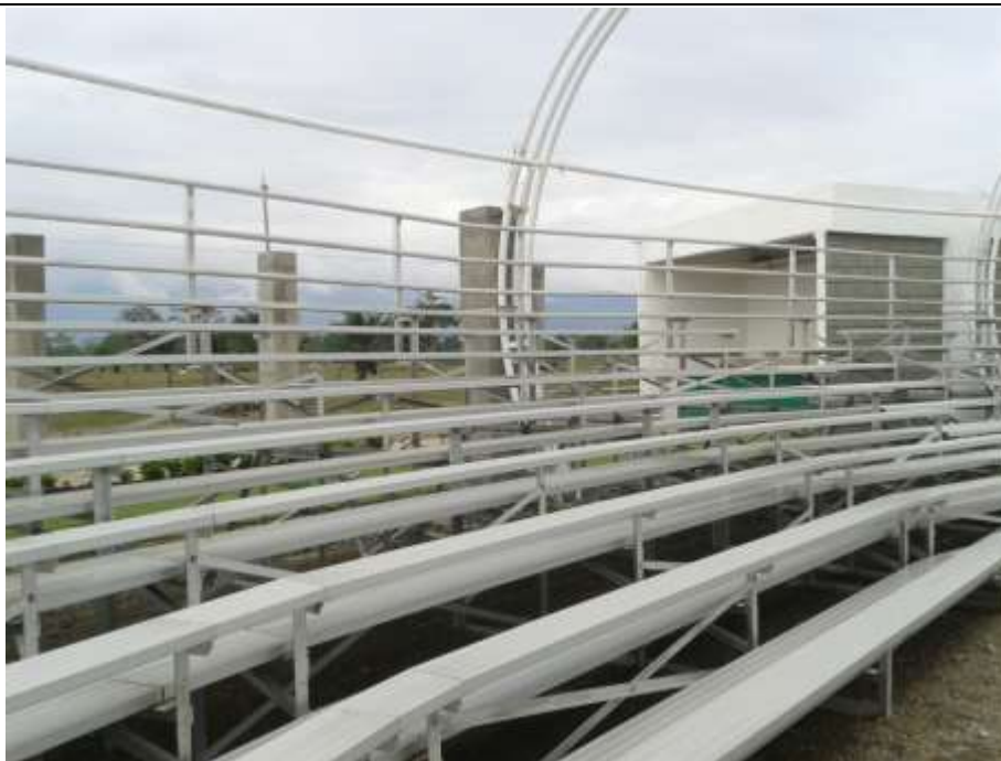
Foto No. 96: Graderías en aluminio y acero.
