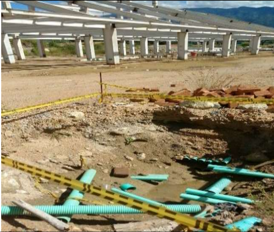
Foto No. 4: Estado de las obras - Edificio Atletismo y pista de atletismo Fuente: Equipo Auditor visita in situ
