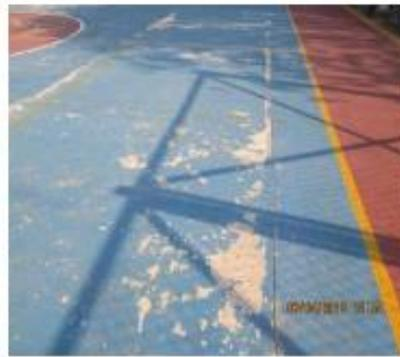
Fotografía 135. Muestra desprendimiento de pintura de la cancha multifuncional.
