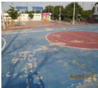
Fotografía 136. Muestra desprendimiento de pintura de la cancha multifuncional.
