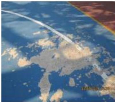
Fotografía 134. Muestra desprendimiento de pintura de la cancha multifuncional.
