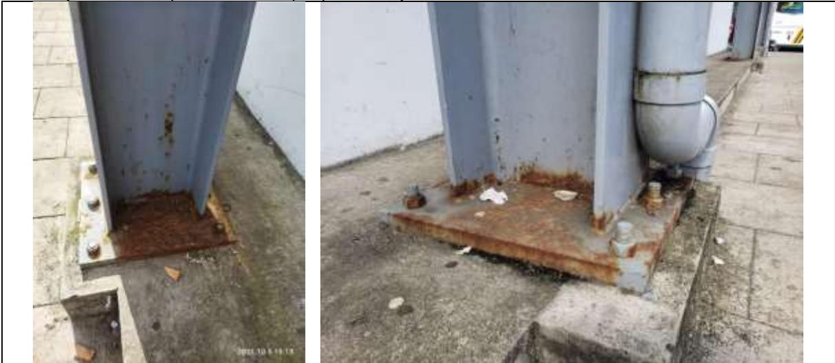
Se evidencia corrosión en pedestales de columnas de estructura de la cubierta de la placa polideportiva.
