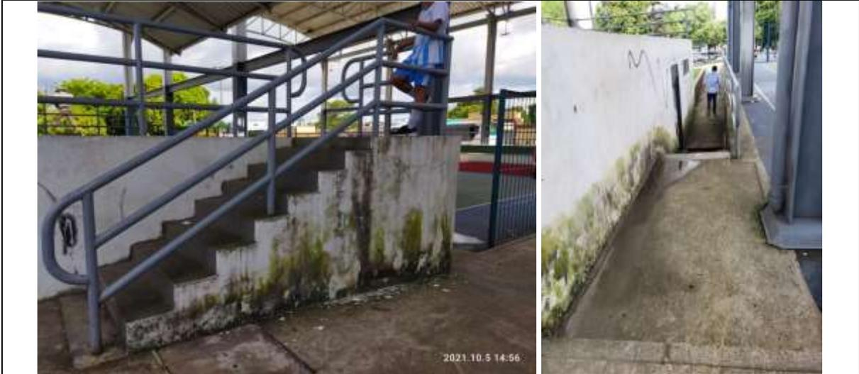
Se evidencia humedad en muros exteriores de batería de baños y en escaleras de acceso a tarima.
