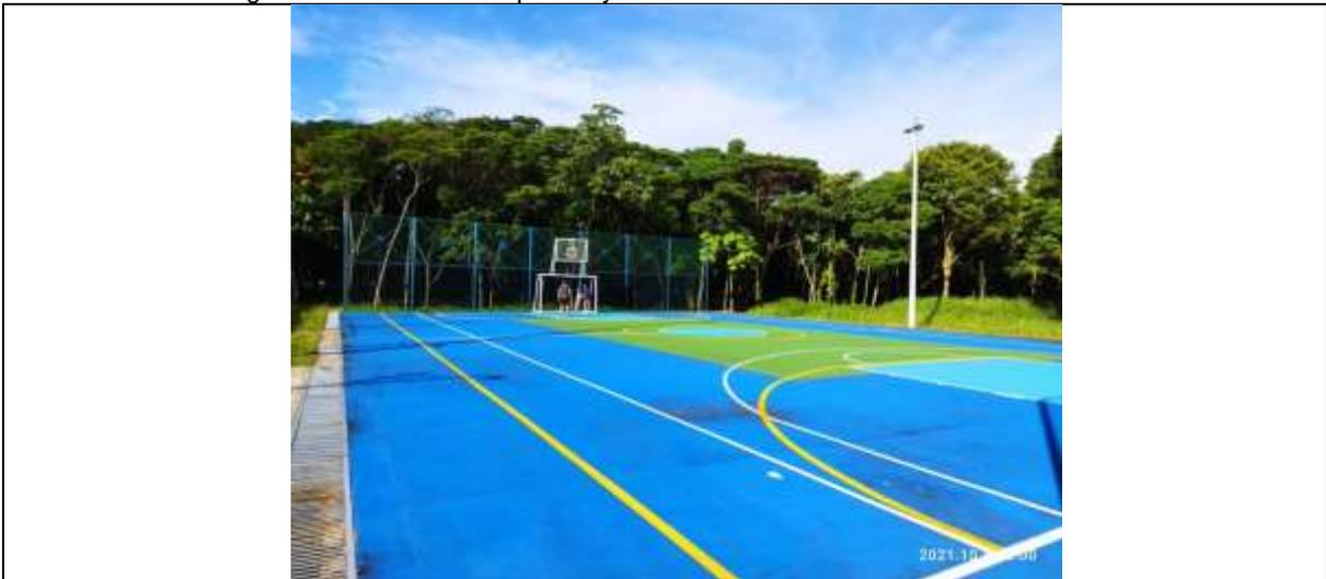
Se evidencia variación de color en recubrimiento sintético del acabado final de la superficie de la placa polideportiva.
