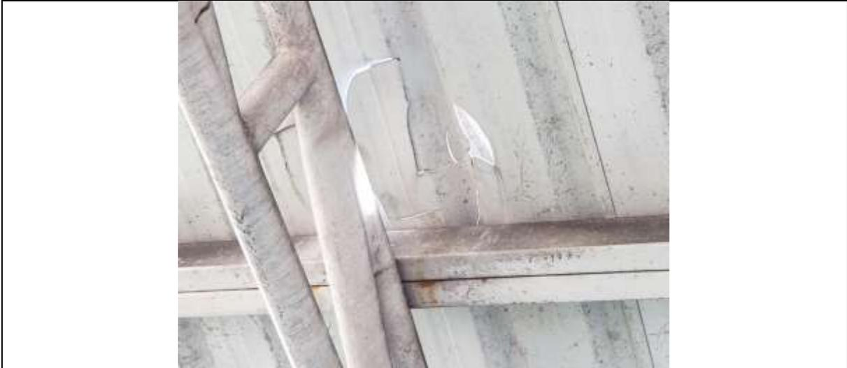
Se evidencia perforación en teja termo acústica que descansa sobre correa, lo que ya esta generando corrosión en la estructura de la cubierta de la placa polideportiva.
