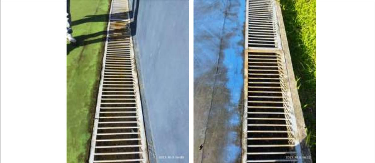
Se evidencia corrosión en diferentes áreas de las rejillas del cárcamo (cuneta).
