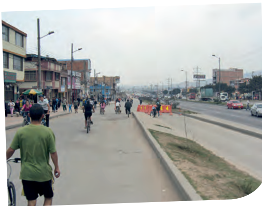
Foto 12. Tramo paralelo a la Autopista Sur de la Ciclovía de Soacha
