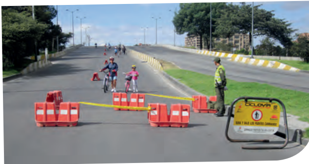
Foto 33. Reductores de velocidad en la Ciclovía de Bogotá
